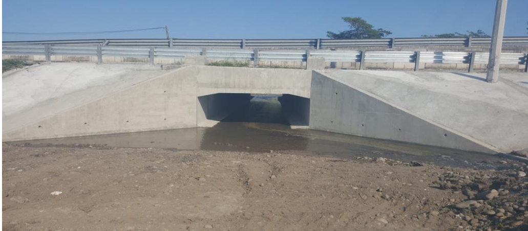
Figura 5.7 (m) Alero de la alcantarilla P.S.V. San Isidro, fuente cortesía de la empresa Freyssinet de México.
