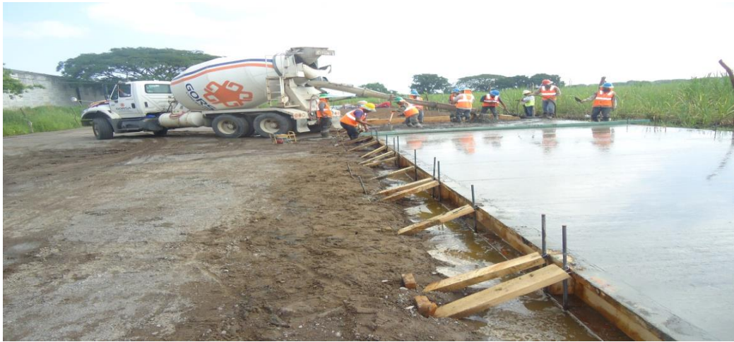
Figura 5.1 (a) Patio de fabricación de los Cajones Techspan. fuente obtenida por la empresa
