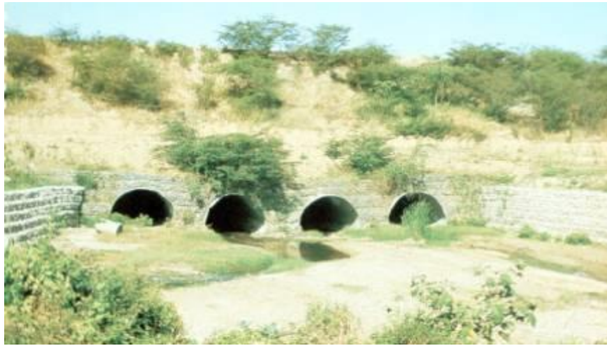
Fotografía 2.4.(i). Batería de alcantarillas abovedada Fuente: Maccaferri
