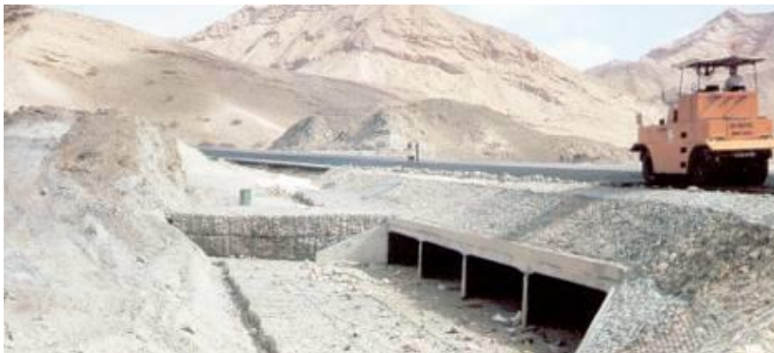
Fotografía 2.4.(n) Alcantarillas Cajón de concreto Armado Fuente: Maccaferri
