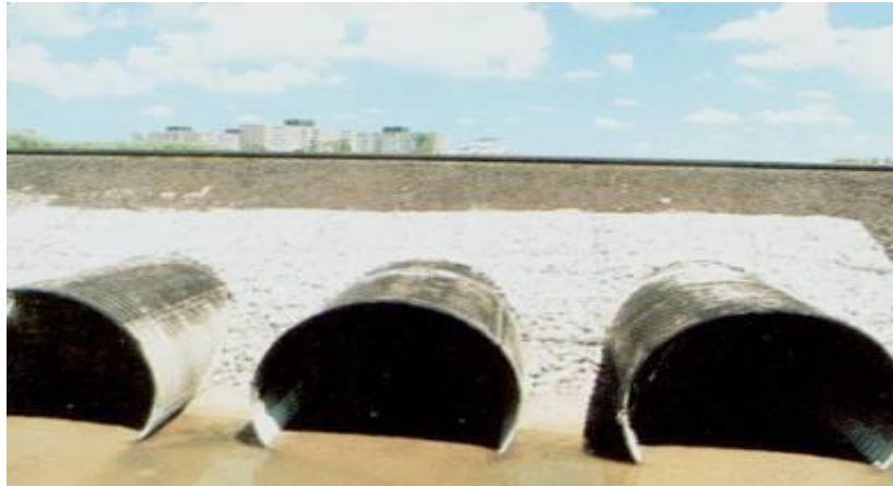
Fotografía 2.4.(j) Batería de alcantarillas abovedada Fuente: Maccaferri
