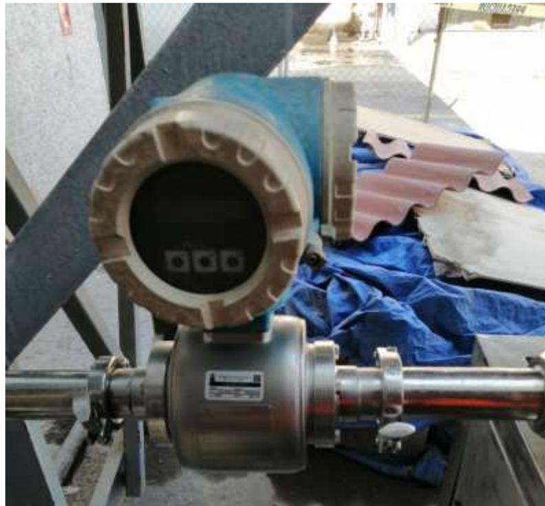
**Figura 11.** Transmisor empleado en el medidor de flujo de efecto Coriolis. Fuente: Tomada en campo, 2021.
