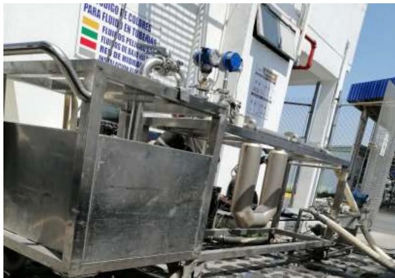
**Figura 17.** Medidor de flujo de efecto Coriolis operando. Fuente: Tomada en campo, 2021.
