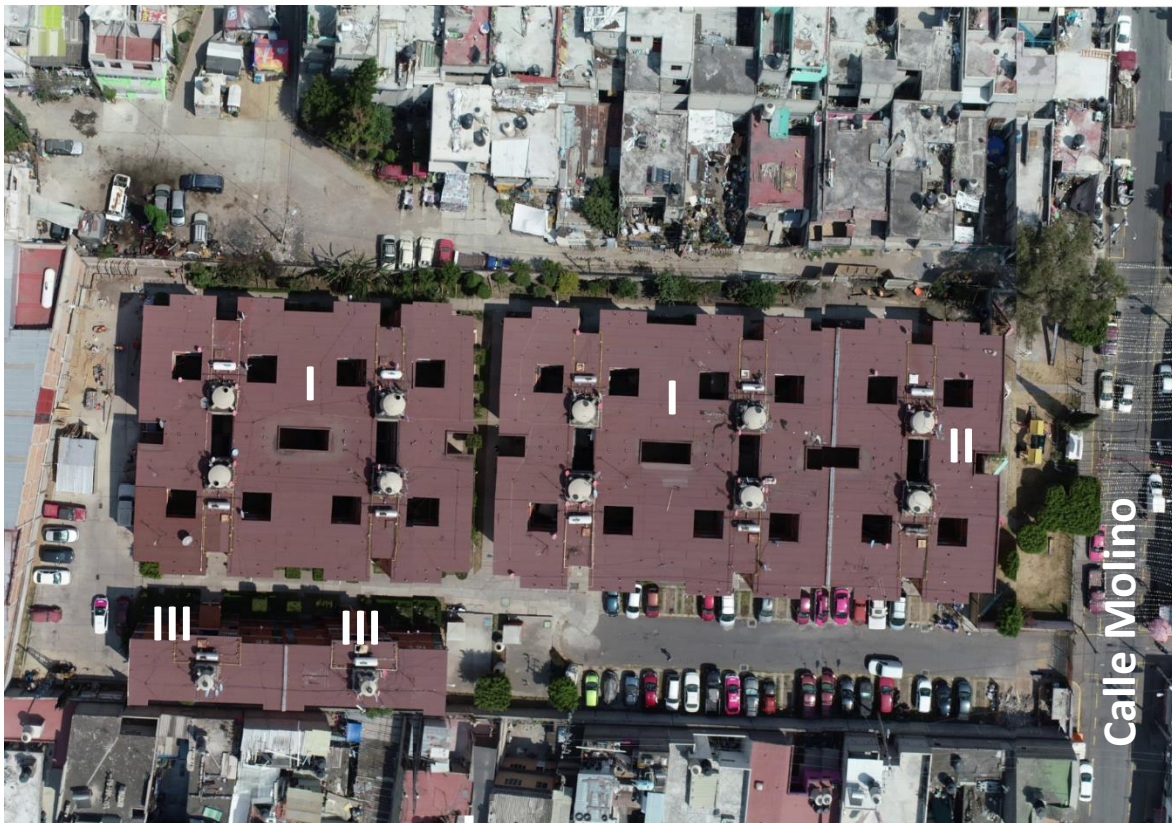
Figura 31. Vista aérea de la Unidad Habitacional Molino 25, se observan los módulos y las colindancias de la unidad (Obtenido de PRO-GPIC & BROS, S.A. de C.V., 2020).
