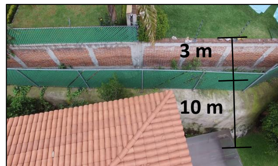
Figura 3- 9 Altura de talud y pared perimetral.
