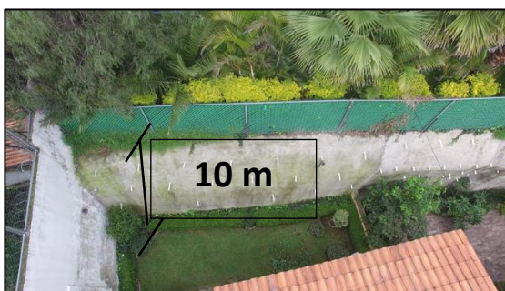
Figura 3- 10 Altura de talud.
