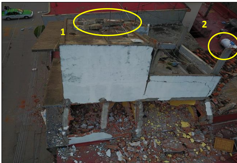
Figura 3- 21 Vivienda colapsada en Juchitán, Oaxaca. Se observa peso muerto (1) del lado del colapso y un tanque de gas LP (2) en la casa de atrás.
