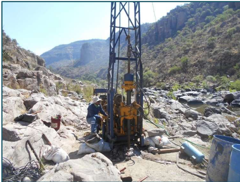
Figura 5.25. Ejecución de trabajos de perforación en el barreno SR-16
