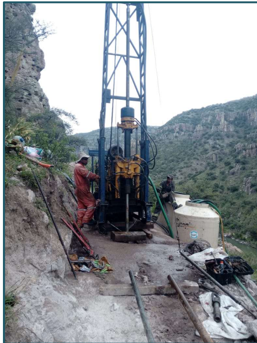
Figura 5.23. Ejecución de trabajos en el sondeo vertical SR-14
