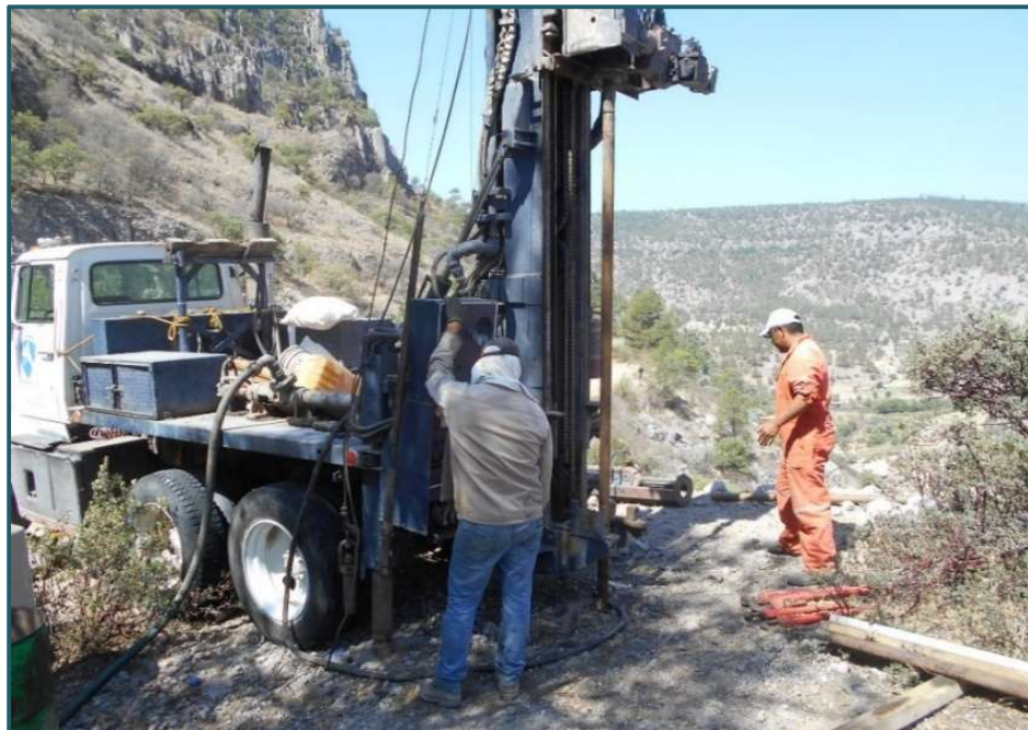
Figura 5.24. Barreno SR-15 ubicado en la margen derecha de la cortina proyectada.
