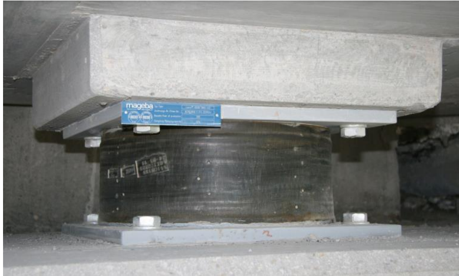
Figura 8. Aislador sísmico de base tipo elastomérico.
