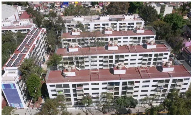
Figura 4.8 Ejemplo de edificios con obra de rehabilitación concluida en el Multifamiliar Tlalpan (Pantoja, 2020).
