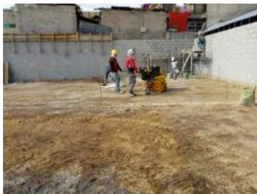
Ilustración 23. Compactación de material base con rodillo compactador. Fotografía tomada por autor, 2018
