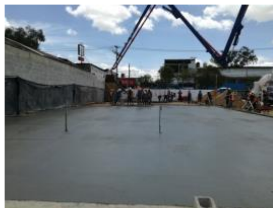
Ilustración 42. Firme acabado allanado Fotografía tomada por autor, 2018
