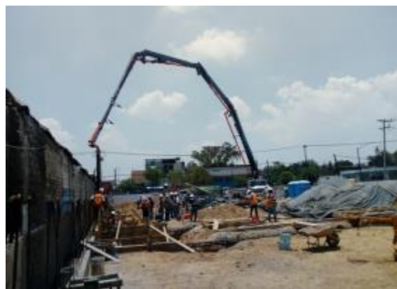
Ilustración 18. Vaciado de concreto por medio de bomba telescópica Fotografía tomada por autor, 2018
