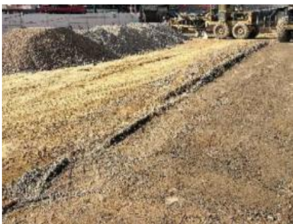
Ilustración 12. Se cierran terracerías en plataforma última capa de base hidráulica fotografía tomada por autor, 2018
