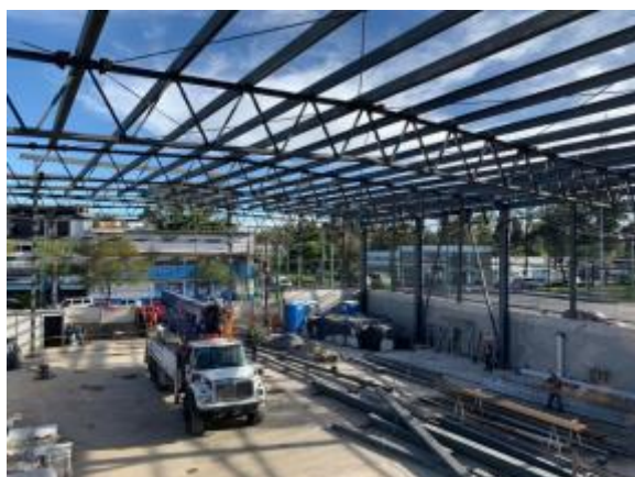
Ilustración 31. Montaje de armaduras con grúa en sitio Fotografía tomada por autor, 2018
