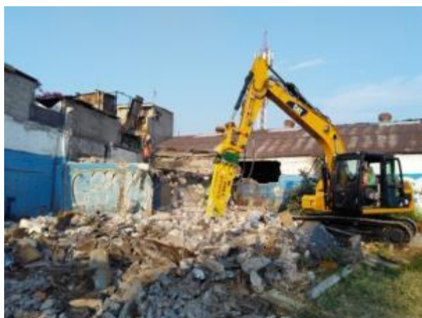
Ilustración 3. Demolición de muros, fotografía tomada por autor, 2018
