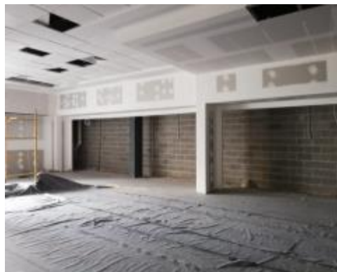
Ilustración 60. Colocación de faldón fotografía tomada por autor, 2018
