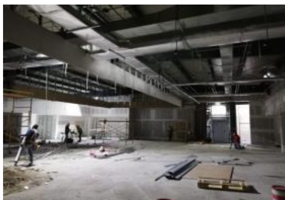
Ilustración 54. Ductos de inyección en tienda fotografía tomada por autor, 2018
