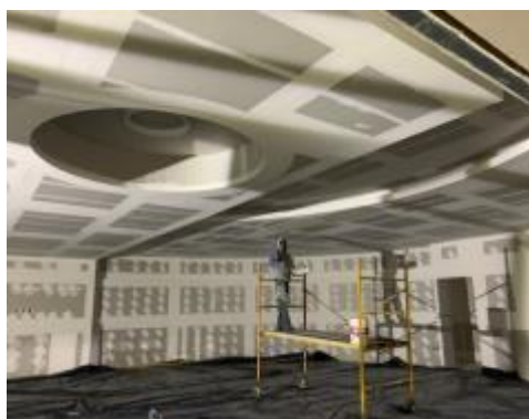
Ilustración 61. Colocación de plafón liso fotografía tomada por autor, 2018
