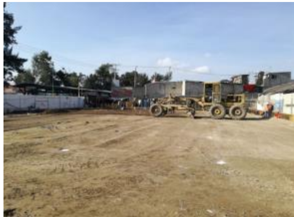
Ilustración 11. Base terminada, fotografía tomada por autor, 2018
