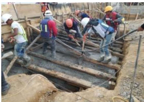
Ilustración 19. Colado de zapata corrida y vibrado de concreto Fotografía tomada por autor, 2018
