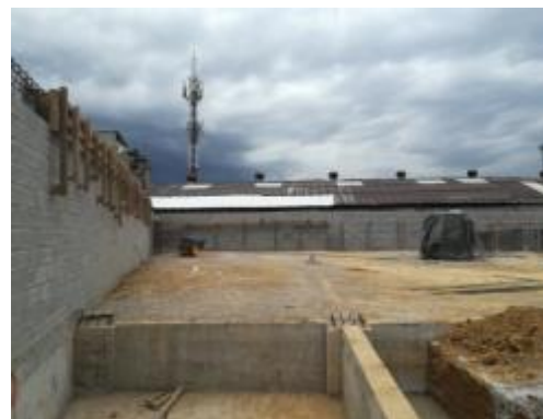
Ilustración 24. Conformación de nivel de terracería para colocación de firme Fotografía tomada por autor, 2018
