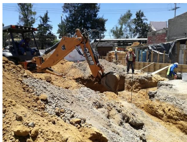
Ilustración 9. Corte del terreno para zapata aislada con retroexcavadora, fotografía tomada por autor, 2018
