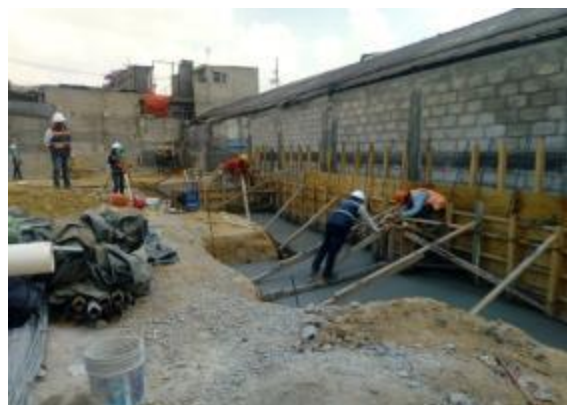
Ilustración 20. Revisión de elementos antes, durante y después de colado con topografía Fotografía tomada por autor, 2018
