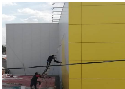
Ilustración 76. Acabado fachada lateral fotografía tomada por autor, 2018
