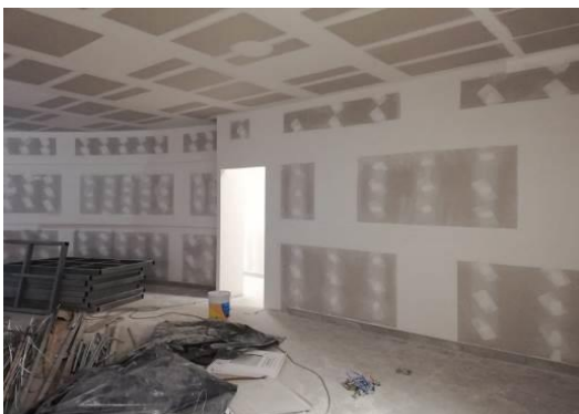
Ilustración 58. Colocación de muro tabla roca fotografía tomada por autor, 2018
