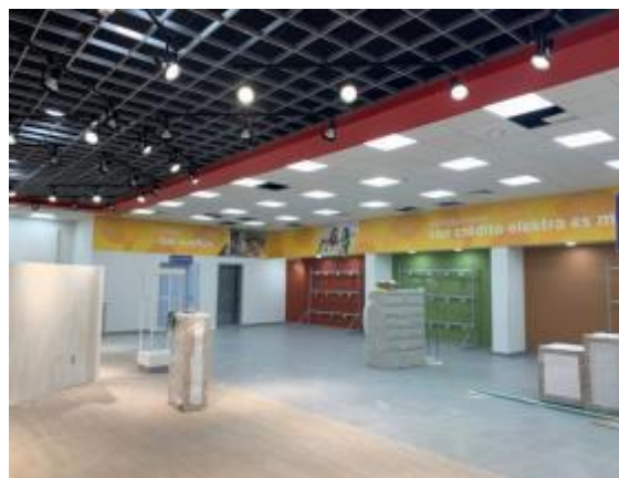
Ilustración 65. Acabado pintura en muros fotografía tomada por autor, 2018
