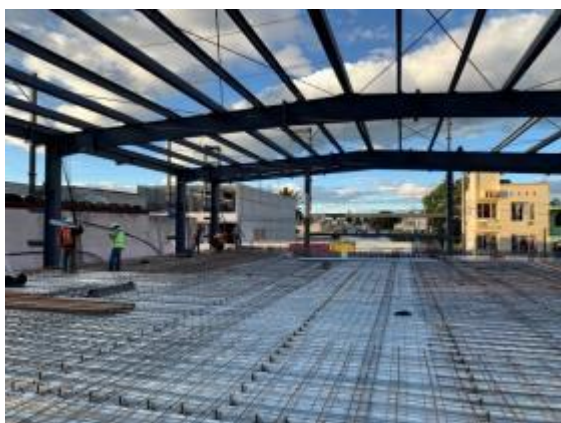
Ilustración 33. Colocación de losacero y conectores Fotografía tomada por autor, 2018
