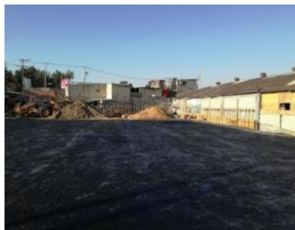
Ilustración 13. Riego de liga con emulsión catiónica tipo ECR-60ª razón de 0.6 lt/m2 fotografía tomada por autor, 2018
