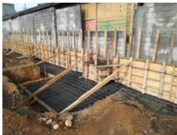
Ilustración 16. Armado y cimbrado de zapata corrida, dados y zapata Fotografía tomada por autor, 2018
