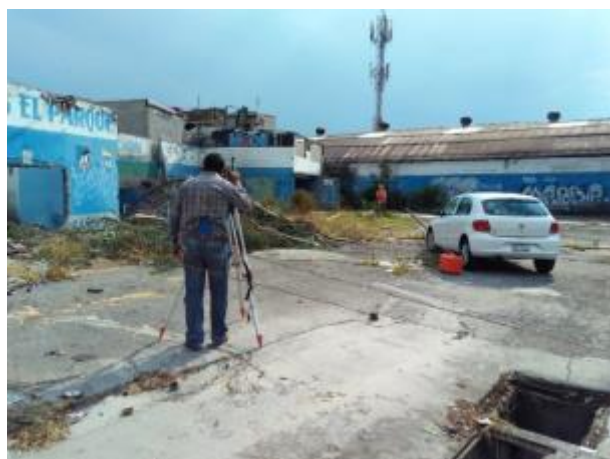
Ilustración 5. Levantamiento topográfico poligonal de la obra, fotografía tomada por autor, 2018
