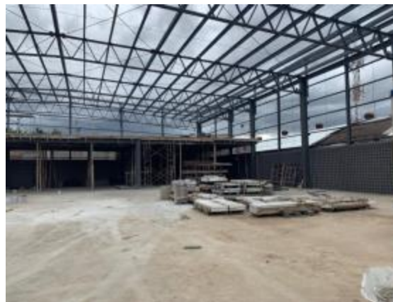
Ilustración 30. Marcos rígidos por ejes Fotografía tomada por autor, 2018
