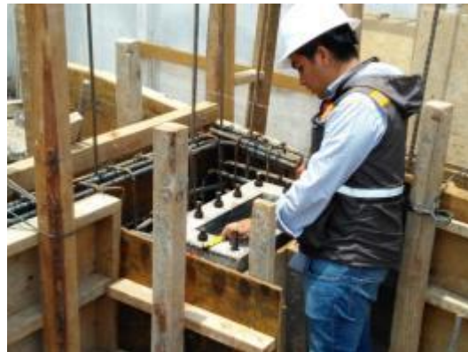
Ilustración 26. Revisión de anclas previo al colado de dado de cimentación Fotografía tomada por autor, 2018
