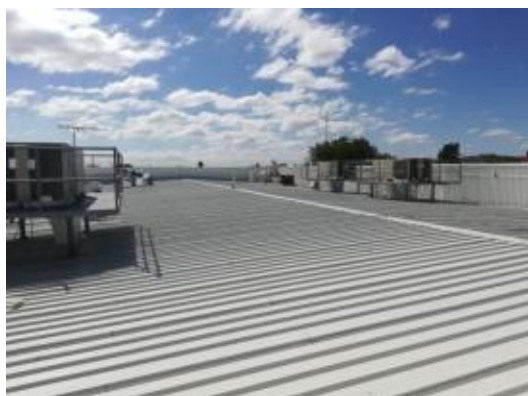
Ilustración 37. Cubierta terminada Fotografía tomada por autor, 2018
