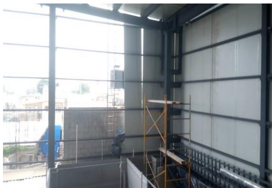
Ilustración 75. Instalación multymuro fotografía tomada por autor, 2018
