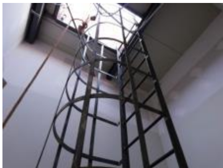
Ilustración 45. Escalera marina Fotografía tomada por autor, 2018
