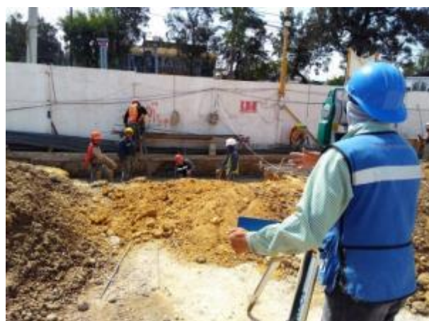
Ilustración 6. Nivel topográfico en cimentación, fotografía tomada por autor, 2018
