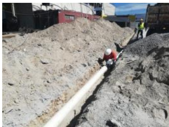
Ilustración 52. Instalación sanitaria red principal, fotografía tomada por autor, 2018
