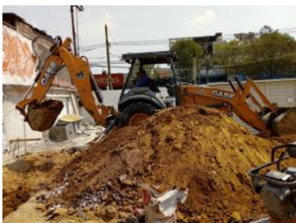
Ilustración 8. Excavación del terreno para cimentación con retroexcavadora, fotografía tomada por autor, 2018
