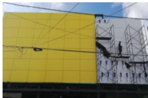
Ilustración 74. Panel de aluminio fotografía tomada por autor, 2018
