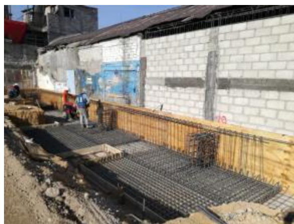
Ilustración 14. Armado de zapata corrida y dados Fotografía tomada por autor, 2018
