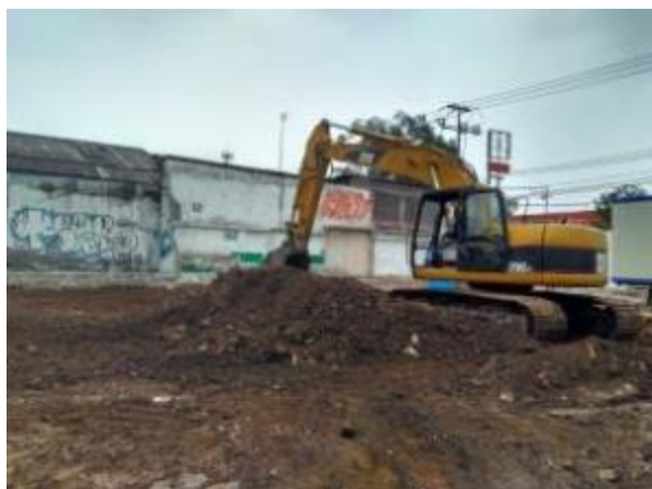
Ilustración 7. Despalme del terreno con excavadora oruga, fotografía tomada por autor, 2018
