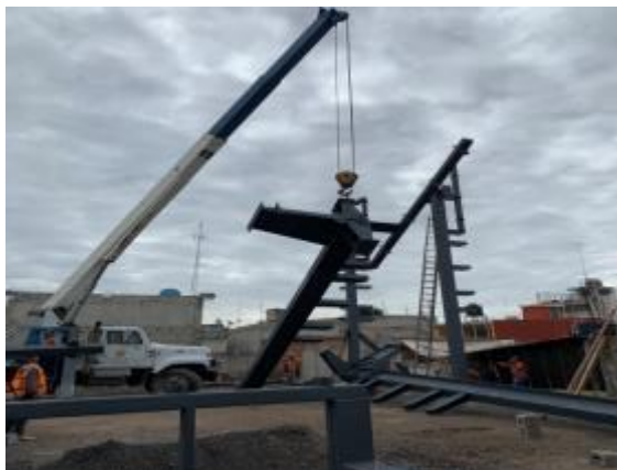
Ilustración 29. Montaje de columnas con grúa en sitio Fotografía tomada por autor, 2018
