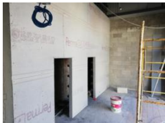
Ilustración 59. Colocación de muro durock fotografía tomada por autor, 2018
