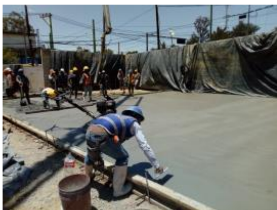
Ilustración 41. Colado de firme Fotografía tomada por autor, 2018
