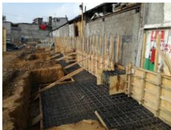
Ilustración 15. Armado y cimbrado de zapata corrida, dados y zapata Fotografía tomada por autor, 2018
