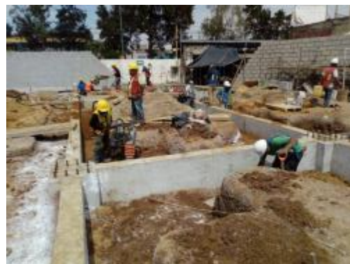
Ilustración 22. Relleno y compactación de material base en celdas de cimentación Fotografía tomada por autor, 2018
