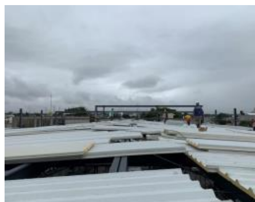
Ilustración 36. Colocación de techumbre Fotografía tomada por autor, 2018
