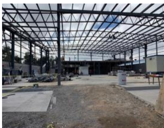
Ilustración 32. Montaje de armaduras, vigas y montenería en general Fotografía tomada por autor, 2018
