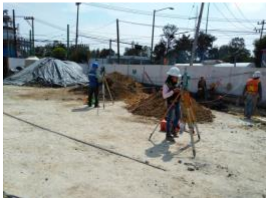
Ilustración 25. Revisión topográfica de puntos de anclaje Fotografía tomada por autor, 2018
