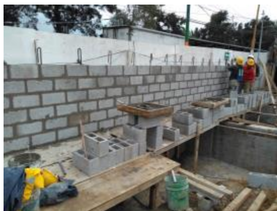
Ilustración 39. Colocación muro perimetral Fotografía tomada por autor, 2018
