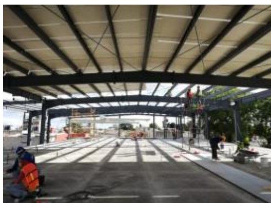
Ilustración 35. Montaje de cubierta Fotografía tomada por autor, 2018
