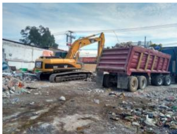
Ilustración 4. Demolición y retiro de firme de concreto, fotografía tomada por autor, 2018
