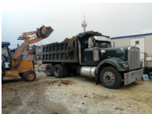
Ilustración 21. Retiro de material producto de excavación Fotografía tomada por autor, 2018
