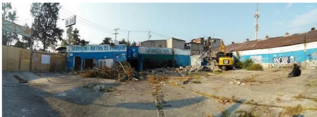
Ilustración 2. Desenraice de vegetación existente, fotografía tomada por autor, 2018
