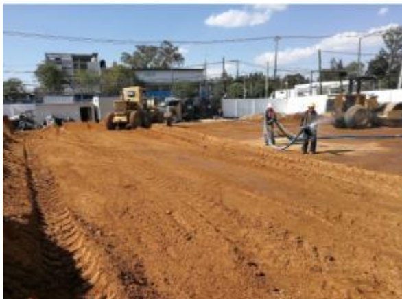
Ilustración 10. Conformación de capa subrasante, fotografía tomada por autor, 2018
