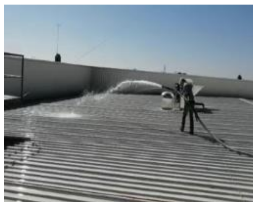
Ilustración 38. Prueba de hermetismo Fotografía tomada por autor, 2018
