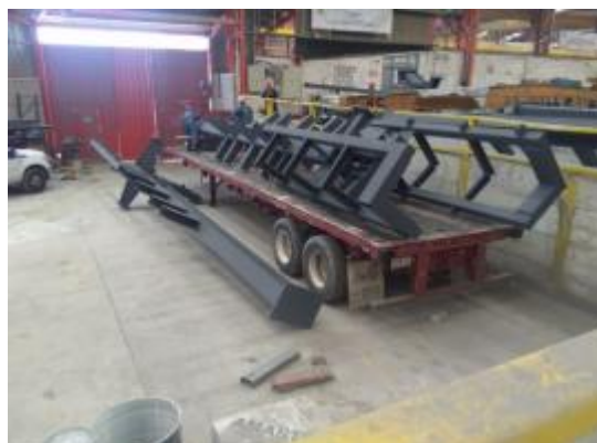
Ilustración 28. Embarque estructura metálica Fotografía tomada por autor, 2018
