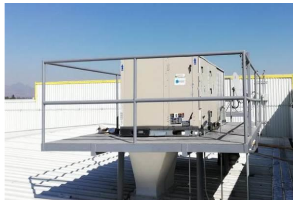
Ilustración 55. Unidad paquete AA fotografía tomada por autor, 2018
