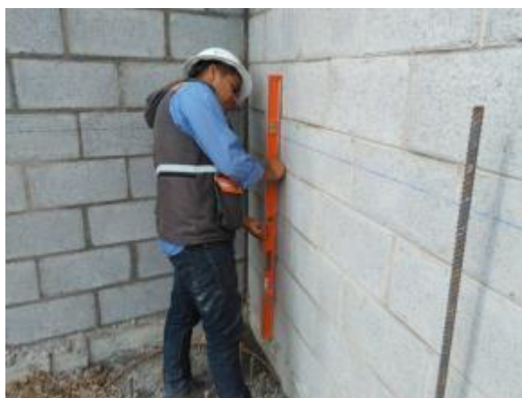
Ilustración 40. Revisión de alineamiento de muro Fotografía tomada por autor, 2018
