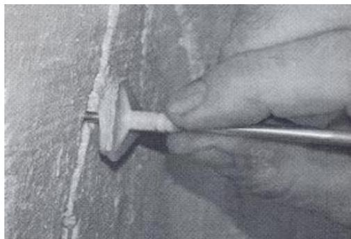
**Figura 27 Colocación de boquillas con el método de superficie (Trout, 2006)**
