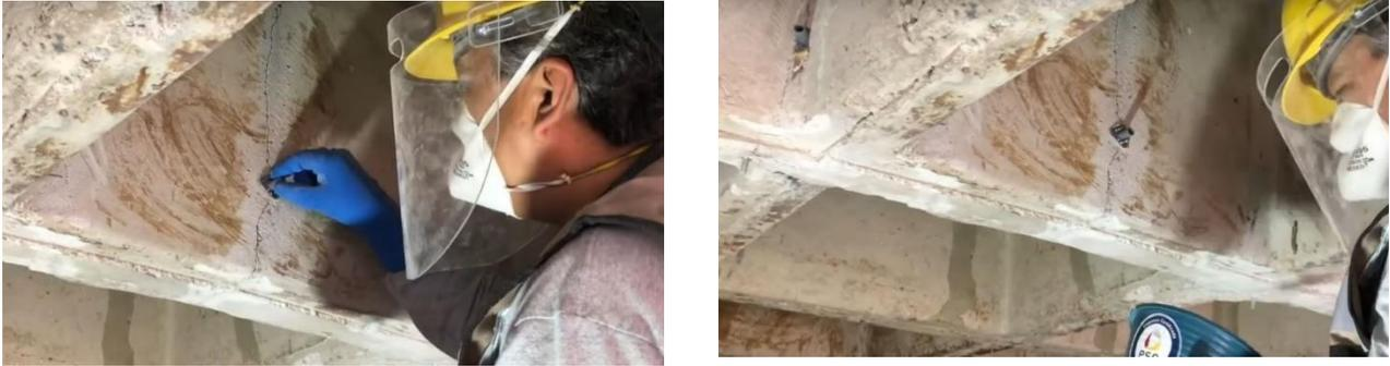
**Figura 28 Colocación de boquillas plásticas con base, utilizando el método de superficie (PSC México, 2020)**
