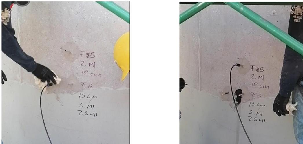
**Figura 65 Procedimiento de inyección en columnas de la L12 del Metro de la CDMX (Abarca, 2021)**
