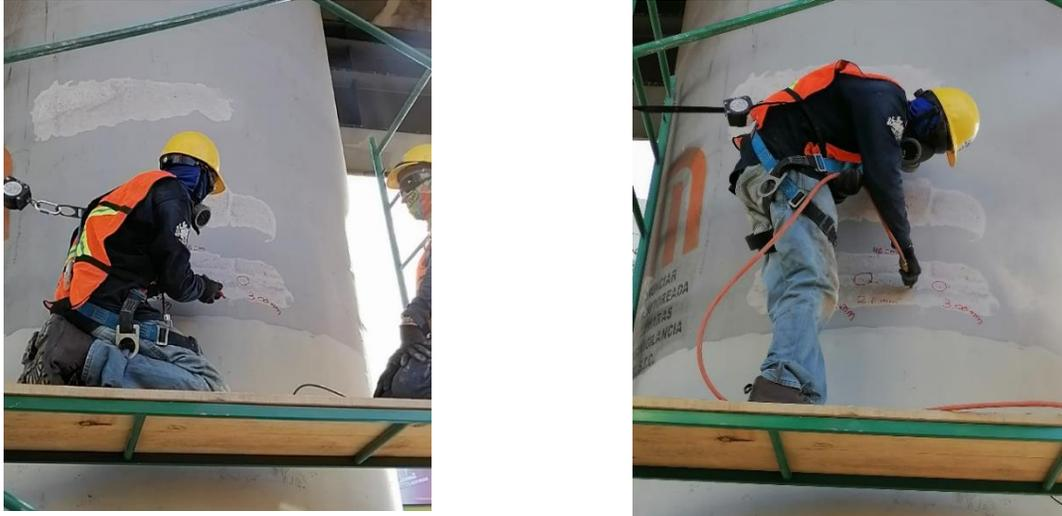
**Figura 62 Identificación y limpieza de las grietas en columnas de la L12 del Metro de la CDMX (Abarca, 2021)**
