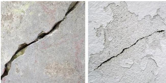
a) *Grieta antes y después del retiro del recubrimiento*
