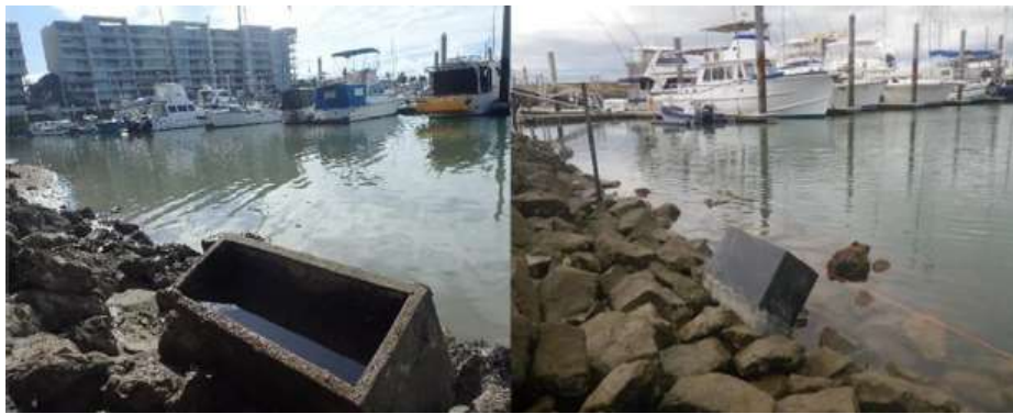
Figura 11. Estructuras huecas para fomento de microhábitats direccionadas 45^{\circ} desde la vertical hacia tierra adentro y hacia mar adentro respectivamente (Waltham et al., 2018).
