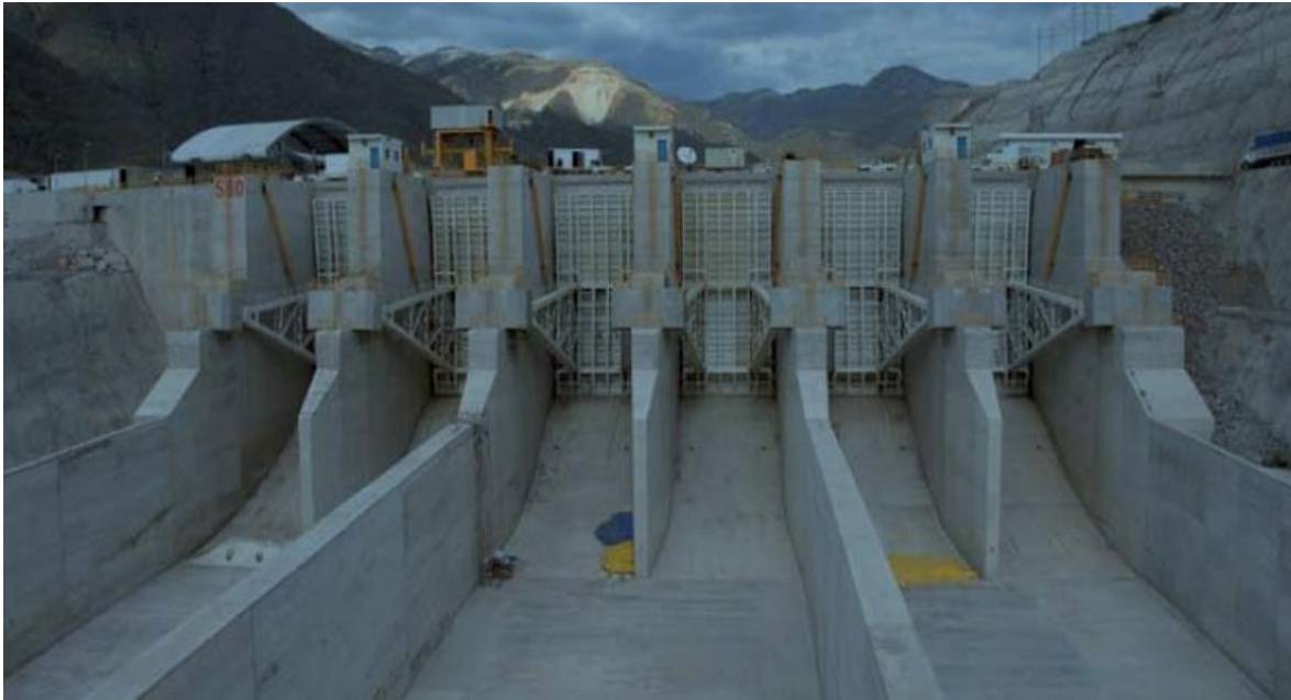
Figura 3.5: EJEMPLO DE OBRA DE EXCEDENCIAS A BASE DE UN VERTEDOR CON COMPUERTAS CONTROLADAS FOTOGRAFÍA DE LA CENTRAL HIDROELÉCTRICA “LA YESCA”, NAYARIT, MÉXICO.
