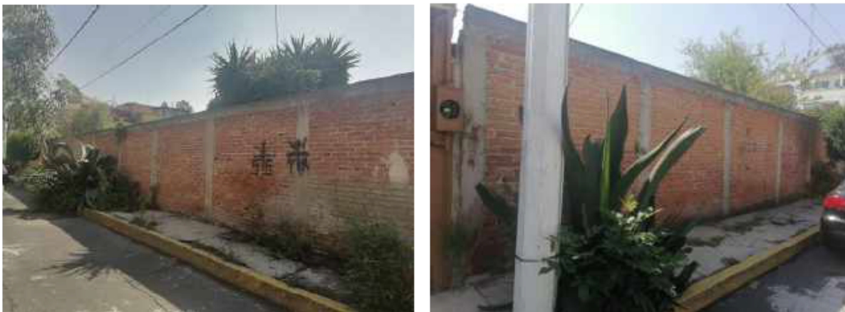
Figura 2.3 Fotografías tomadas en campo del predio de la estructura base de diseño
