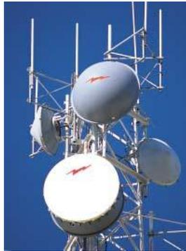
Figura 1.24: Antena repetidora de microondas
