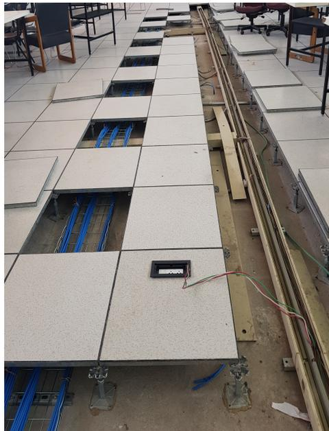
Figura 3.3: Tendido de cableado de red y electricidad
