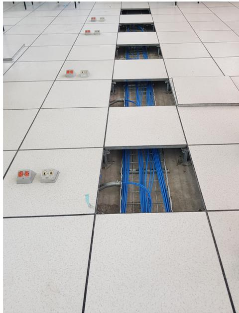
Figura 3.4: Cableado horizontal
