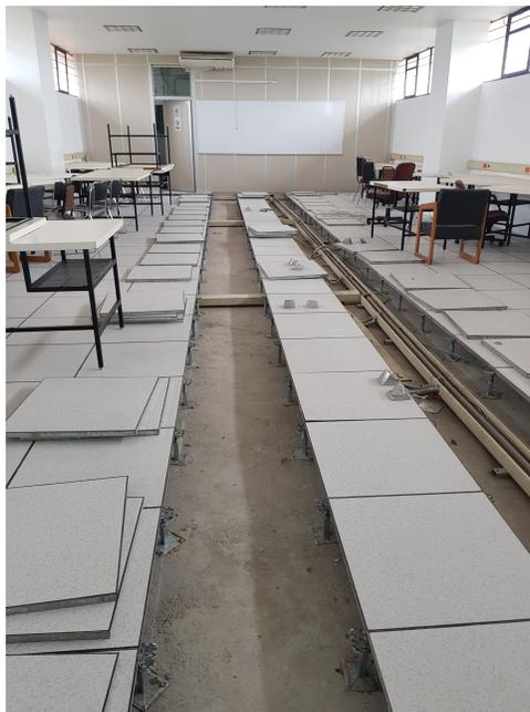
Figura 3.1: Colocación de piso falso
