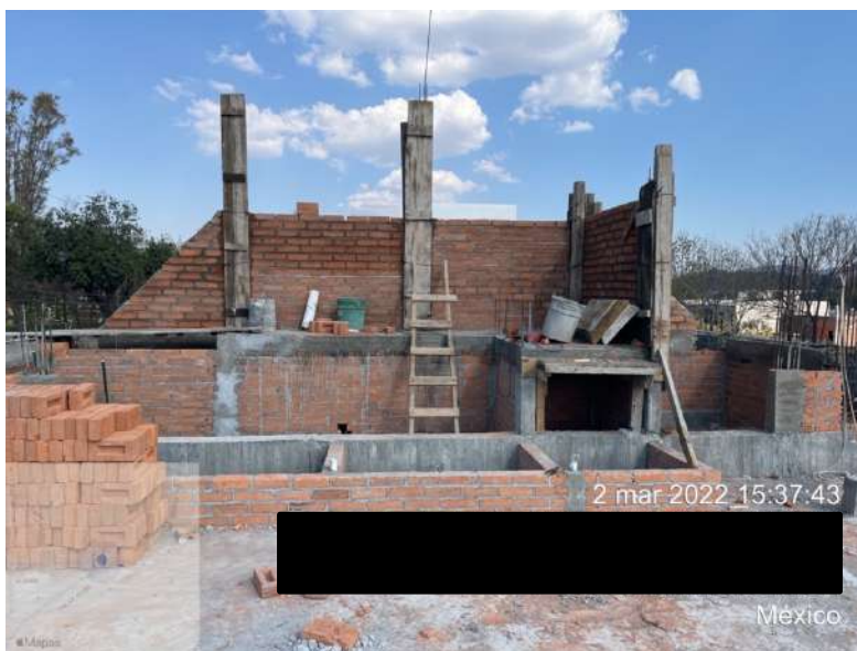
Figura 71. Desplante de muros de lumbrera.
