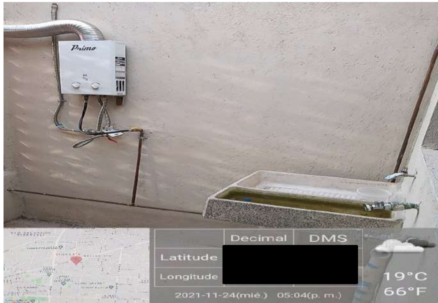
Figura 37. Cuarto de servicio.
