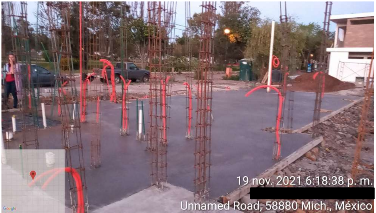
Figura 55. Colado de firme de concreto, castillos de acero e instalaciones hidrosanitarias y eléctricas.
