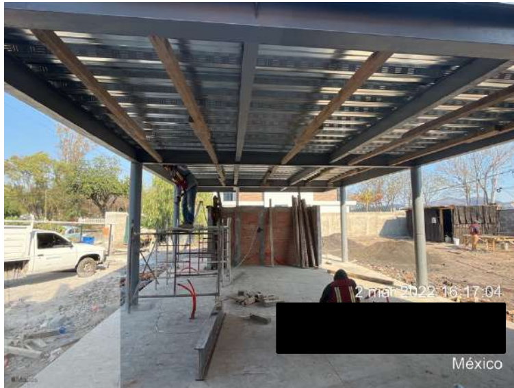
Figura 73. Proceso de soldadura de losacero a vigas IPR.
