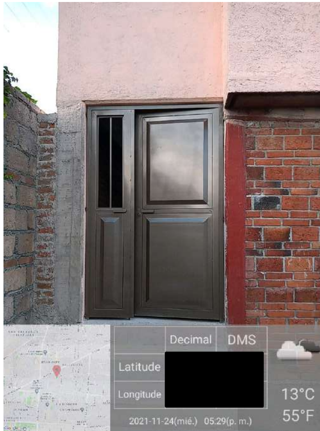
Figura 41. Puerta de herrería para acceso a primer nivel.
