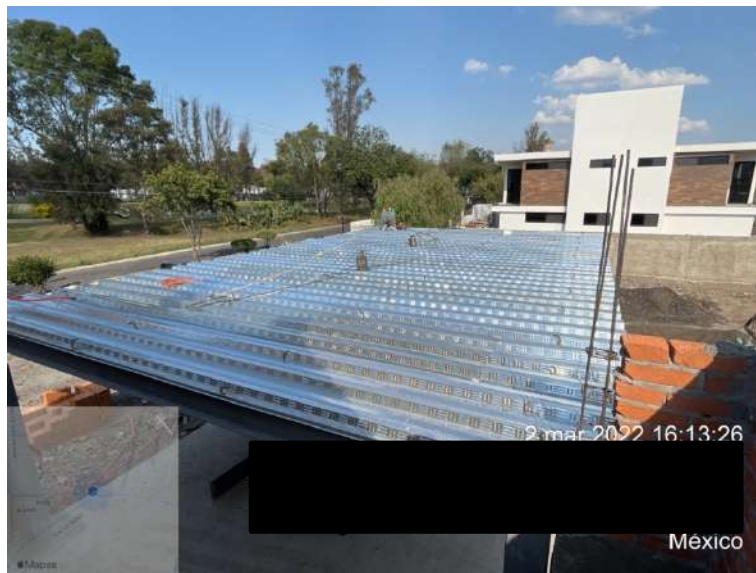
Figura 74. Colocación de losacero sobre perfiles de acero.
