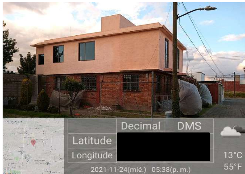
Figura 36. Fachada de la vivienda con trabajos terminados.
