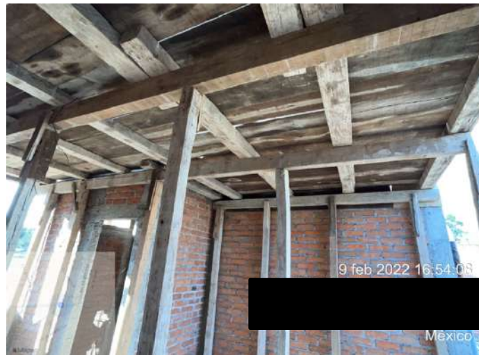
Figura 67. Cimbra de madera para colado de losa de concreto
