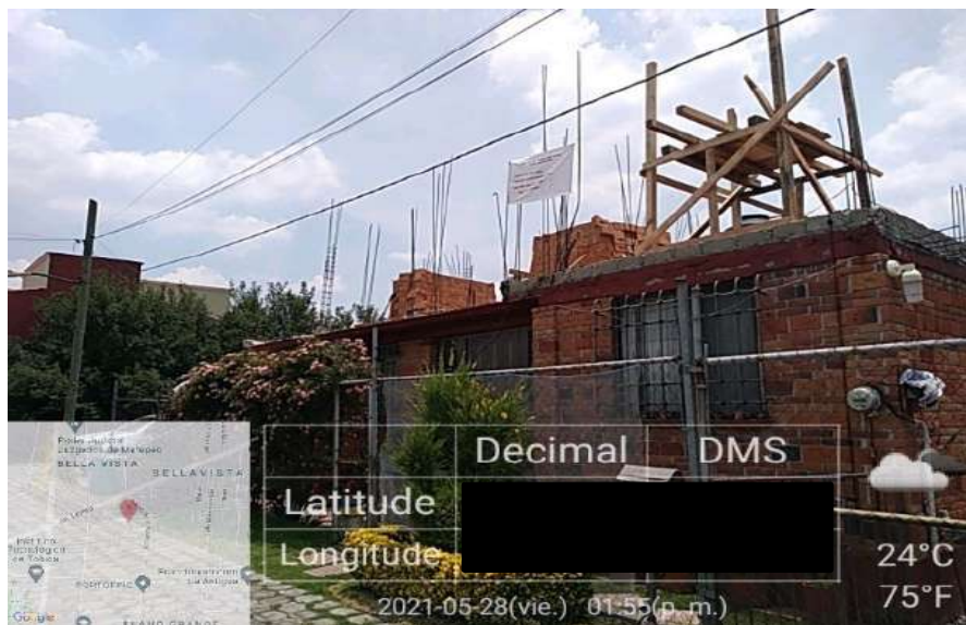
Figura 25. Fachada de la vivienda a intervenir, estado antes de aplicar los recursos.
