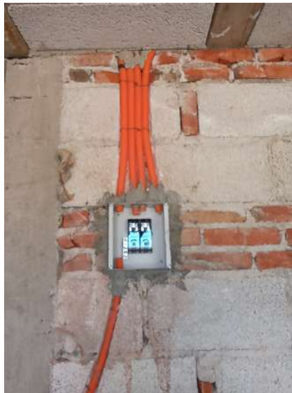
Figura 8. Preparación de centro de carga empotrado a muro.
