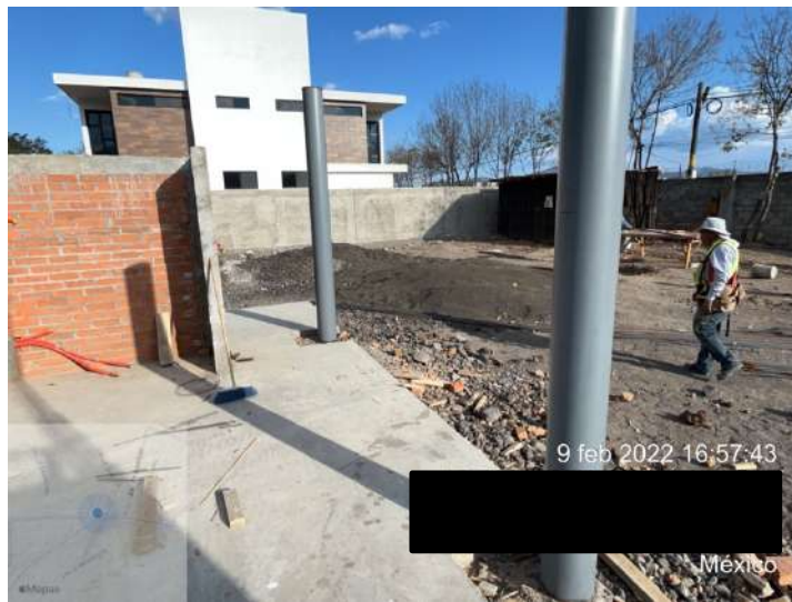
Figura 69. Columnas de acero de perfil circular.
