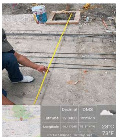
Figura 3. Verificación de las dimensiones de la cisterna.
