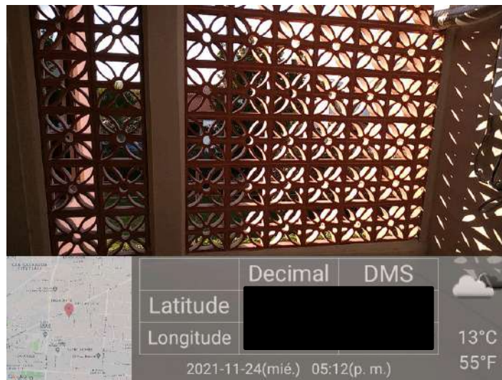
Figura 42. Muro de celosía en cuarto de servicio, primer nivel.
