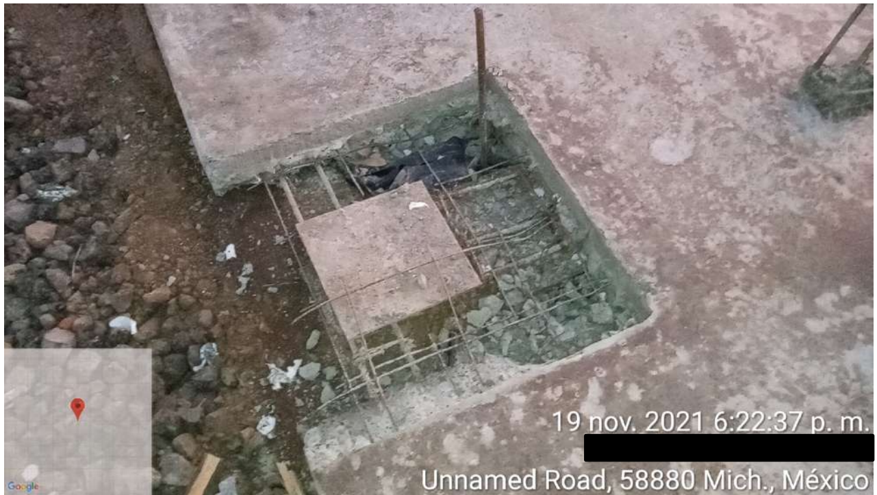
Figura 56. Placa de acero de 25x25 cm para recibir columna de acero circular.
