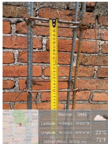
Figura 6. Verificación de la colocación de estribos a cada 20 cm.
