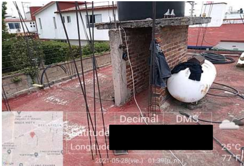
Figura 26. Trabajos de retiro de base para tinaco.
