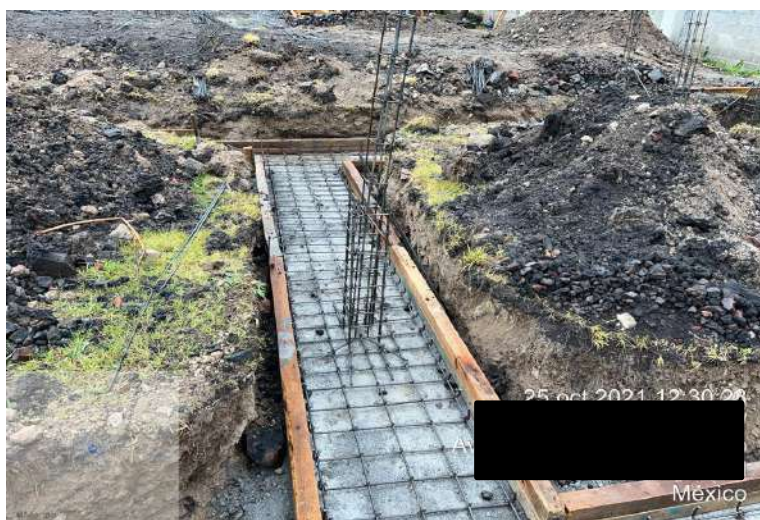
Figura 51. Armado de acero de zapata corrida y castillo anclado a cimentación.
