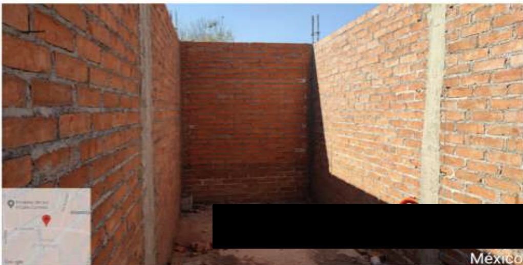
Figura 62. Desplante de muros de tabique rojo y colado de castillos.
