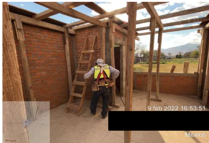
Figura 66. Colocación de cimbra de madera para colado de losa de concreto
