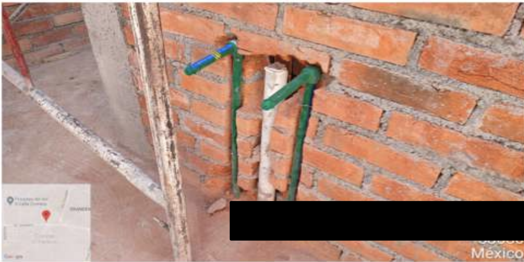
Figura 61. Salidas hidrosanitarias para lavabo en baño.
