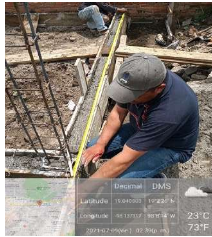
Figura 5. Verificación de las áreas de construcción
