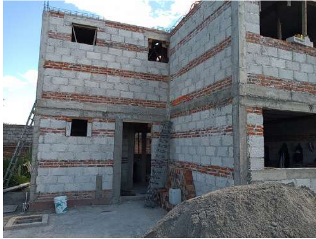
Figura 7. Fachada de vivienda, estructura a base de muros de tabique rojo recocido y block de concreto.
