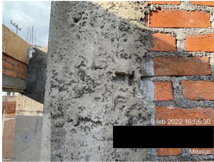
Figura 68. Segregación en castillos.
