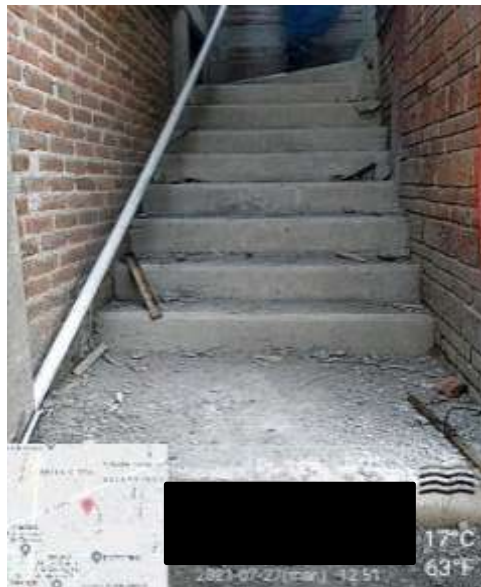
Figura 31. Escaleras de acceso a primer nivel.
