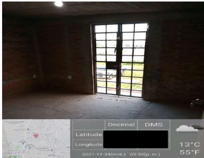
Figura 39. Ventana de herrería en primer nivel.
