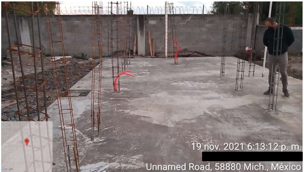
Figura 58. Firme de concreto colado y castillos de acero armado y armex para área de recamaras.
