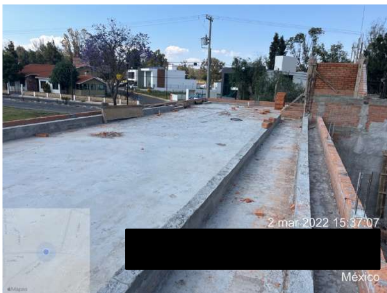
Figura 72. Losa de concreto de azotea colada, trabes tipo T-1 coladas.
