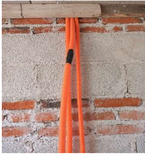
Figura 10. Unión de poliflex mediante cinta de aislar.
