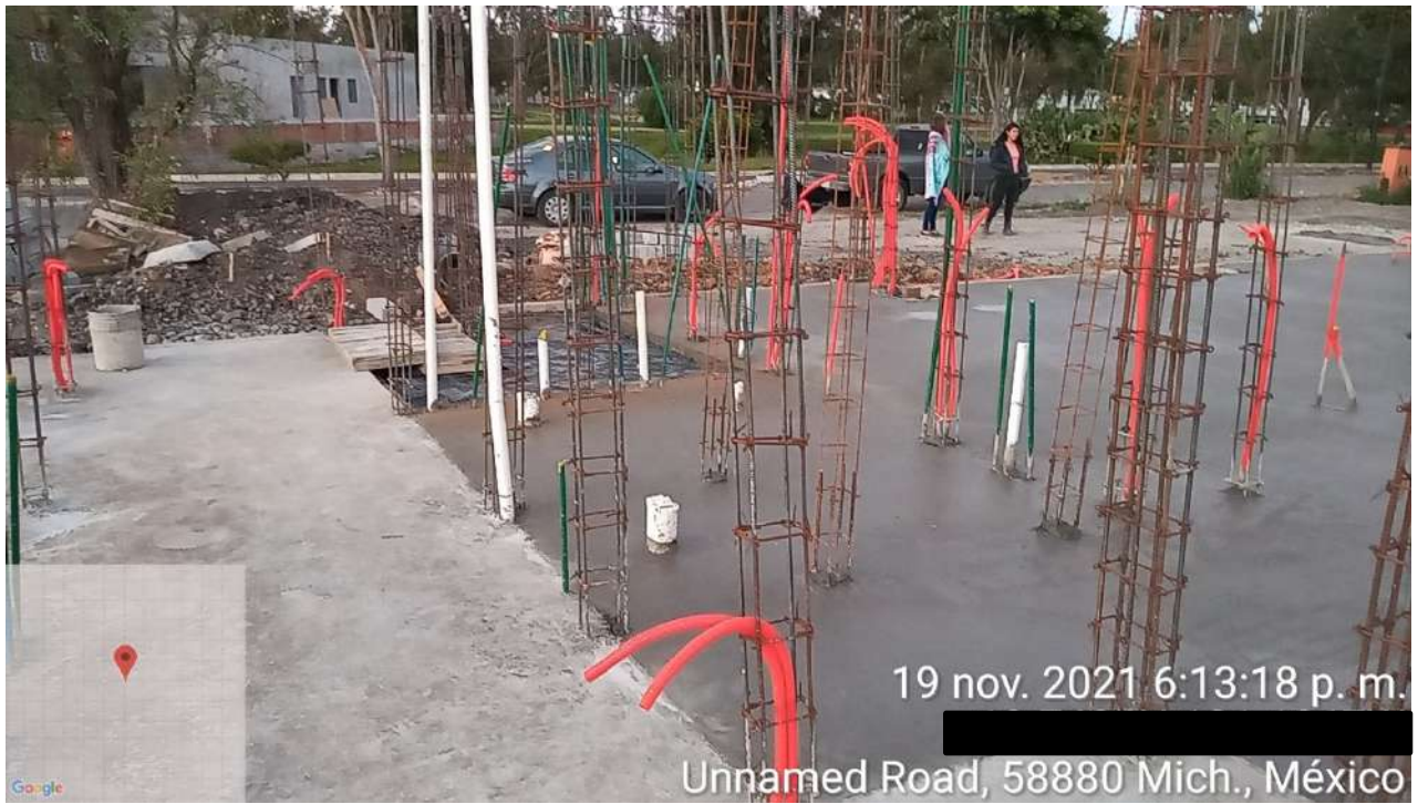
Figura 57. Colado de firme de concreto para área de baño y sala.
