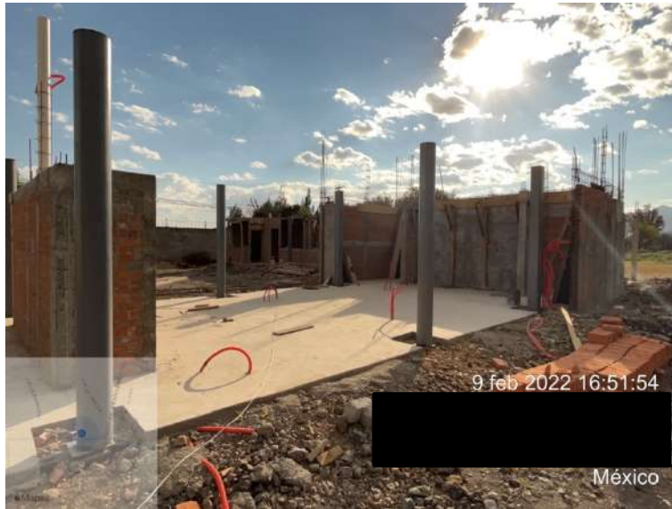
Figura 63. Columnas de acero de perfil circular soldadas sobre placas de acero de 25x25cm.
