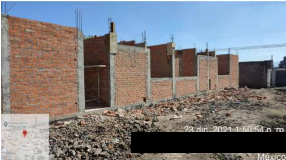
Figura 60. Desplante de muros de tabique rojo recocido y colado de castillos
