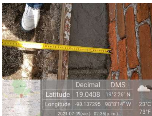
Figura 4. Verificación de las dimensiones de la dala de desplante.
