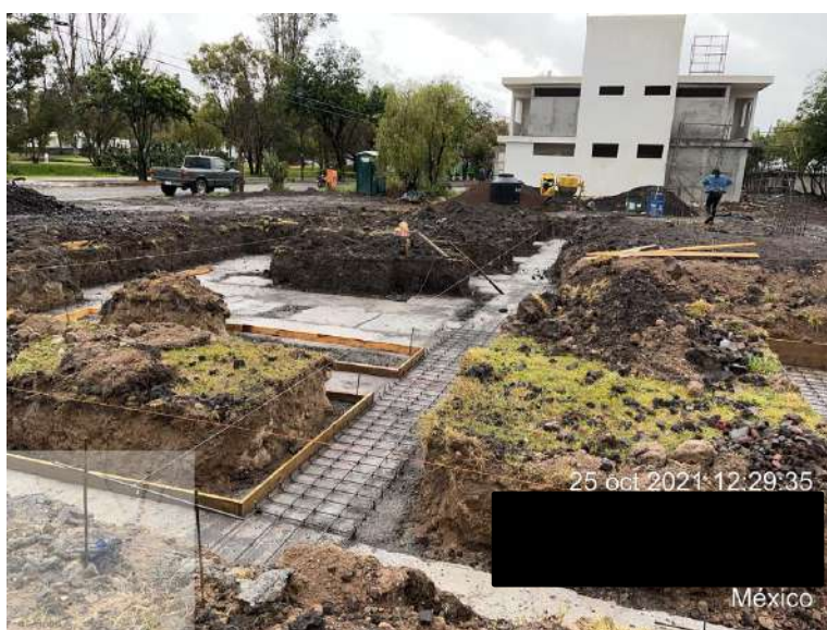
Figura 50. Armado de acero de zapata corrida.
