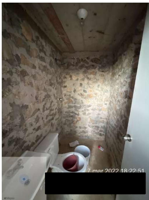
Figura 77. Baño a base de muros de mampostería.
