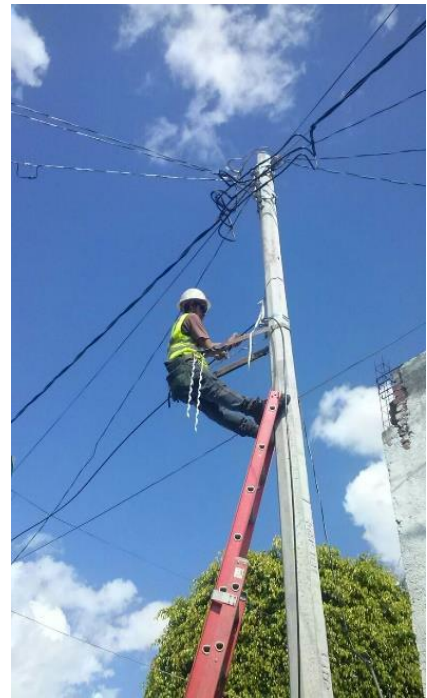
IMAGEN: INSTALACION AÉREA CON CABLE DE FIBRA ÓPTICA Fuente: Elaboración propia
