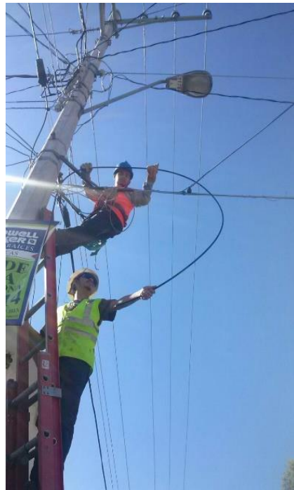
IMAGEN: INSTALACION AÉREA CON CABLE DE FIBRA ÓPTICA Fuente: Elaboración propia
