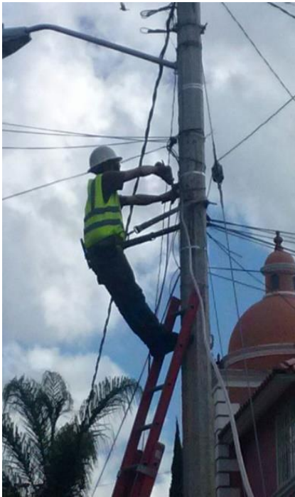
IMAGEN: INSTALACION AÉREA CON CABLE DE FIBRA ÓPTICA Fuente: Elaboración propia
