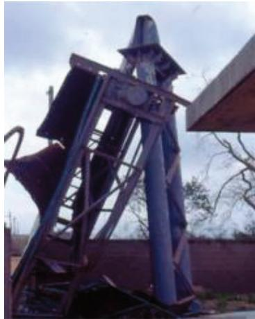
Figura 37.-Falla estructural en la conexión pedestal-pantalla. (Baeza, Vargas y Pérez, 2004)
