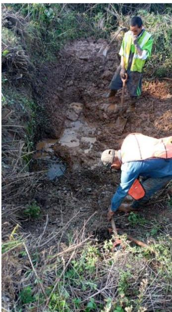
**Ilustración 29 Limpieza de obras de drenaje en tramo “433 Tapalpa – San Gabriel”. Creación propia, UNAM 2021**
