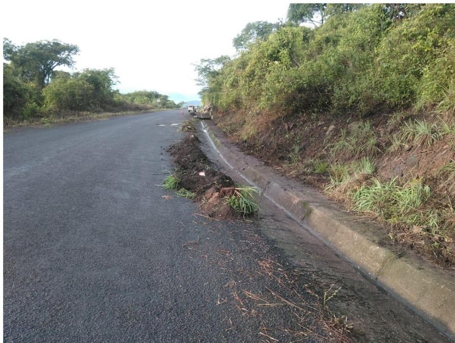
**Ilustración 23** Material desazolvido de cunetas en tramo “433 Tapalpa – San Gabriel”. Creación propia, UNAM 2021.
