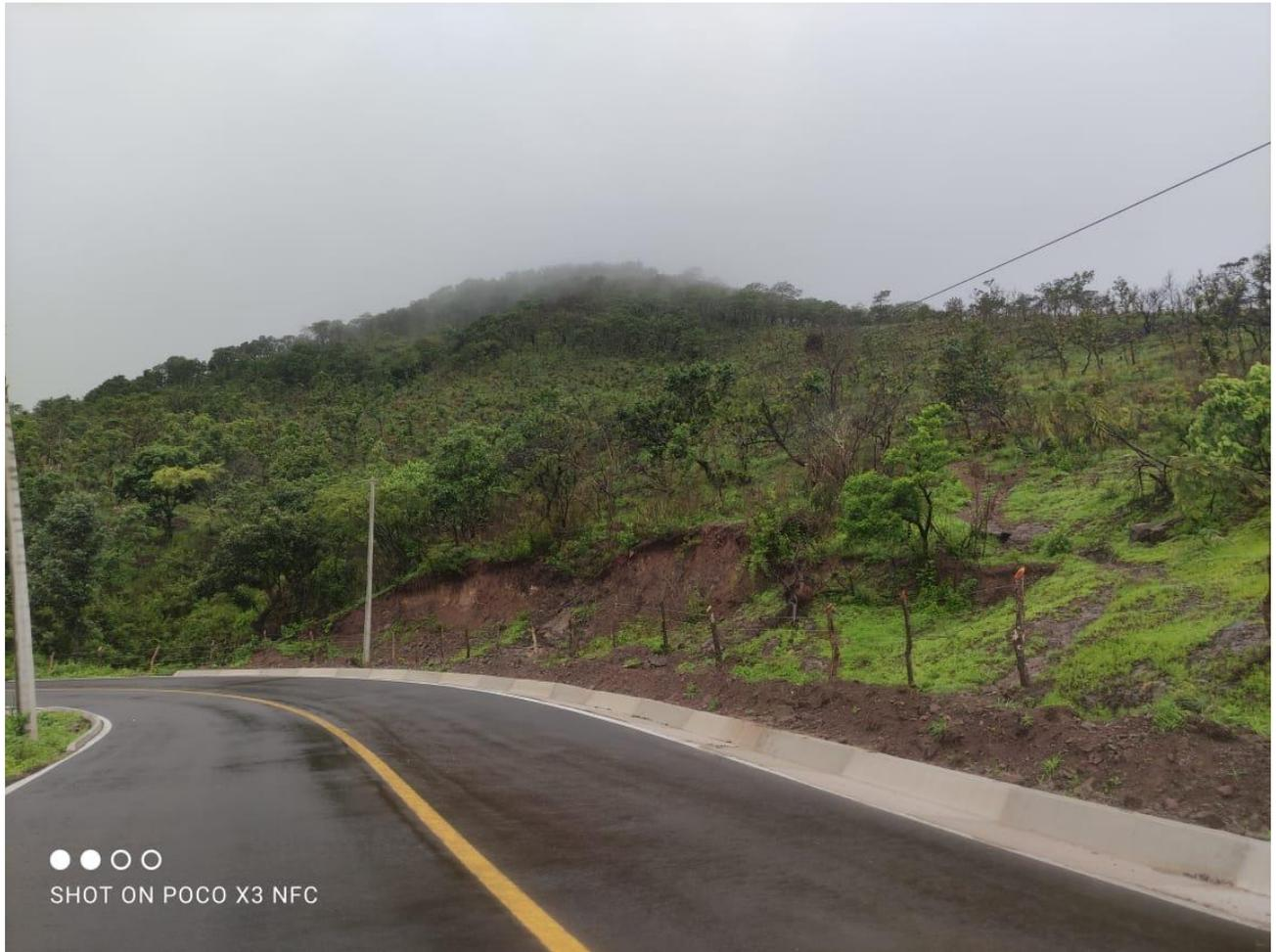
**Ilustración 40 Corona, cunetas y pintura terminada en km 15+900 tramo “433 Tapalpa – San Gabriel” Creación propia, UNAM 2021**
