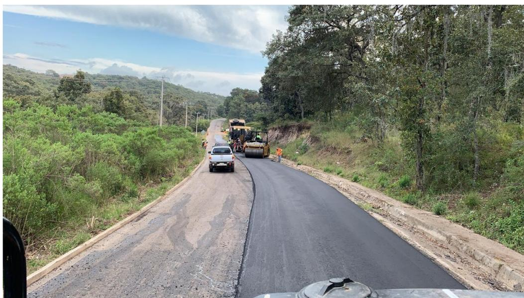
**Ilustración 20** Tendido de carpeta asfáltica en km 10+620 tramo “433 Tapalpa – San Gabriel”. Creación propia, UNAM 2021.
