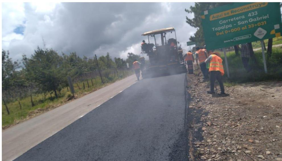
**Ilustración 19** Tendido de carpeta asfáltica en km 0+100 tramo “433 Tapalpa – San Gabriel”. Creación propia, UNAM 2021.
