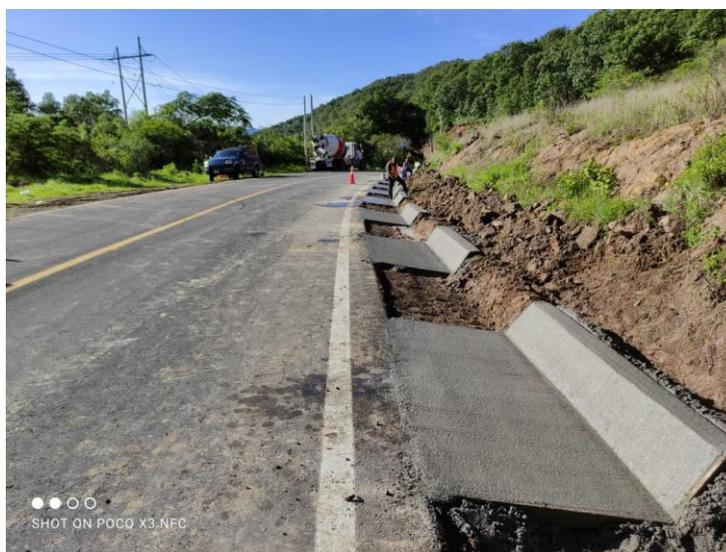
**Ilustración 28 Reconstrucción de cunetas km 10+400 en tramo “433 Tapalpa – San Gabriel”. Creación propia, UNAM 2021**
