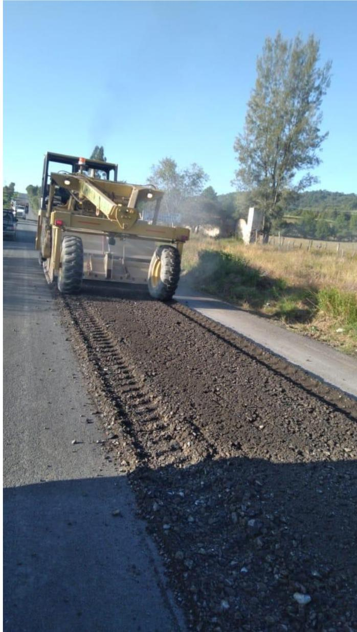
**Ilustración 7 Trabajos de recuperado con aporte de óxido de calcio en km 6+400 en tramo “433 Tapalpa – San Gabriel”, elaboración propia, UNAM 2021.**
