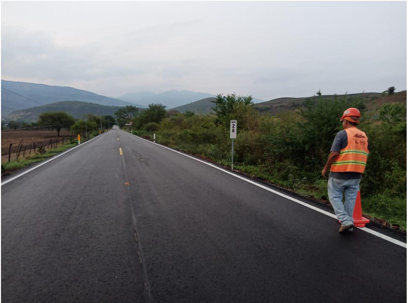
**Ilustración 38 Señalamiento, corona y pintura terminada en km 28+000 tramo “433 Tapalpa – San Gabriel”
