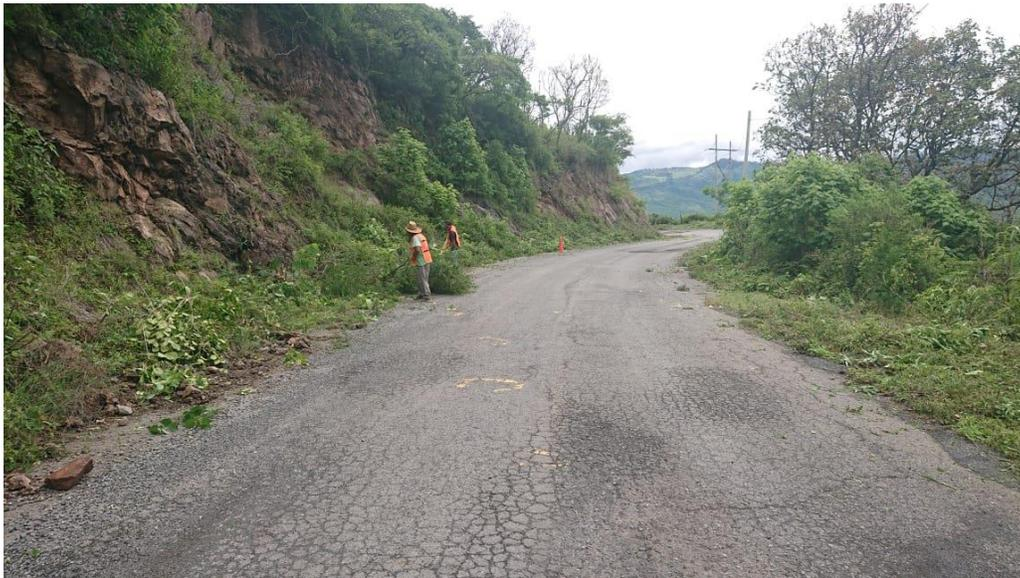
**Ilustración 9 Corte de vegetación en derecho de vía km 14+400 en tramo “433 Tapalpa – San Gabriel”, elaboración propia, UNAM 2021**
