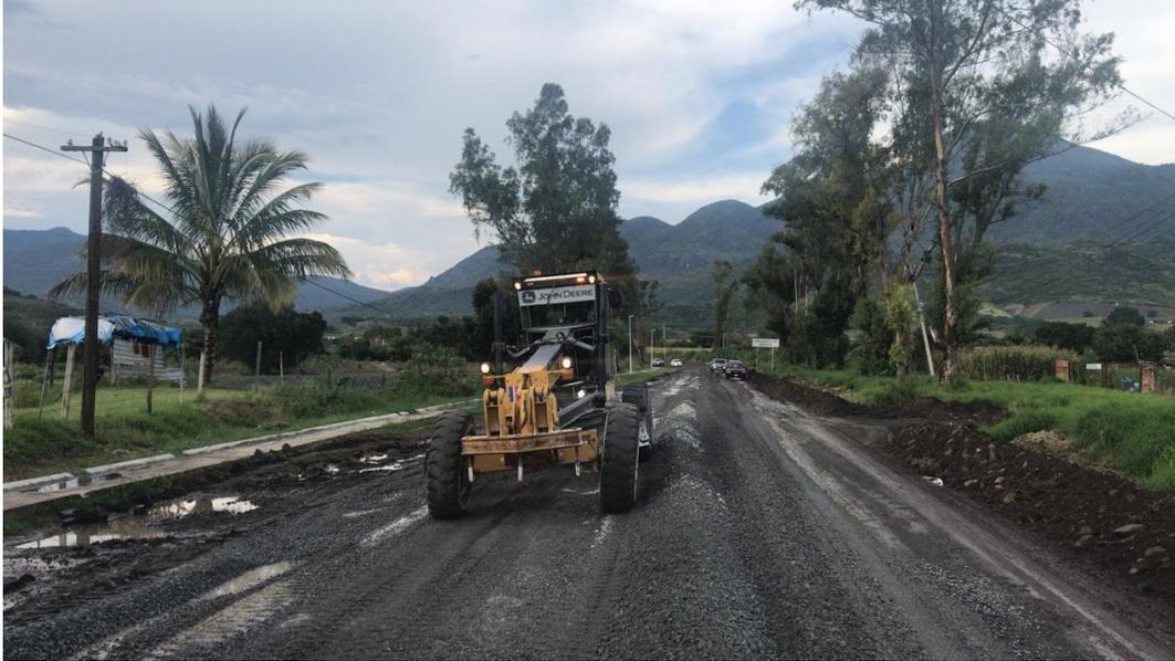
**Ilustración 16 Conformación de nueva base hidráulica tramo “433 Tapalpa – San Gabriel” km 32+600. Creación propia, UNAM 2021.**
