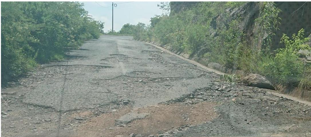
**Ilustración 5 Condiciones de carpeta asfáltica en tramo “433 Tapalpa – San Gabriel”, elaboración propia, UNAM 2021.**
