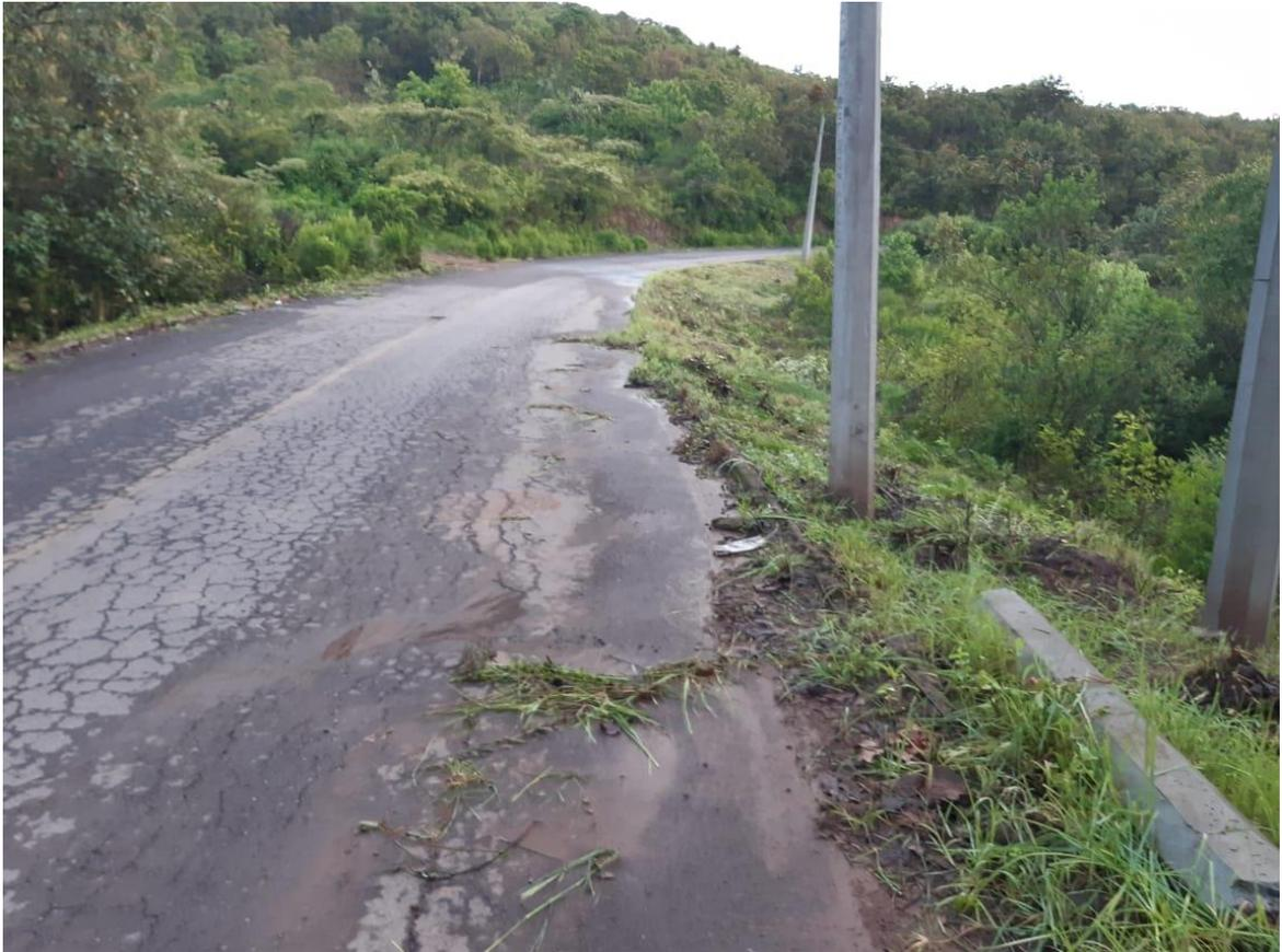
**Ilustración 14 Huella de agua retenida en zona con bordillo en tramo “433 Tapalpa – San Gabriel” elaboración propia, UNAM 2021.**
