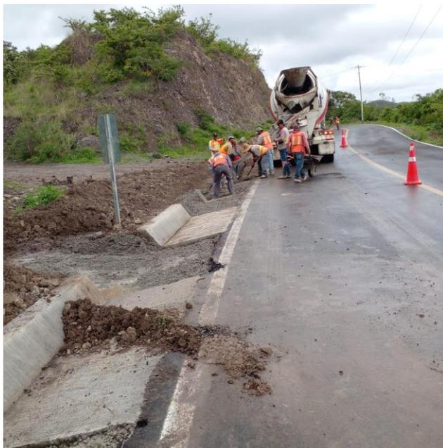
**Ilustración 27 Reconstrucción de cunetas en km 12+000 en tramo “433 Tapalpa – San Gabriel”. Creación propia, UNAM 2021**
