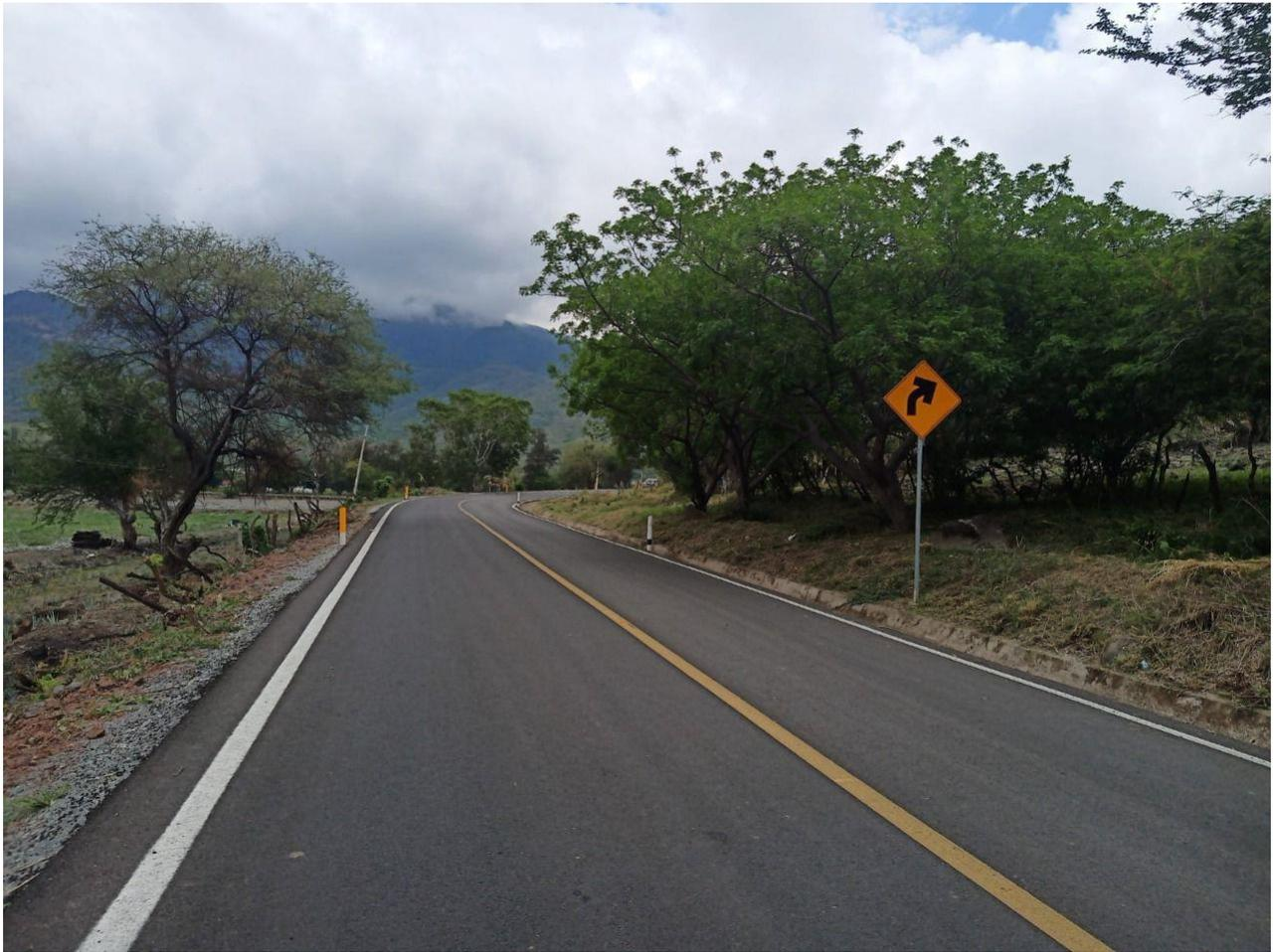
**Ilustración 37 Señalamiento, corona y pintura terminada en km 30+100 tramo “433 Tapalpa – San Gabriel”
