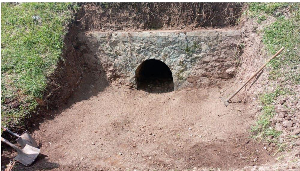
**Ilustración 30 Limpieza de obras de drenaje en tramo “433 Tapalpa – San Gabriel”. Creación propia, UNAM 2021**
