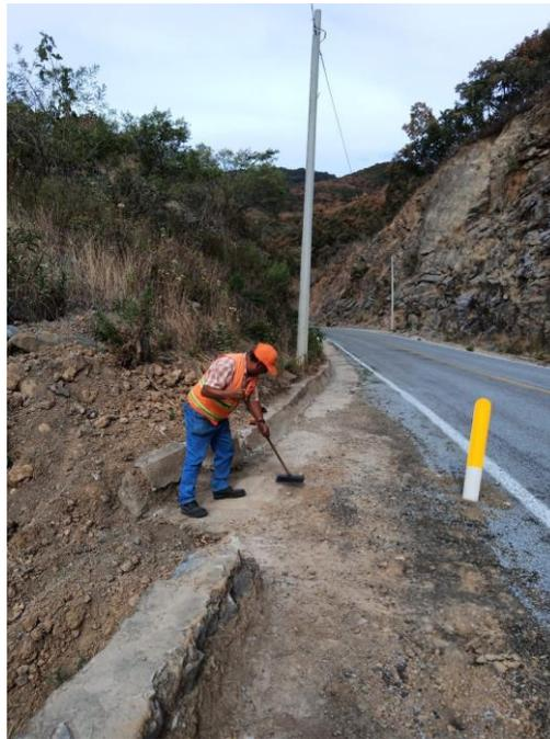
**Ilustración 32 Limpieza de cunetas km 18+200 en tramo “433 Tapalpa – San Gabriel”. Creación propia, UNAM 2021**
