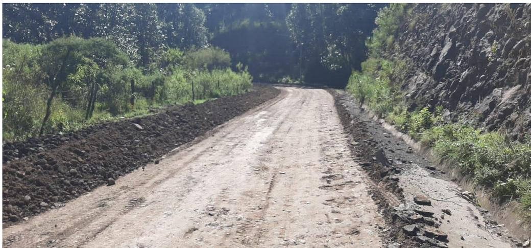
**Ilustración 17 Retiro de base hidráulica existente km 13+600 tramo “433 Tapalpa – San Gabriel” km 32+600. Creación propia, UNAM 2021.**
