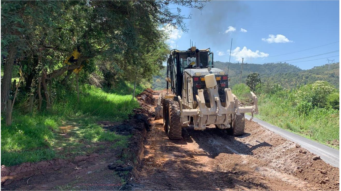
**Ilustración 6 Trabajos de recuperado con aporte de óxido de calcio en km 7+400 en tramo “433 Tapalpa – San Gabriel”, elaboración propia, UNAM 2021.**
