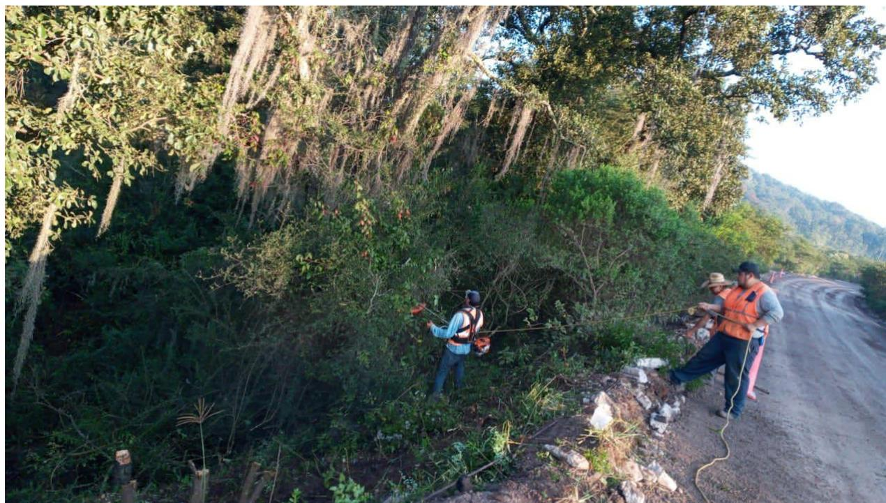
Ilustración 26 Desyerbe de derecho de vía en tramo “433 Tapalpa – San Gabriel”. Creación propia, UNAM 2021.
