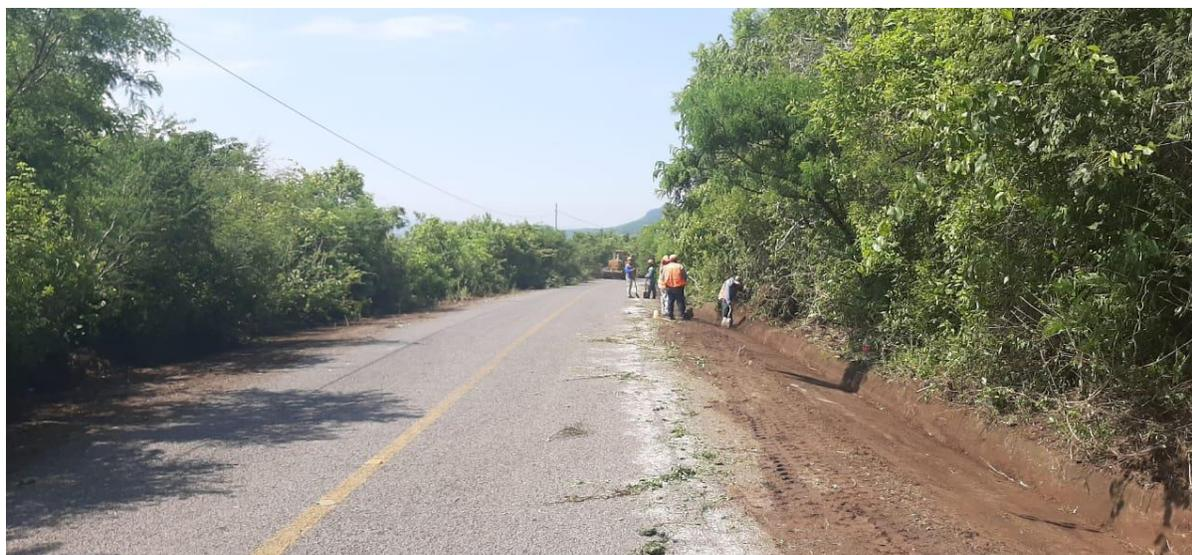
**Ilustración 24** Desazolvido de cunetas en tramo “433 Tapalpa – San Gabriel”. Creación propia, UNAM 2021
