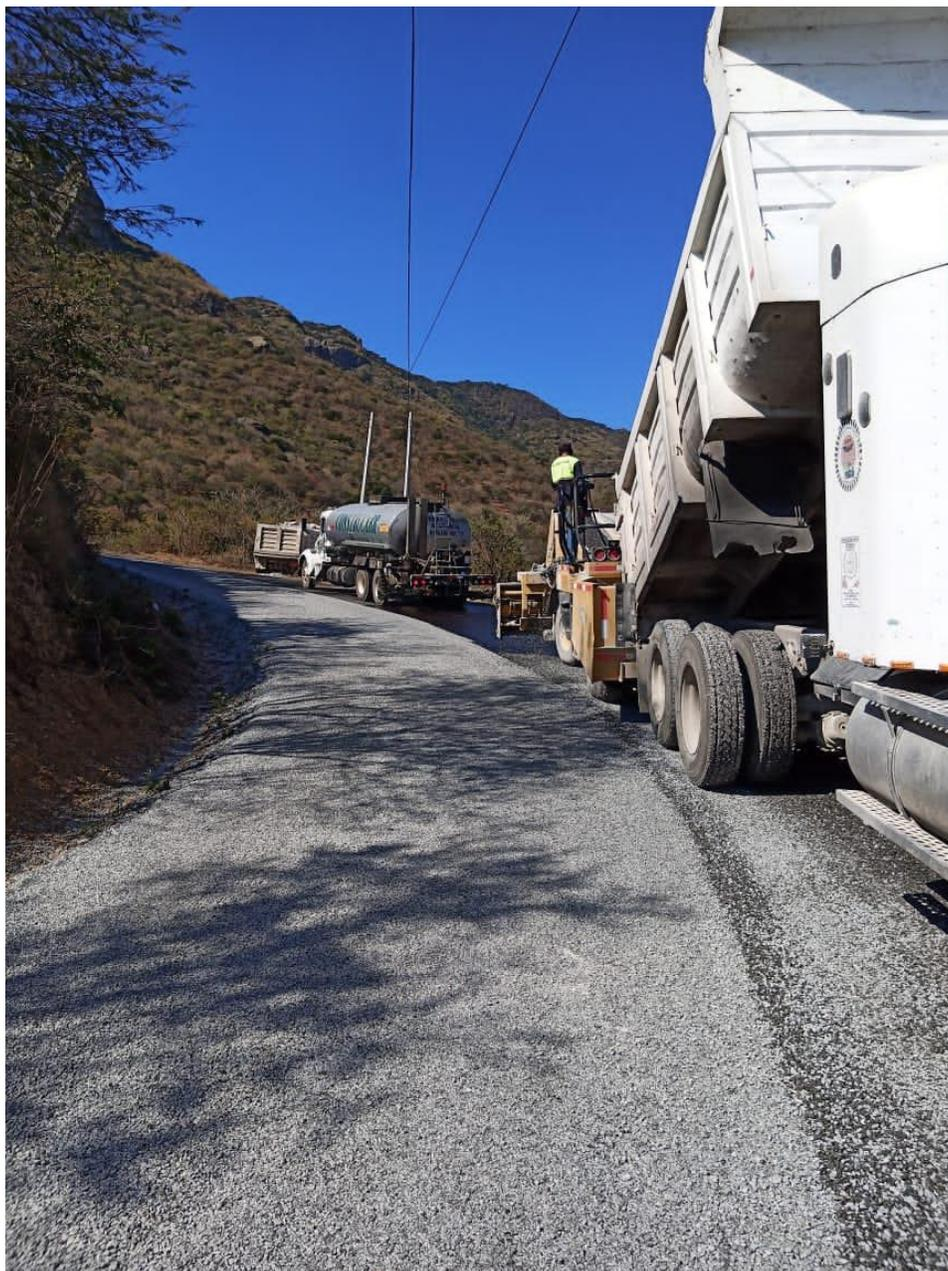
**Ilustración 31 Aplicación de riego de sello en km 22+200 en tramo “433 Tapalpa – San Gabriel”. Creación propia, UNAM 2021**
