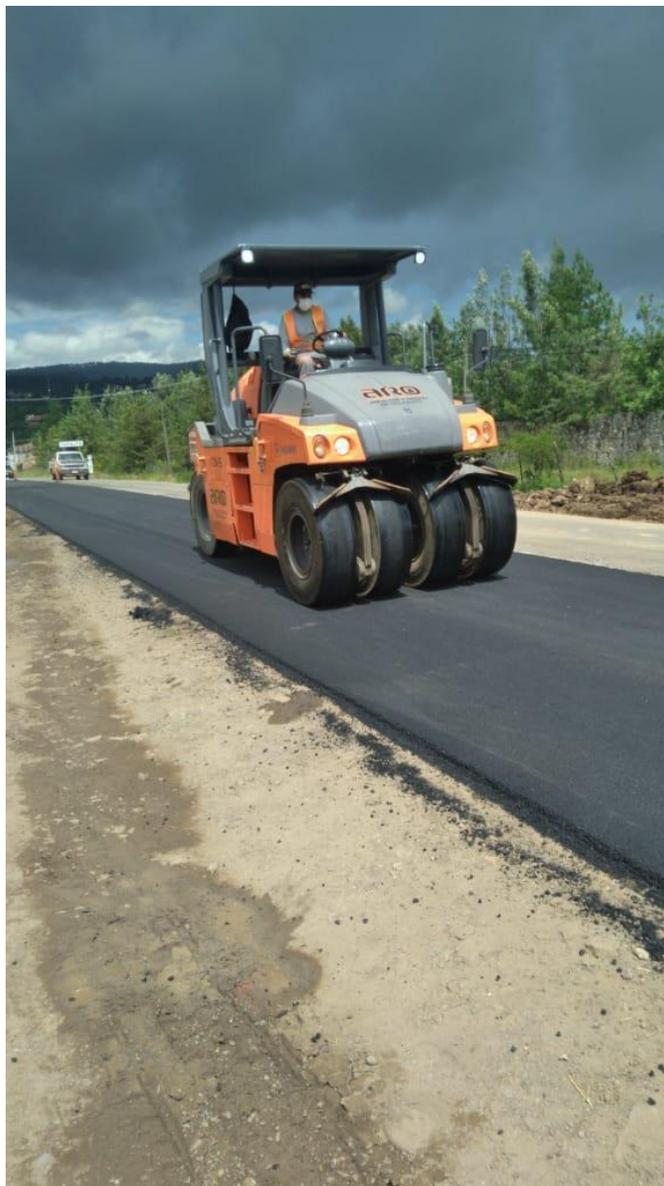
**Ilustración 21** Compactador neumático en km 0+400 en tramo “433 Tapalpa – San Gabriel”. Creación propia, UNAM 2021.
