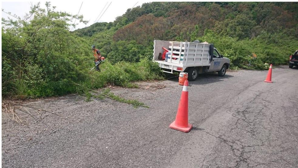
Ilustración 25 Desyerbe de derecho de vía en tramo “433 Tapalpa – San Gabriel”. Creación propia, UNAM 2021.
