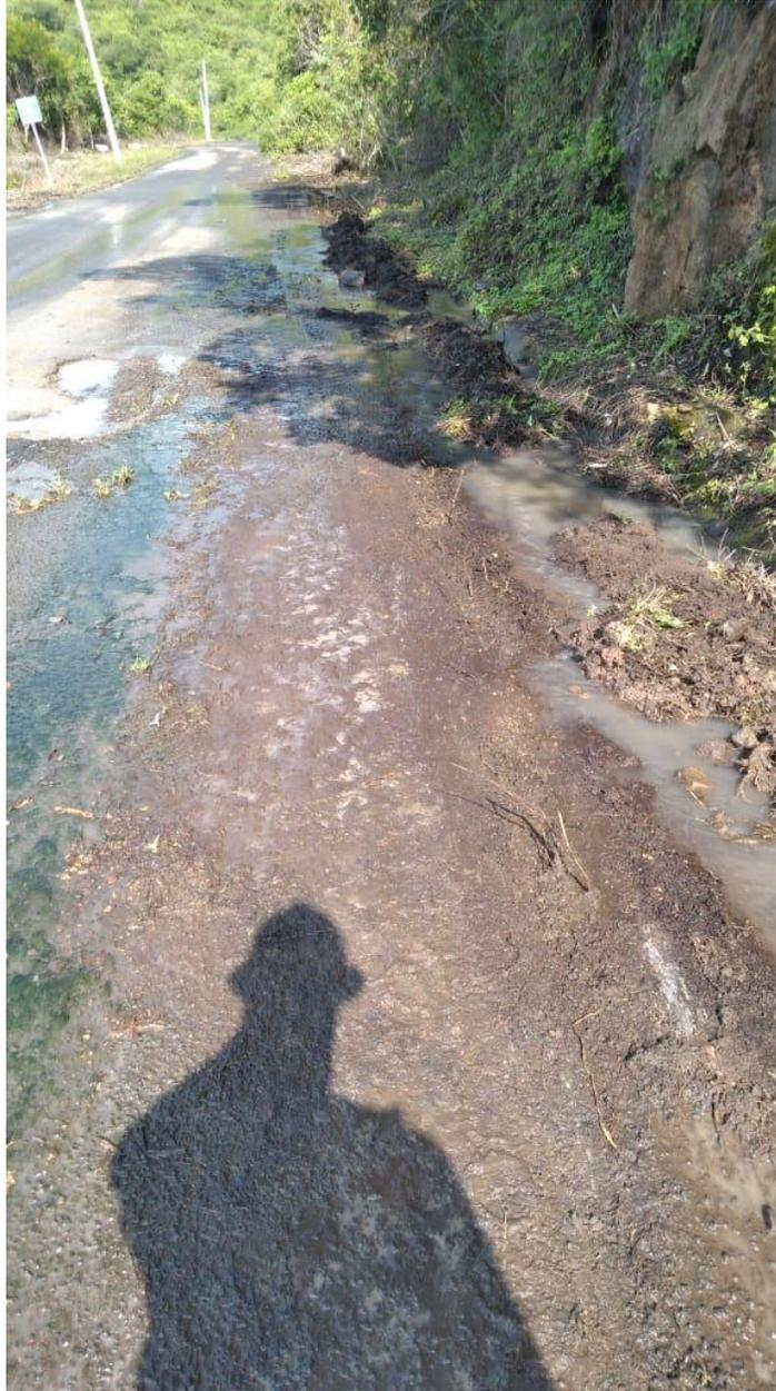
**Ilustración 10** Cuneta azolvada disfuncional que envía el agua por la carpeta asfáltica en tramo “433 Tapalpa – San Gabriel”, elaboración propia, UNAM 2021.
