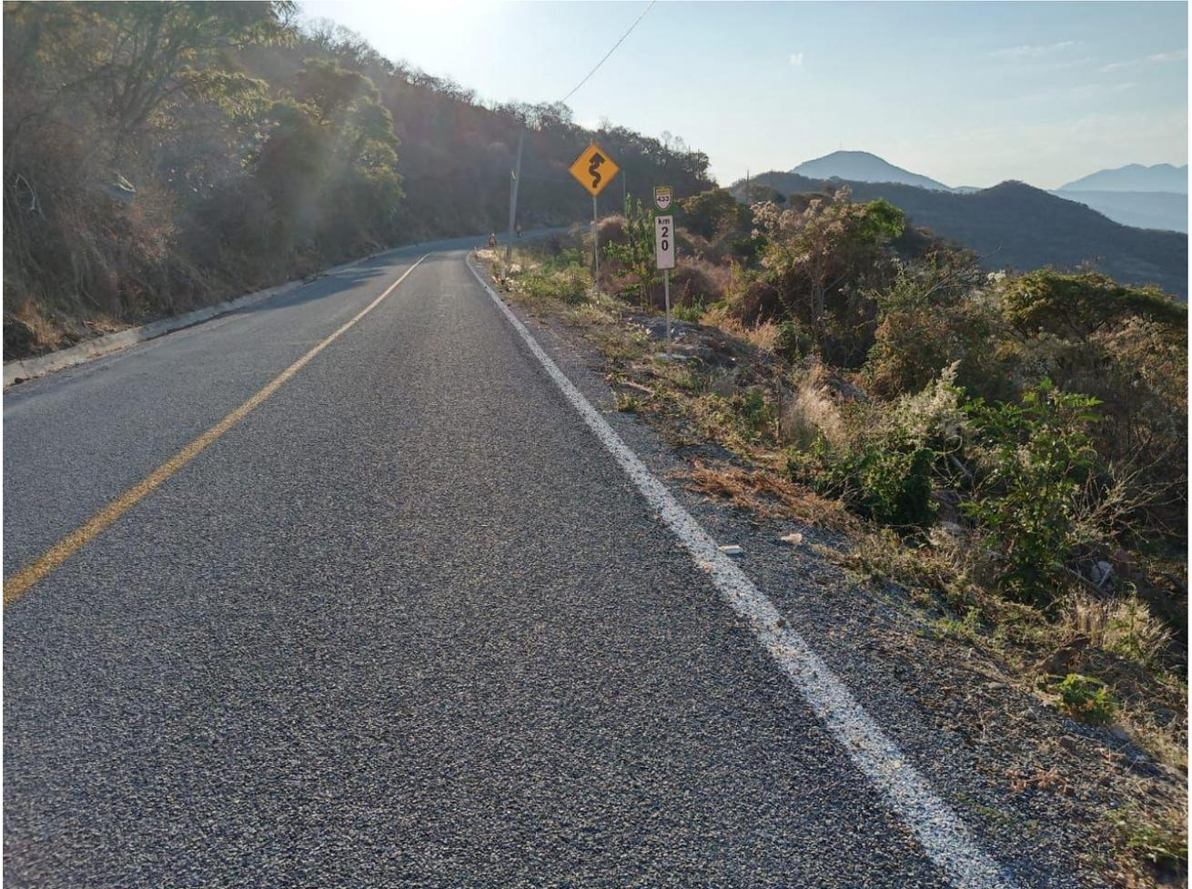
**Ilustración 39 Corona, cunetas, señalamiento y pintura terminada en km 20+000 tramo “433 Tapalpa – San Gabriel” Creación propia, UNAM 2021**
