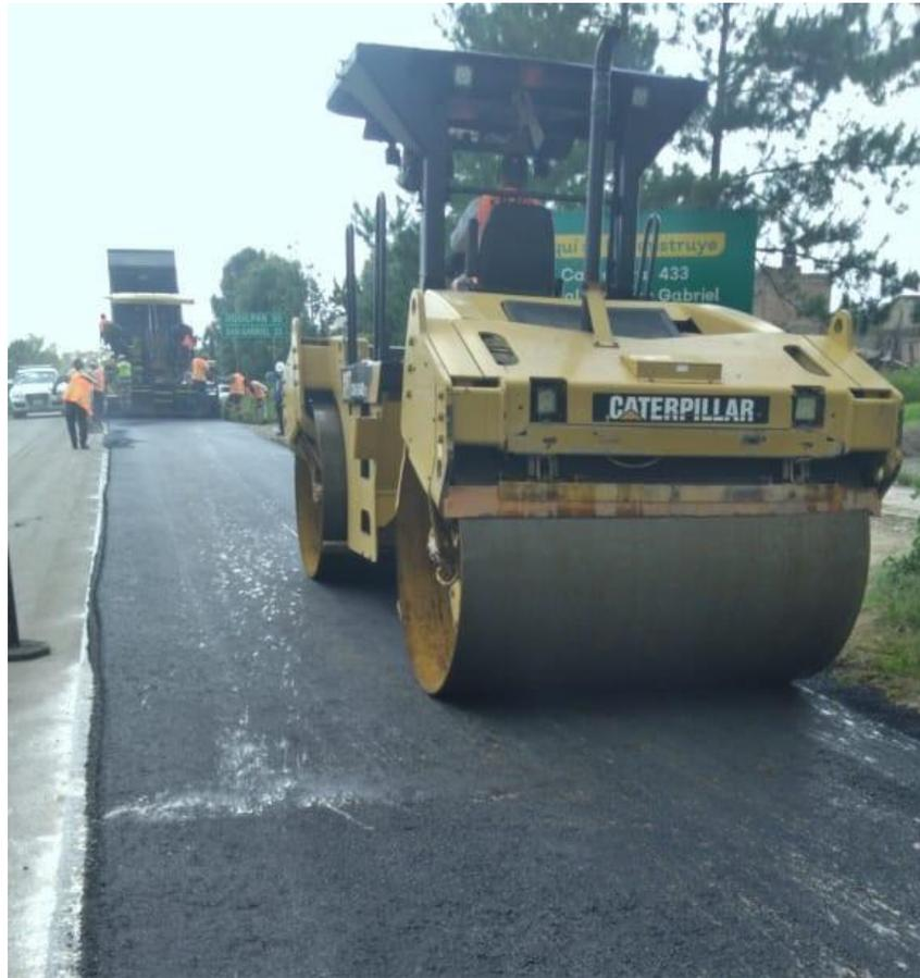
**Ilustración 22 Compactador doble rodillo en km 0+050 en tramo “433 Tapalpa – San Gabriel”. Creación propia, UNAM 2021.**
