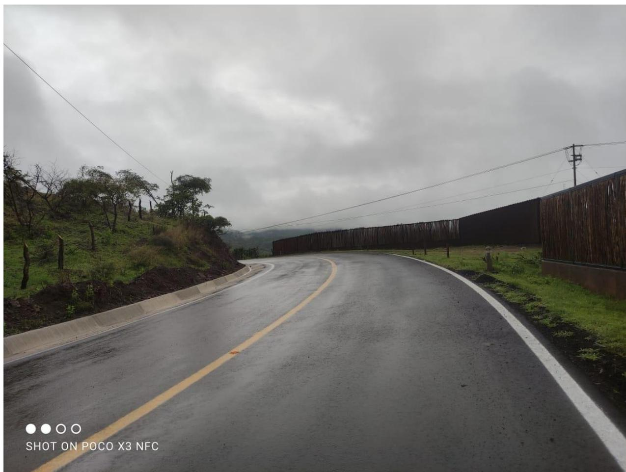
**Ilustración 36 Corona y cunetas terminadas en km 15+800 tramo “433 Tapalpa – San Gabriel” Creación propia, UNAM 2021**
