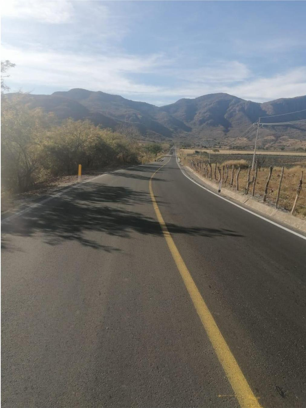
**Ilustración 41 Corona, cunetas, pintura y señalamiento terminado en km 29+350 tramo “433 Tapalpa – San Gabriel” Creación propia, UNAM 2021**
