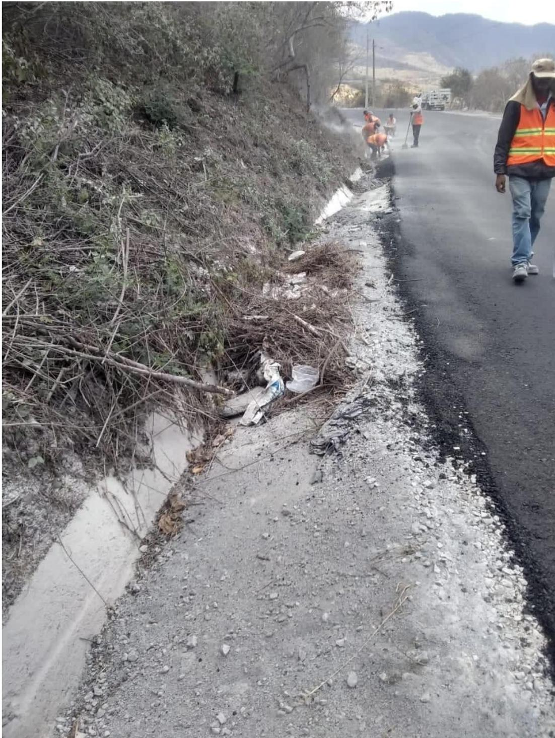
**Ilustración 12 Condiciones de cuneta previa a su limpieza en km 27 + 500 en tramo “433 Tapalpa – San Gabriel”
