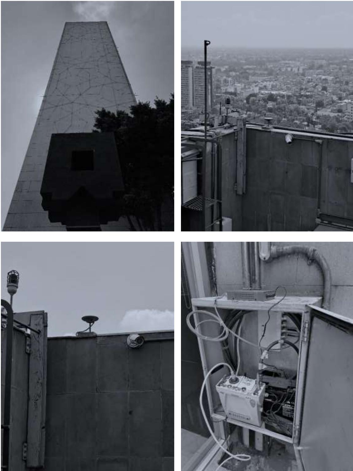
**Figura 3-4. Sistema de instrumentación GPS montado en el edificio.**
