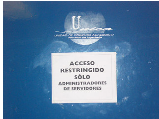
Figura 2.8 Acceso sólo a personal autorizado
