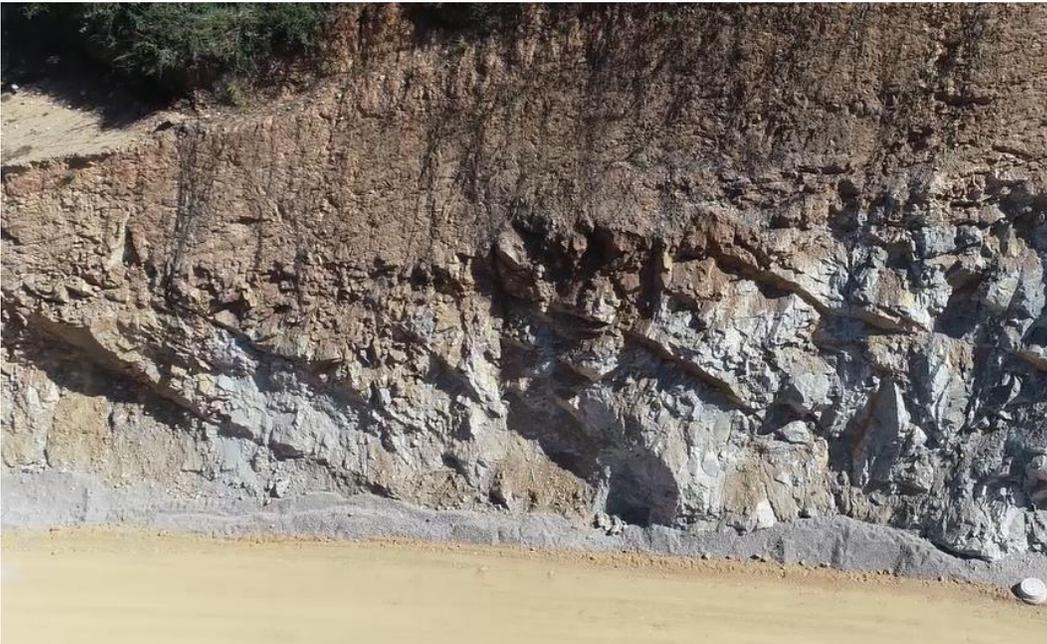
*Foto 4.11 Bloques de pórfido andesítico susceptible a caída o vuelcos.*
