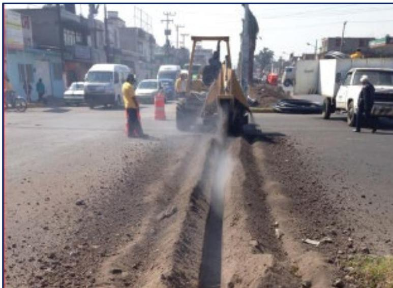
*Figura 10 Reemplazo de tubería. (MAPAS)*
