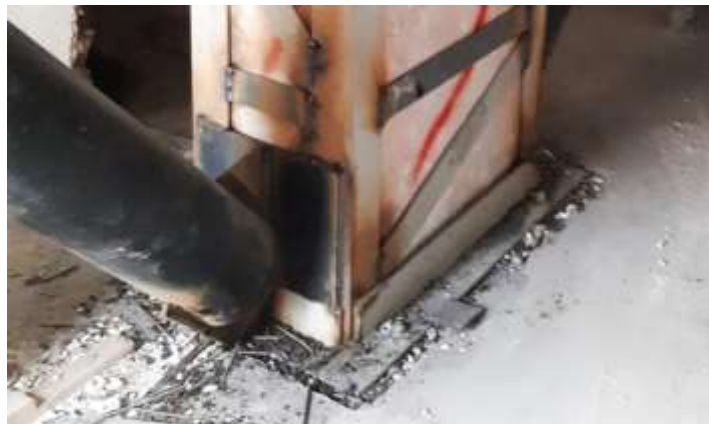
Fotografía 11 Se muestra conexión de contraventeo con columna reforzada en planta baja.
