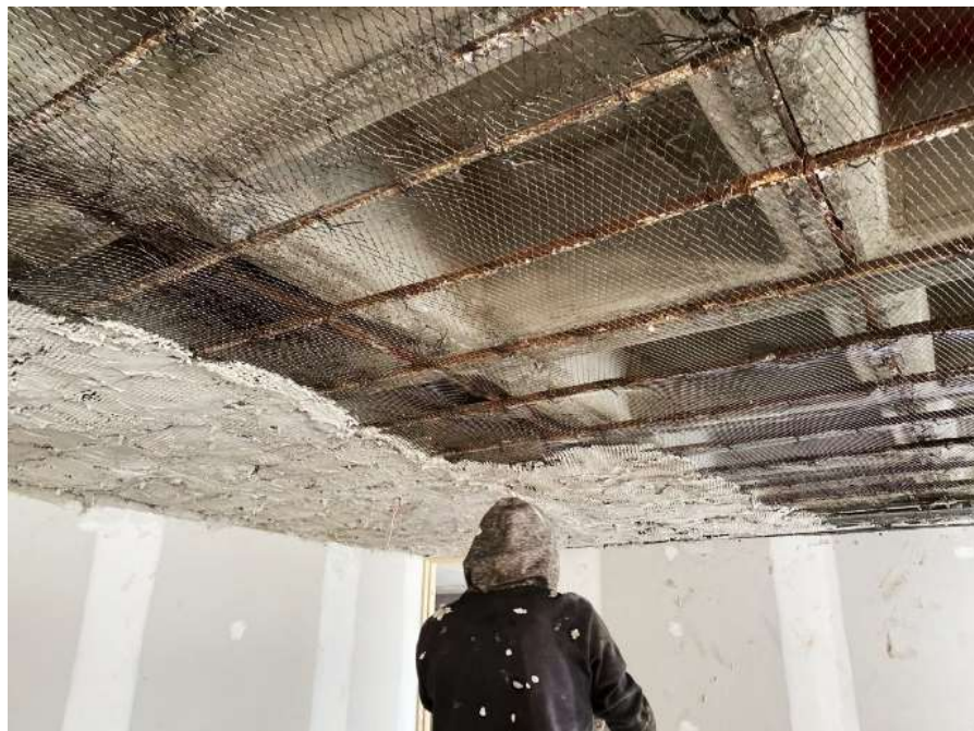
Fotografía 3 En esta fotografía se muestra el sistema de piso de losa nervada en el 2do nivel.
