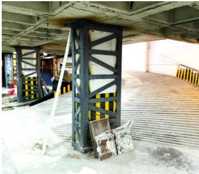
Fotografía 10 En esta fotografía se muestra columna reforzada en sótano.
