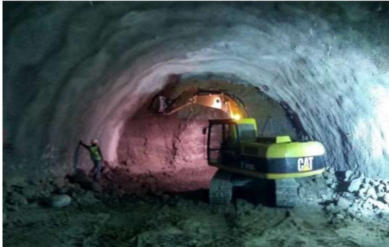
*Ilustración 7 - Excavación de la sección superior de túnel. SOBSE 2021.*
