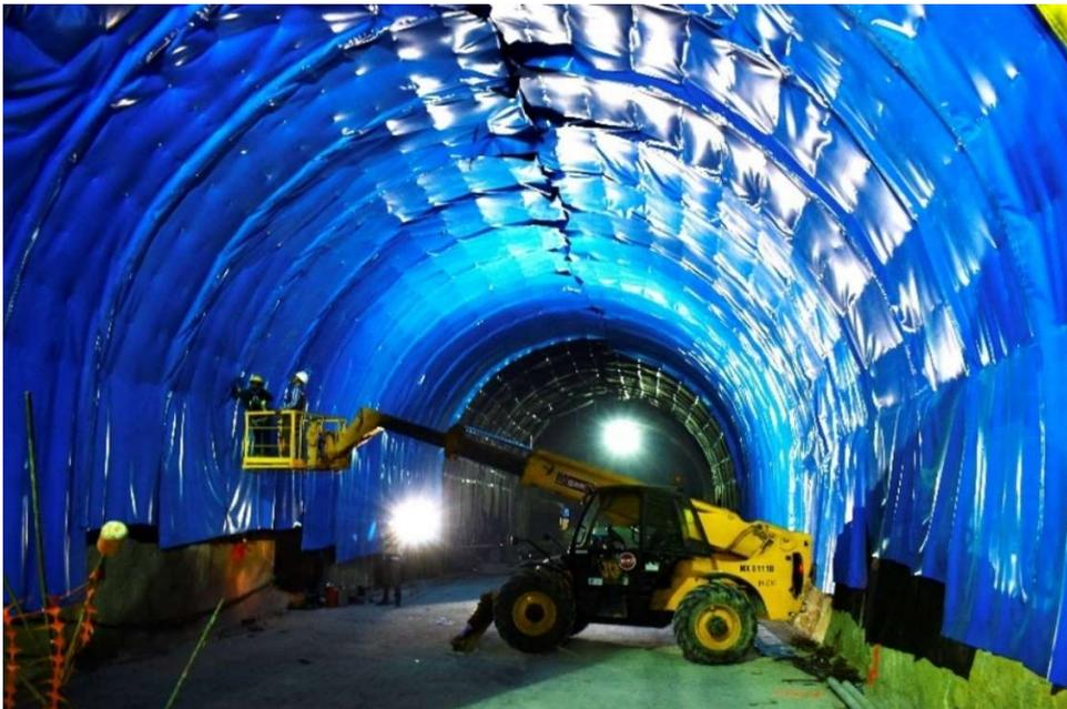
*Ilustración 14 - Trabajos de impermeabilización en túnel. SOBSE 2020.*
