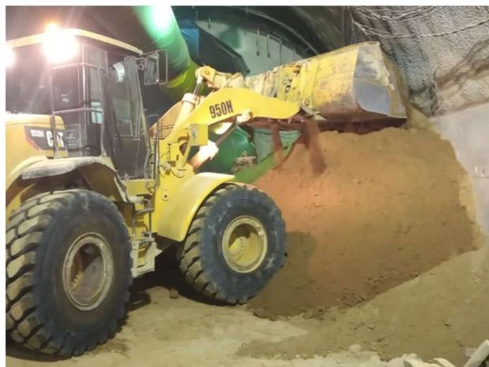
*Ilustración 8 - Movimiento de material de rezaga producto de la excavación a la lumbrera y su posterior retiro a superficie. SOBSE 2021.*
