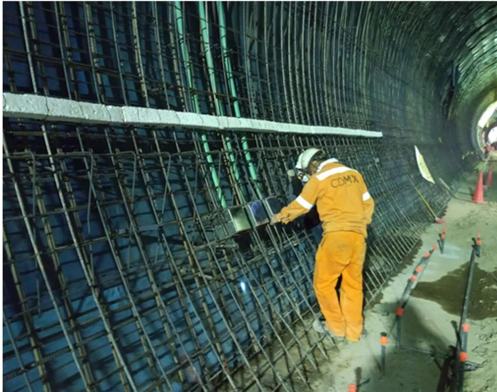
*Ilustración 16 - Preparaciones para cableado sobre muro hastial. SOBSE 2021.*
