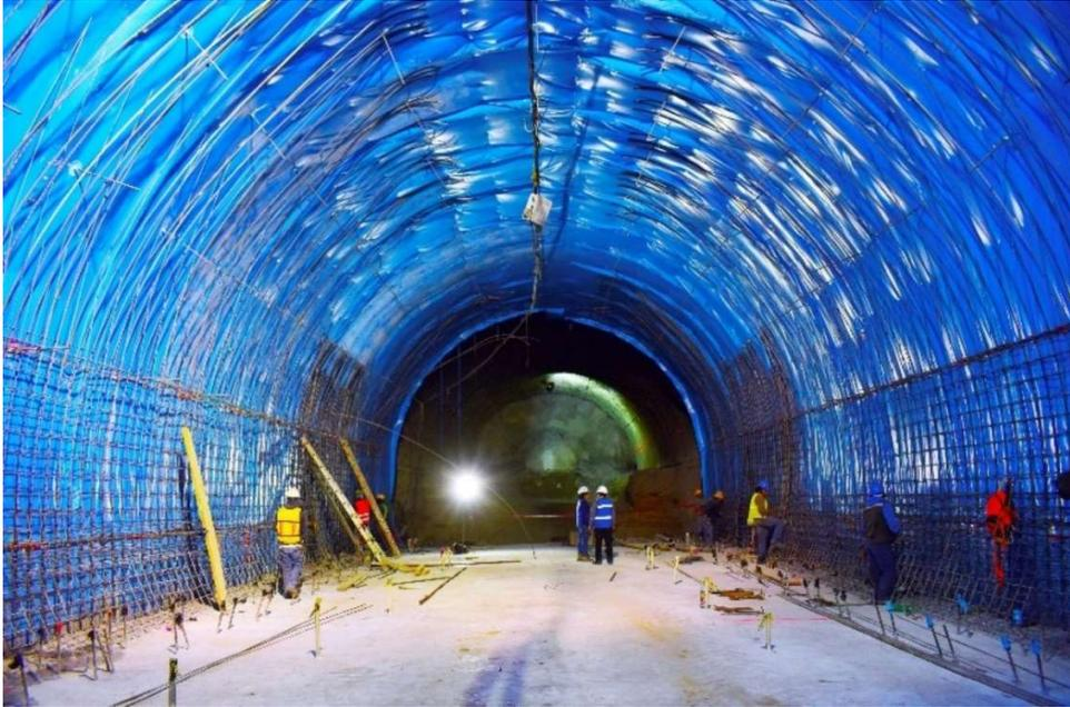
*Ilustración 13 - Trabajos de impermeabilización en túnel. SOBSE 2020.*
