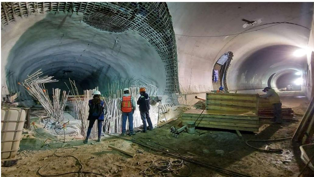
*Ilustración 12 – Estructuración de túnel secundario de estación. SOBSE 2021.*
