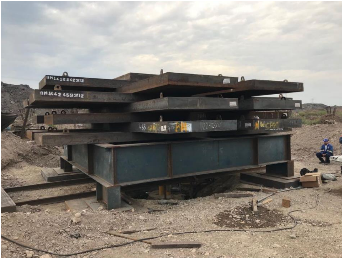
Imagen 8: Sistema de carga “KentLedge”, para aplicación de carga estática
