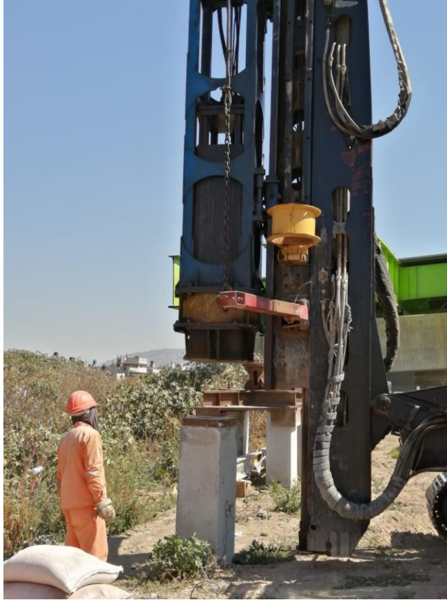
Imagen 1: Prueba de carga en rehinca a punto de ser ejecutada en pilote de concreto.
