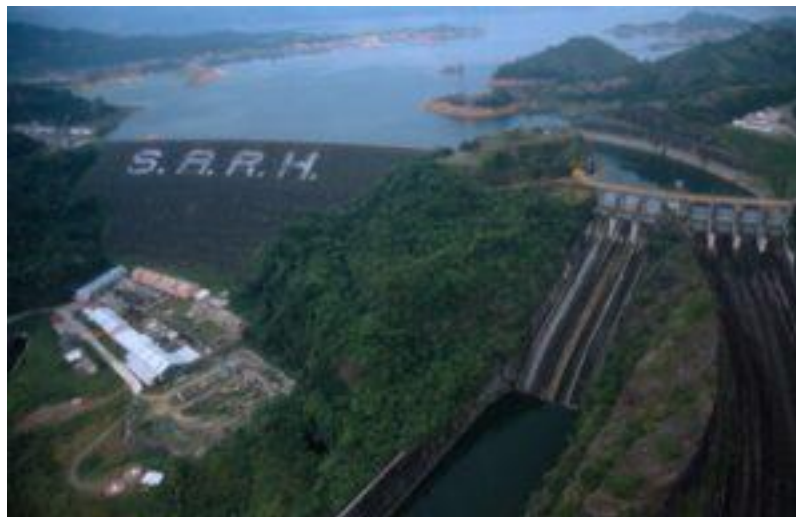
Figura 1.3 Foto aérea de la Presa Malpaso. Fuente: (Martínez A. , 2021)
