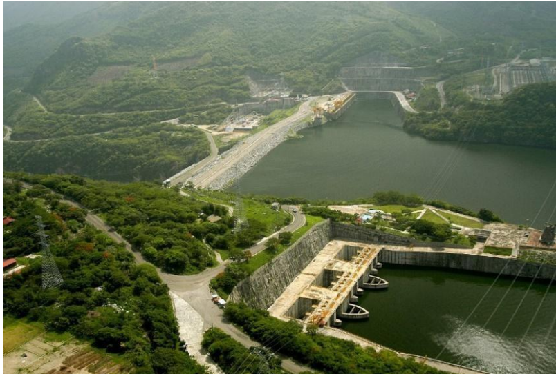
Figura 1.2 Foto aérea de la Presa Peñitas. Fuente: (López, Presa Peñitas, 2022).
