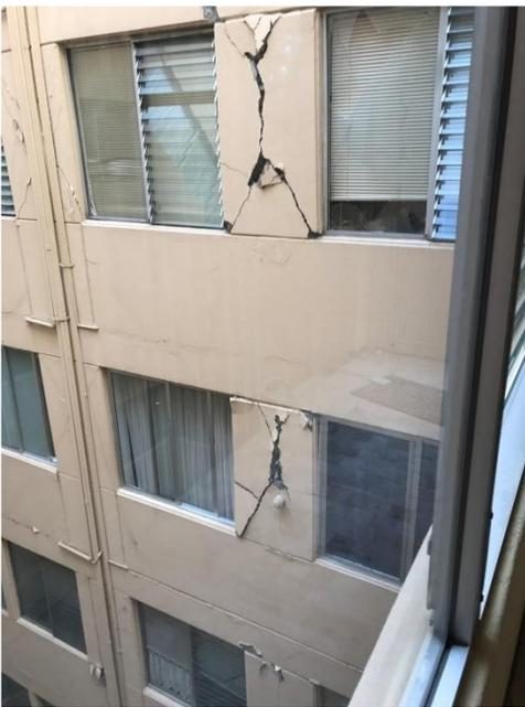
DAÑO EN MUROS NO ESTRUCTURALES, PERO CON RIESGO DE COLAPSO
