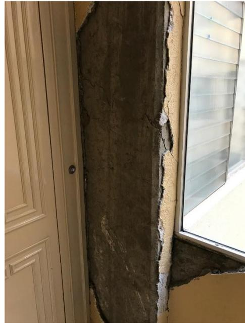
DAÑO IMPORTANTE EN COLUMNAS POR COMPRESIÓN Y CORTANTE
