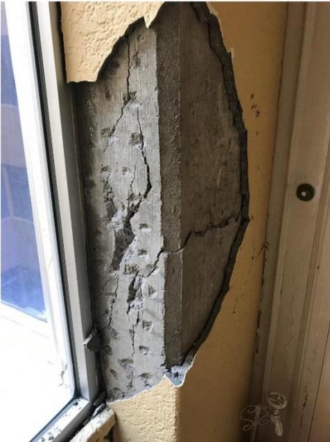
DAÑO IMPORTANTE EN COLUMNAS POR COMPRESIÓN Y CORTANTE
