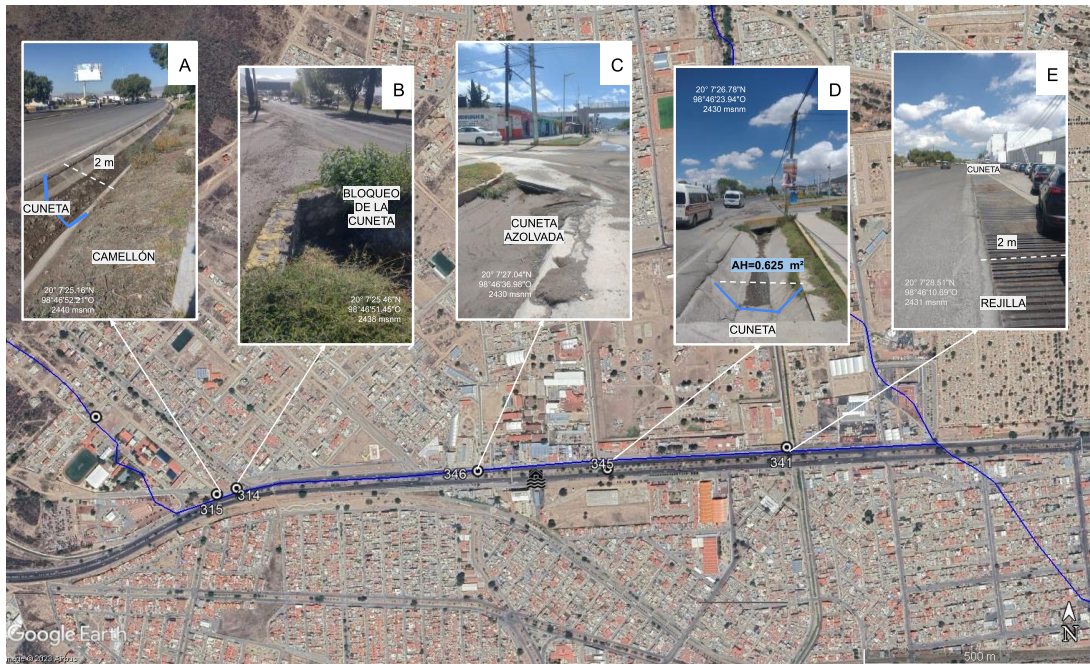
Figura 157. Imagen Satelital Google Earth con Red Hidrográfica Natural, Fotografía A: muestra que el cauce se ha transformado en una cuneta a la orilla de la carretera Actopan-Pachuca de 2 m de ancho, Fotografía B y C: cuneta azolvada que impide el flujo del agua,
