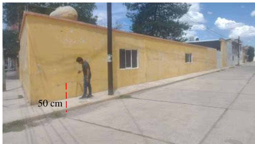
Figura 111. Fotografía con el registro del tirante de agua acumulada en pared, Calle Ócalo, Colonia el Tezontle, Pachuca de Soto.
