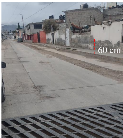
Figura 109. Fotografía con el tirante de agua acumulada, 60 cm en la pared de la vivienda. En la foto también se observa la presencia de una alcantarilla de 1 m de ancho, no obstante, el agua se acumuló en esta zona, Calle del Chopo, Colonia El Tezontle, Pachuca de Soto, Hidalgo.
