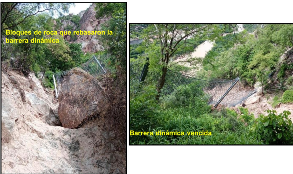
Fotografía 4. Afectaciones originadas en la zona 2
