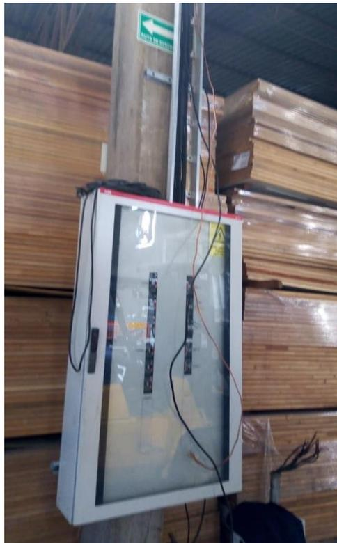
*Figura 20. Instalación de tableros eléctricos secundarios. (Archivo propio)*
