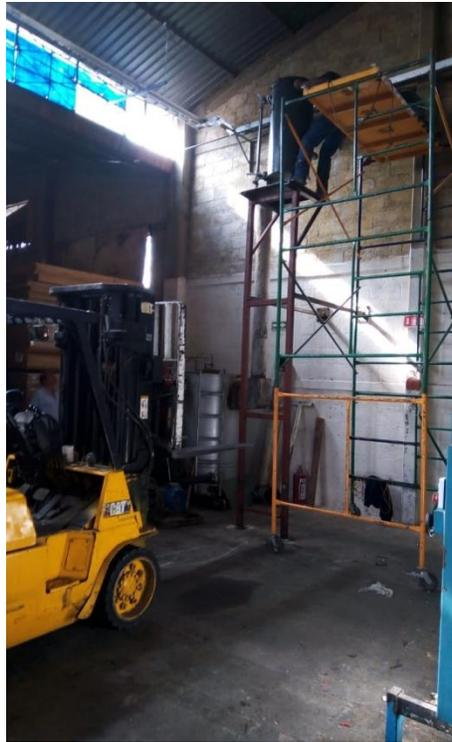
*Figura 19. Instalación de tanque de expansión de caldera. (Archivo propio)*
