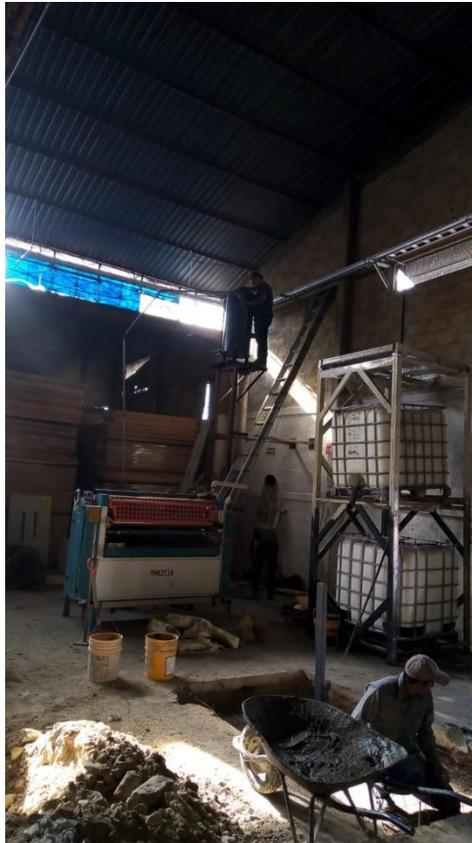
*Figura 21. Obra civil para instalación de encoladora y equipos auxiliares . (Archivo propio)*
