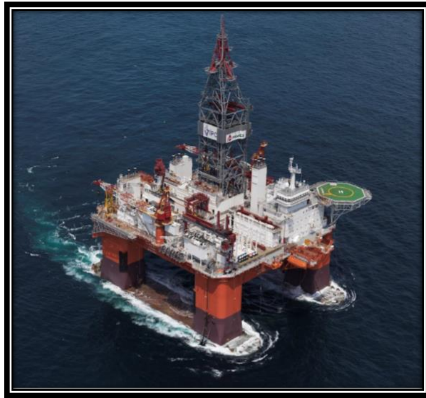
Figura 25 Plataforma La Muralla IV. (PEMEX, 2016)
