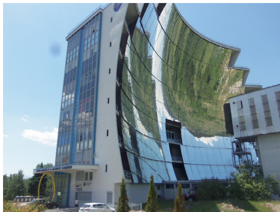
Figura 1. Horno solar de 1 MW de Odeillo, Francia [1].
