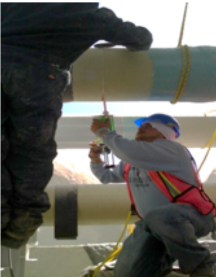
Figura 14. Unión adhesiva en tubería de fibra de vidrio Cortesía de ASI®.
