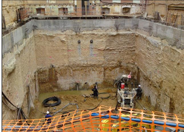
Figura 26. Ejemplo de funcionamiento de muro pantalla. [25]
