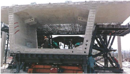
e) Colocación de Dovela anterior como tapa
