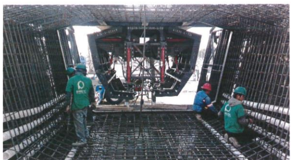
d) Colocación de armado y de corazón
