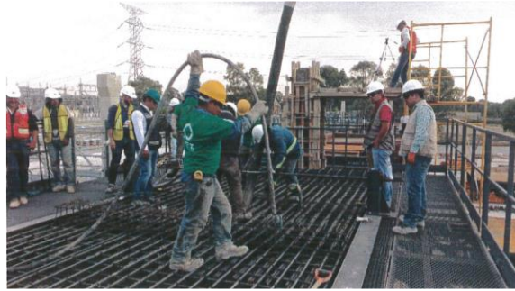
f) Colado de la Dovela, parte superior losa.
