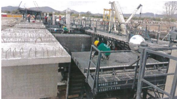
c) Limpieza del molde metálico
