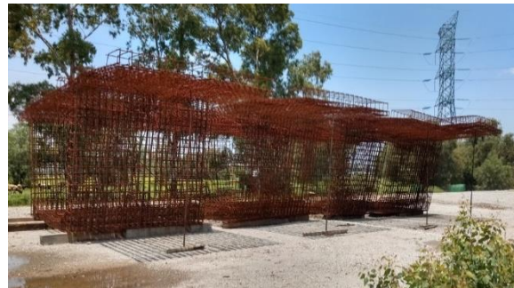
b) Estructura de acero habilitada
