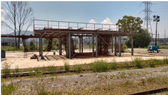
a) Habilitado de acero en molde para Dovelas
