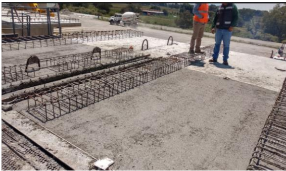
g) Final de colado y detallado de losa
