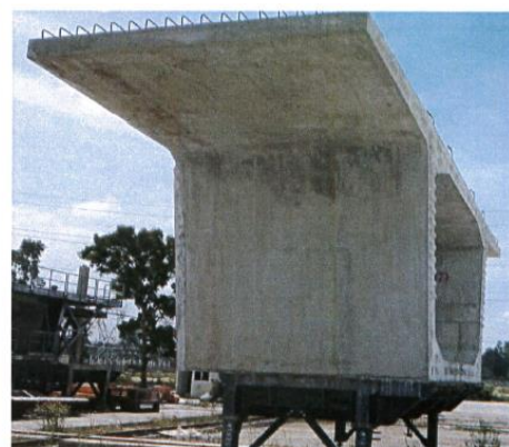
j) Dovela desmoldada secciones transversal, lista para rotulación
