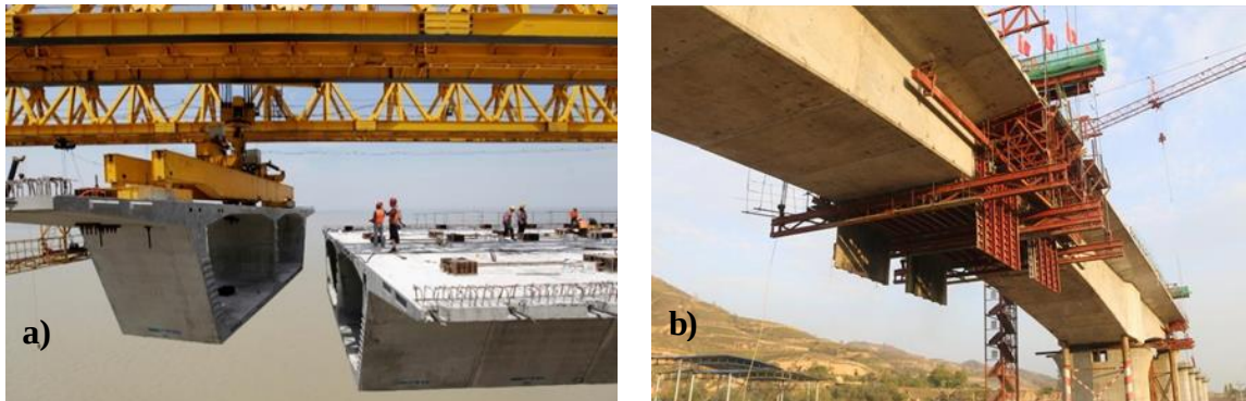
Figura No. 5.2 a) Colocación de la Dovela con la Cimbra autolanzable.
