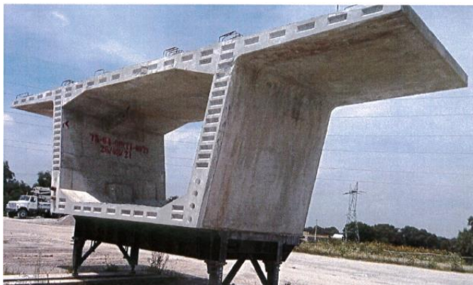
i) Dovela lado ancho, sección de cara dentada para colocación con la siguiente.
