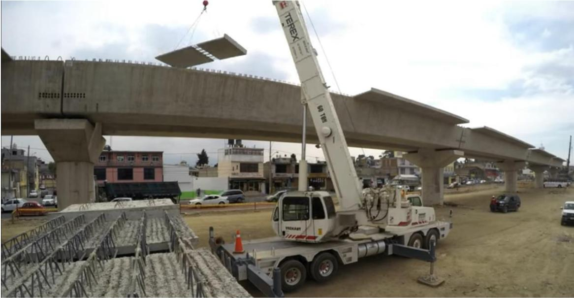
Imagen 4.57. Colocación de tabletas prefabricadas vía doble en claros isostáticos
