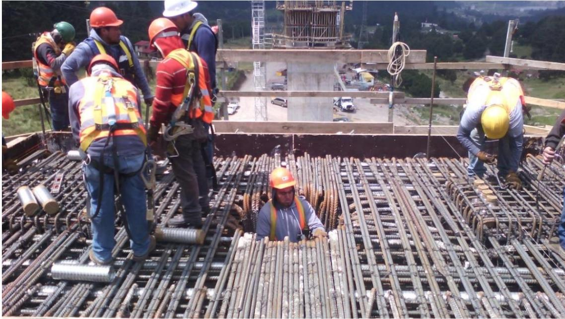
Imagen 4.36. Armado de refuerzo de la segunda fase de cabezal con las preparaciones para los bancos de los apoyos esféricos y el hueco de inspección
