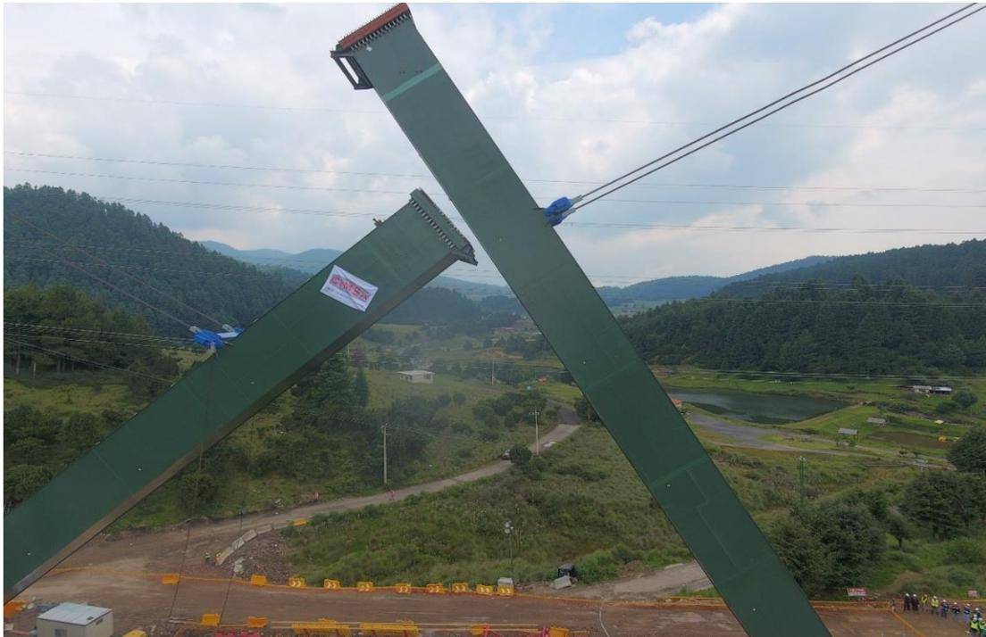
Imagen 5.15. Izaje de segunda columna 30 cm de separación en giro
