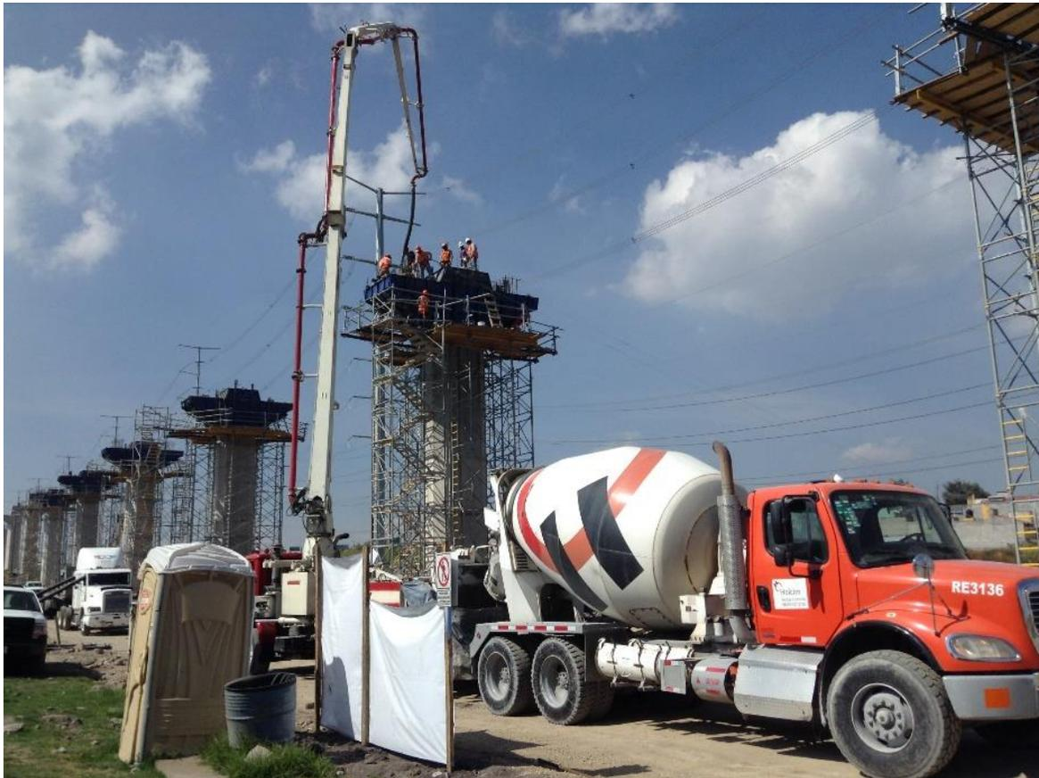
Imagen 4.29. Colado de cabezal de vía doble
