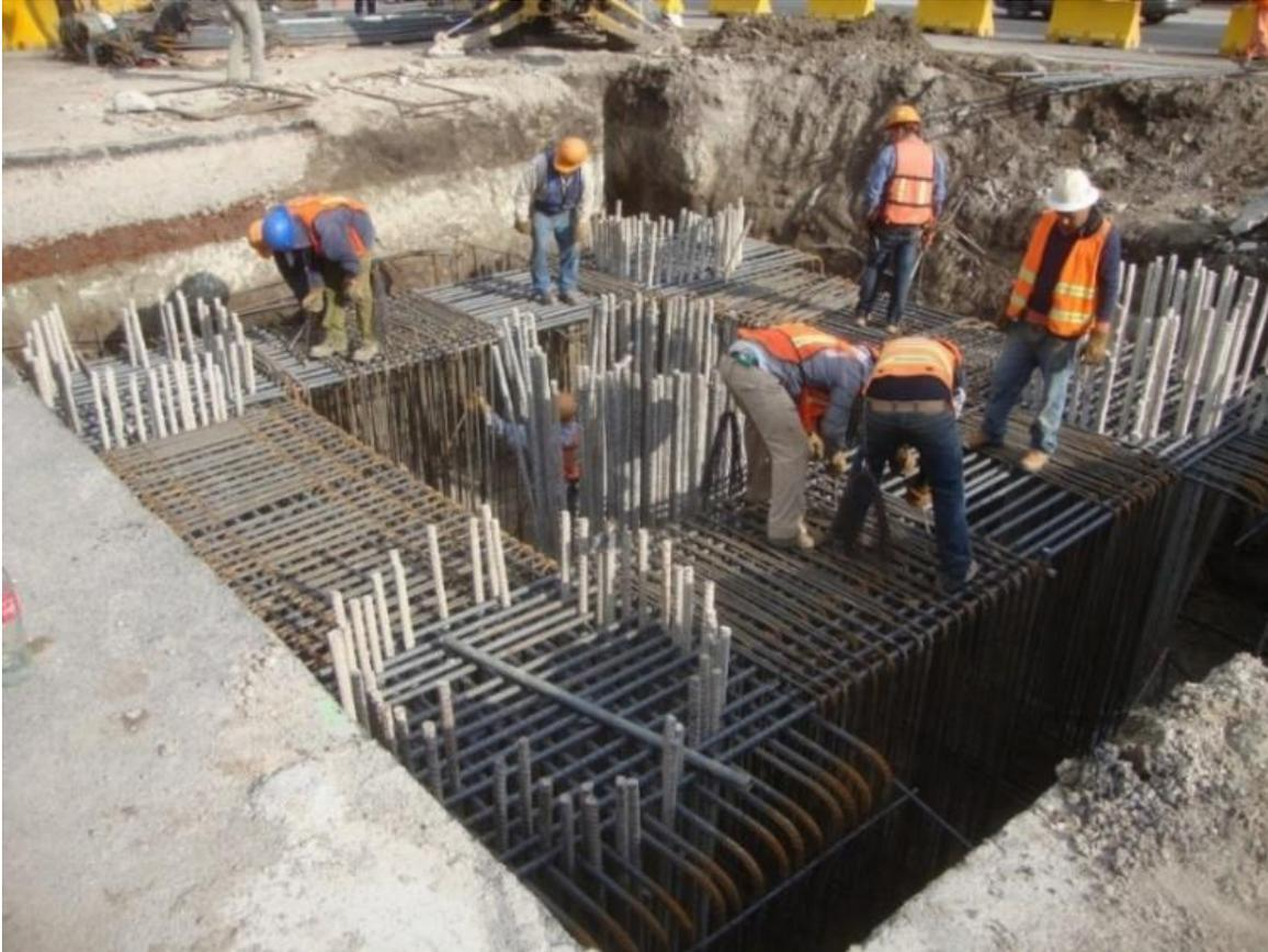
Imagen 3.18. Zapata de cinco pilas
