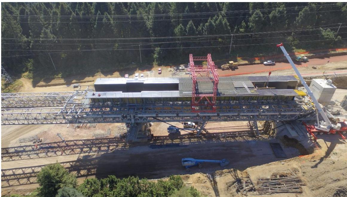
Imagen 4.74. Colocación de armado con ayuda de la grúa pórtico
