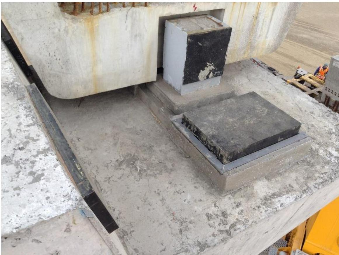
Imagen 4.30. Colocación de neoprenos
