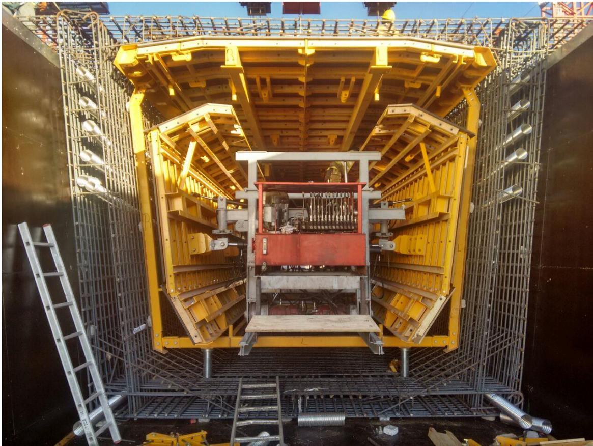
Imagen 4.76. Carro para avance e instalación de encofrado interior
