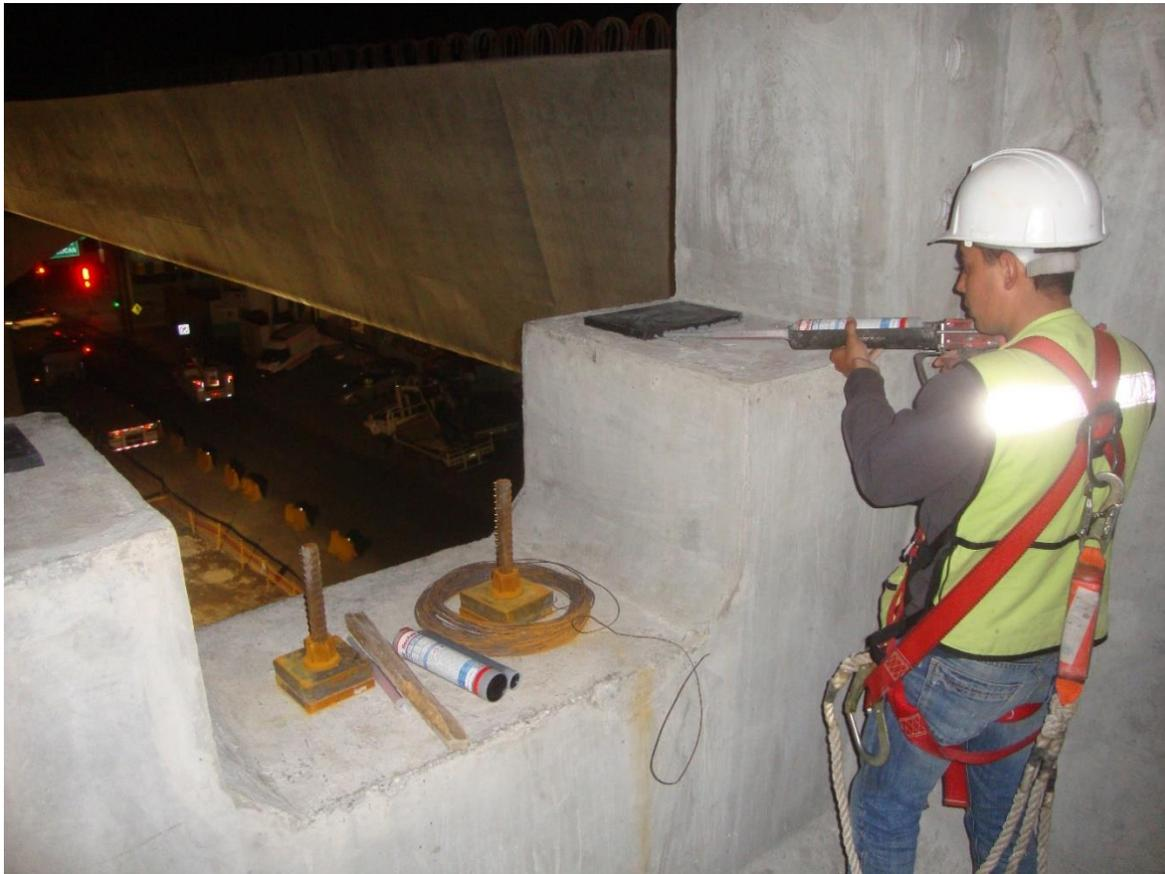
Imagen 4.48. Colocación de neoprenos y aseguramiento de con barras tipo Gewi
