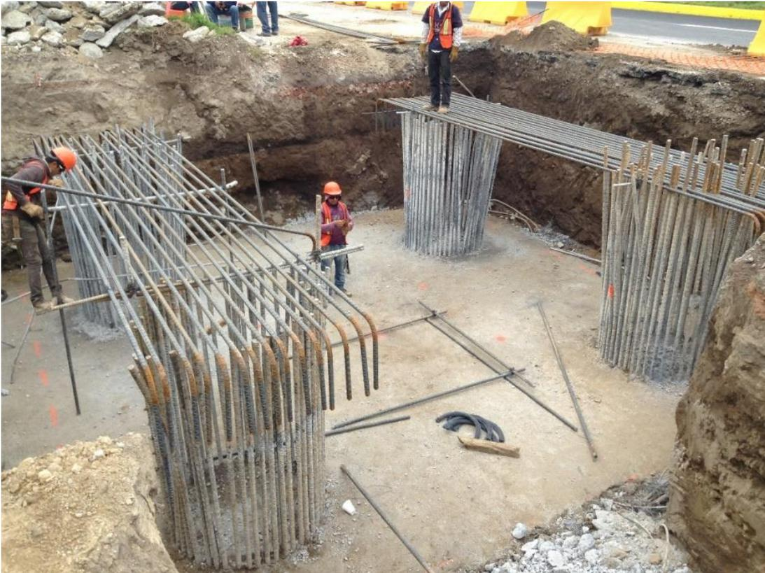
Imagen 3.13. Colocación de capas superiores
