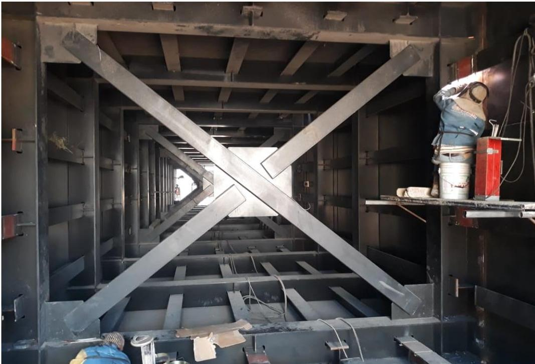
Imagen 5.9. Soldadura de unión en interior de dovelas
