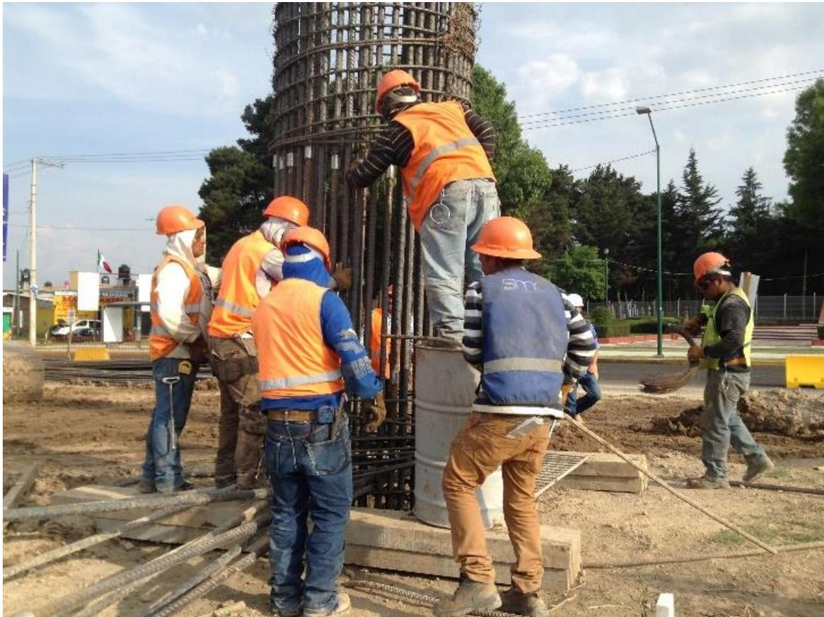
Imagen 3.7. Acople de ambas secciones
