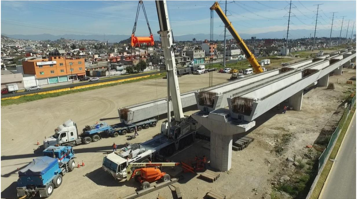
Imagen 4.45. Montaje de traves vía doble
