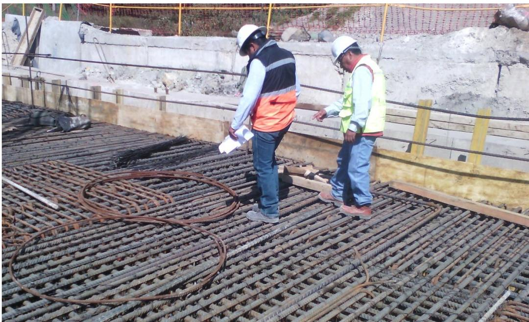
Imagen 5.38 Revisión en conjunto Supervisión y contratista de acero de refuerzo para zapatas
