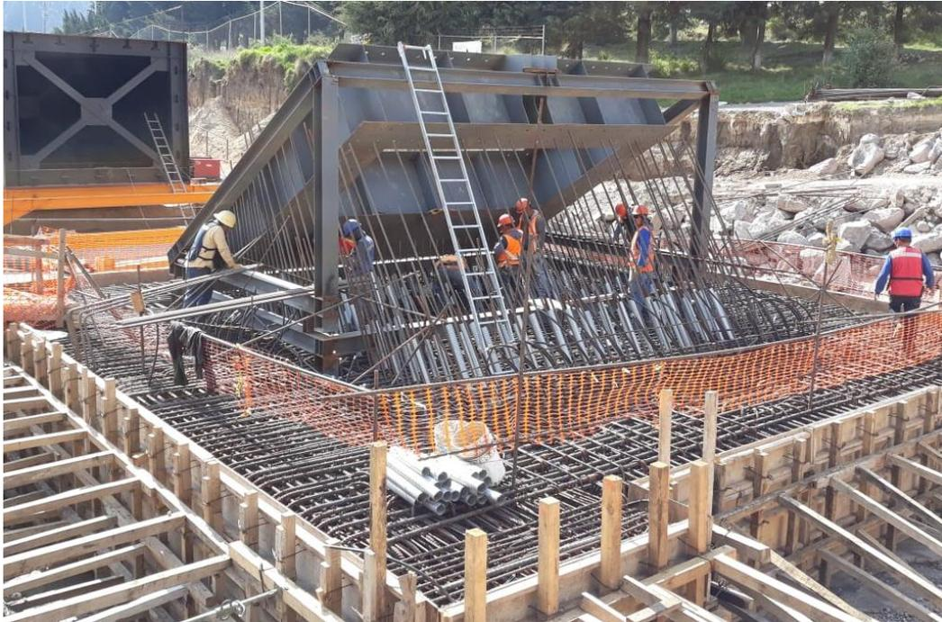
Imagen 5.5. Colocación de plantilla para barras de sujeción de en la cimentación
