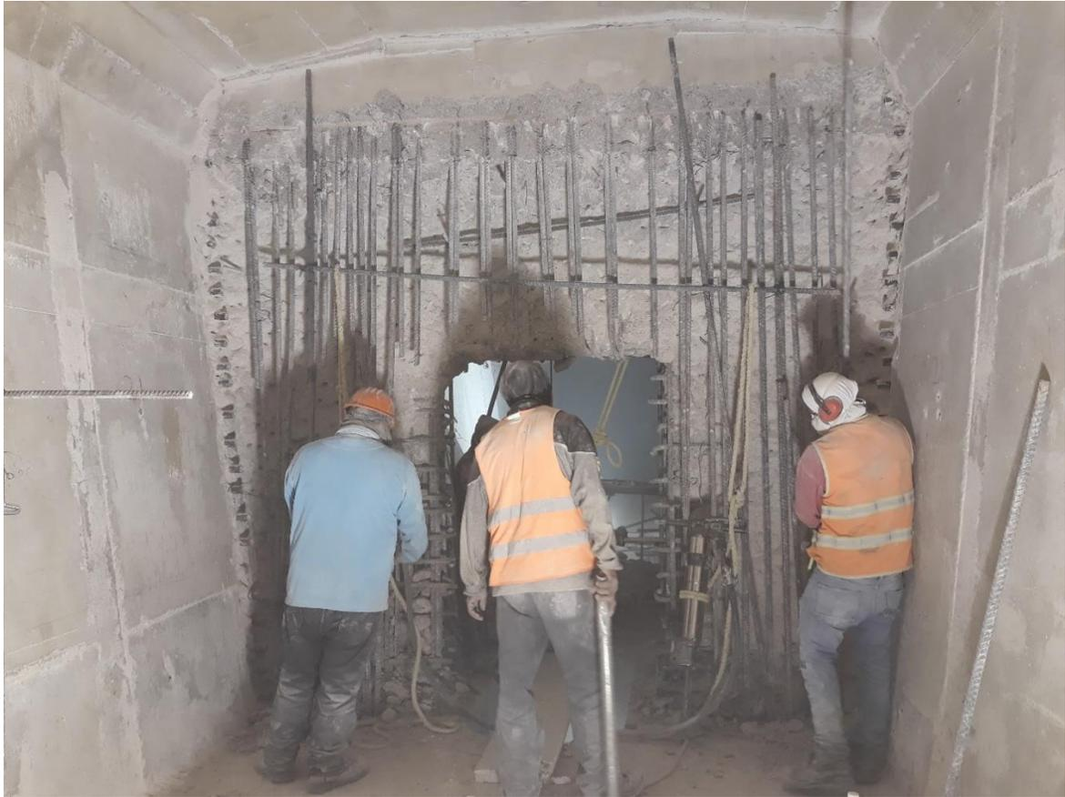
Imagen 6.9. Demolición de diafragma viaducto 4
