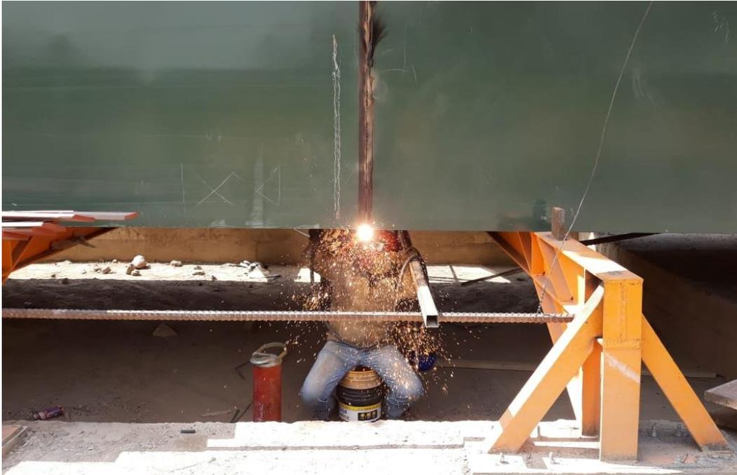
Imagen 5.8. Unión entre dovelas intermedias en posición horizontal
