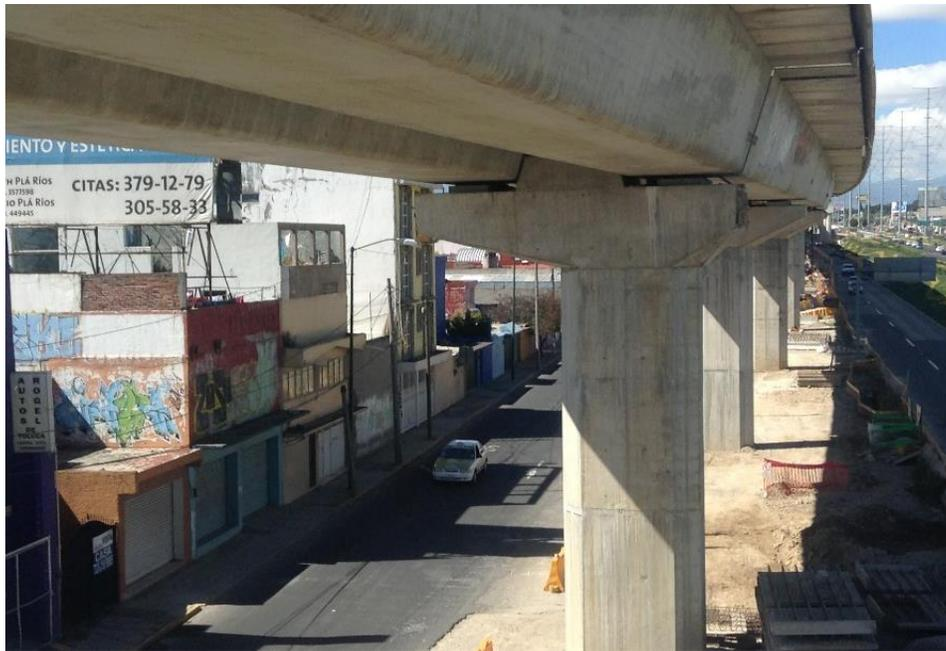
Imagen 4.25. Cabezal especial postensado por la excentricidad de las traves.
