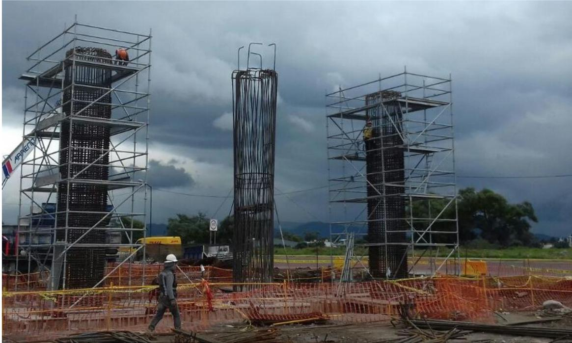
Imagen 4.1. Zapata con tres columnas
