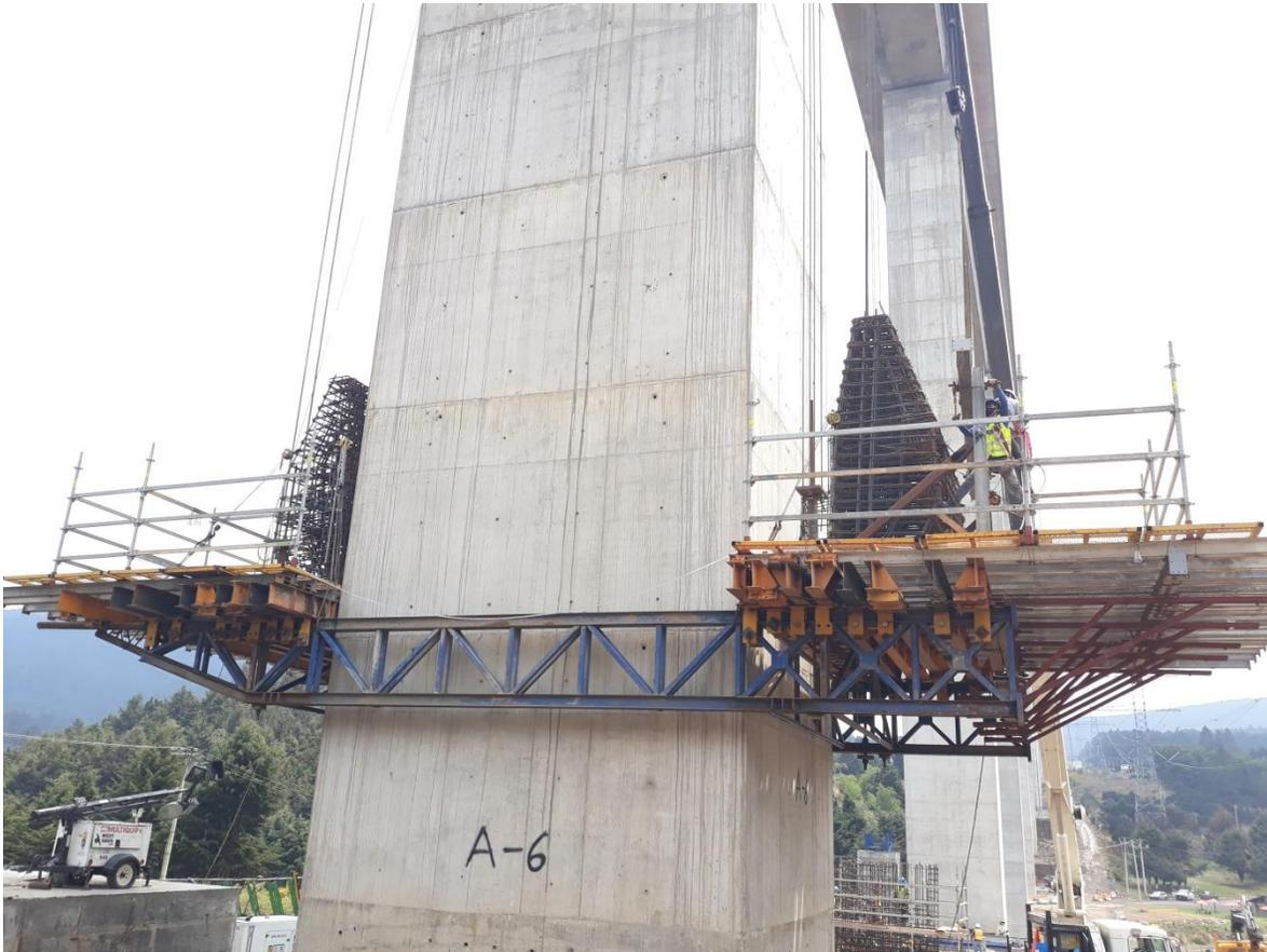
Imagen 5.24 Izaje de plataforma con armado para topes
