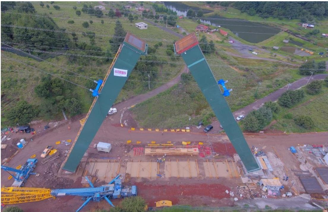
Imagen 5.16. Columna en posición para fijación
