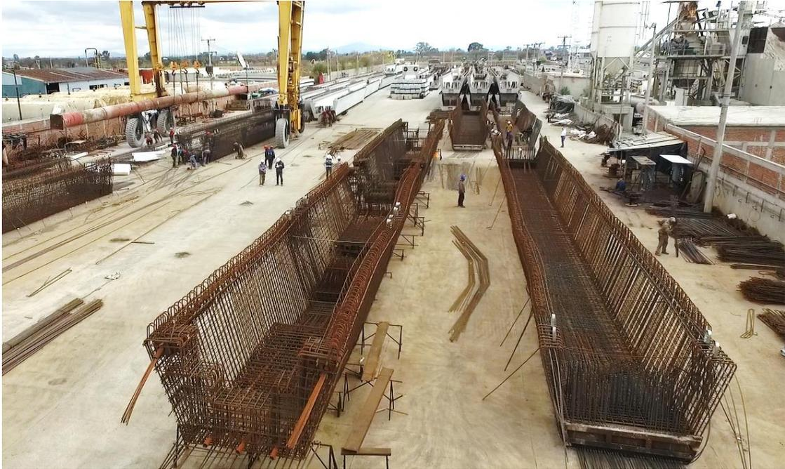
Imagen 4.40. Armado de refuerzo de trabes
