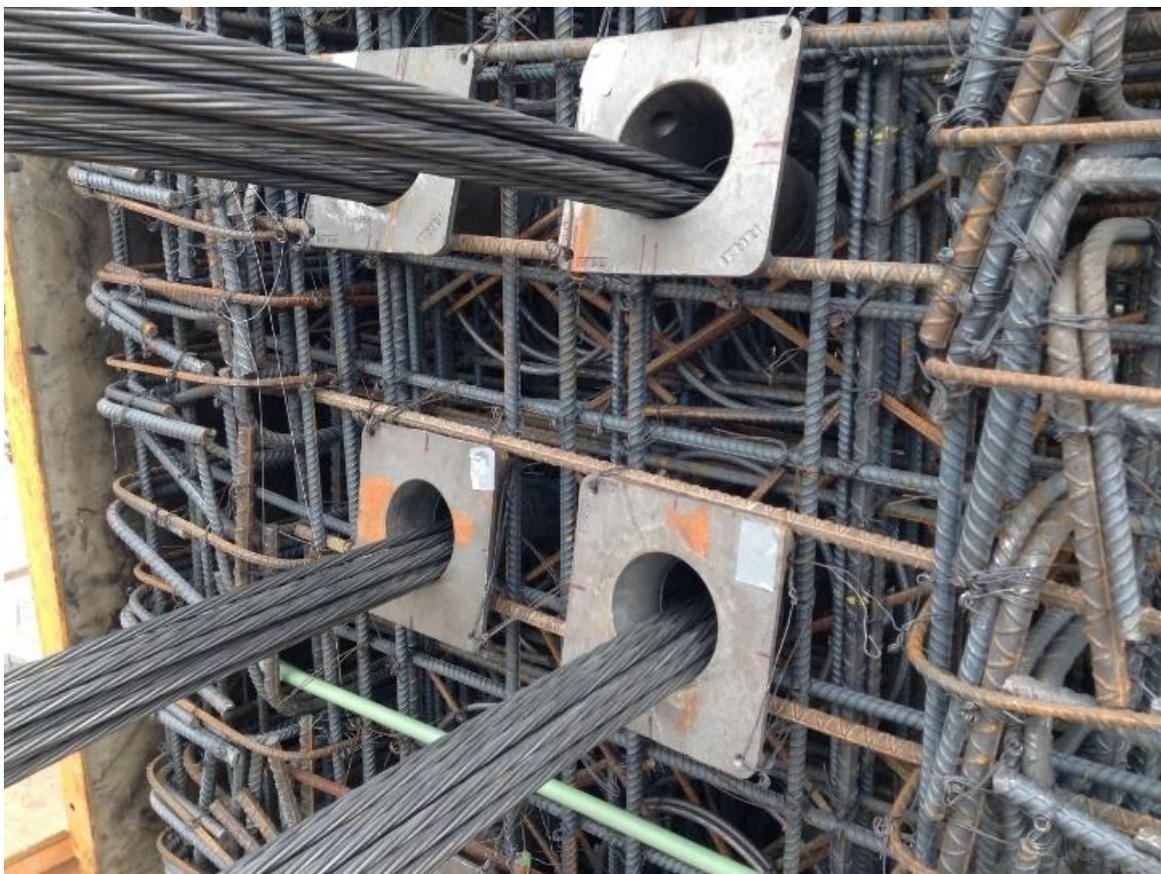
Imagen 4.32. Colocación de tendones y trompetas para postensado
