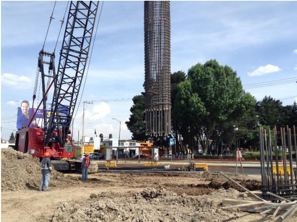
Imagen 3.6. Izaje de la segunda sección del armado
