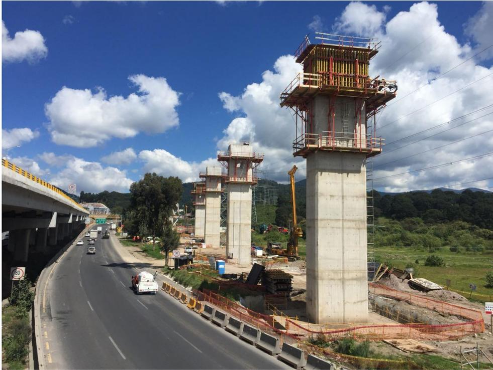
Imagen 4.12. Columnas con cimbra trepante viaducto 2 tramo 1
