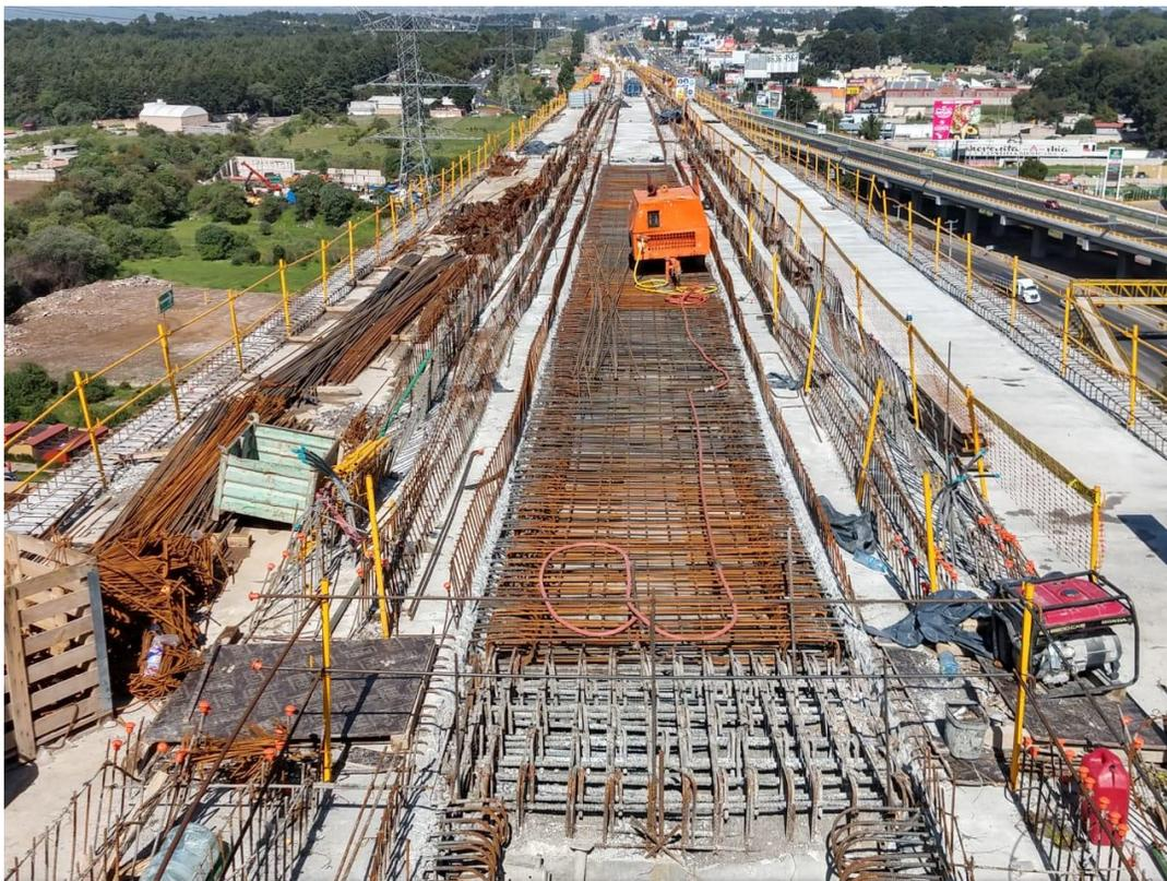
Imagen 4.92. Armado de segunda fase de tablero.
