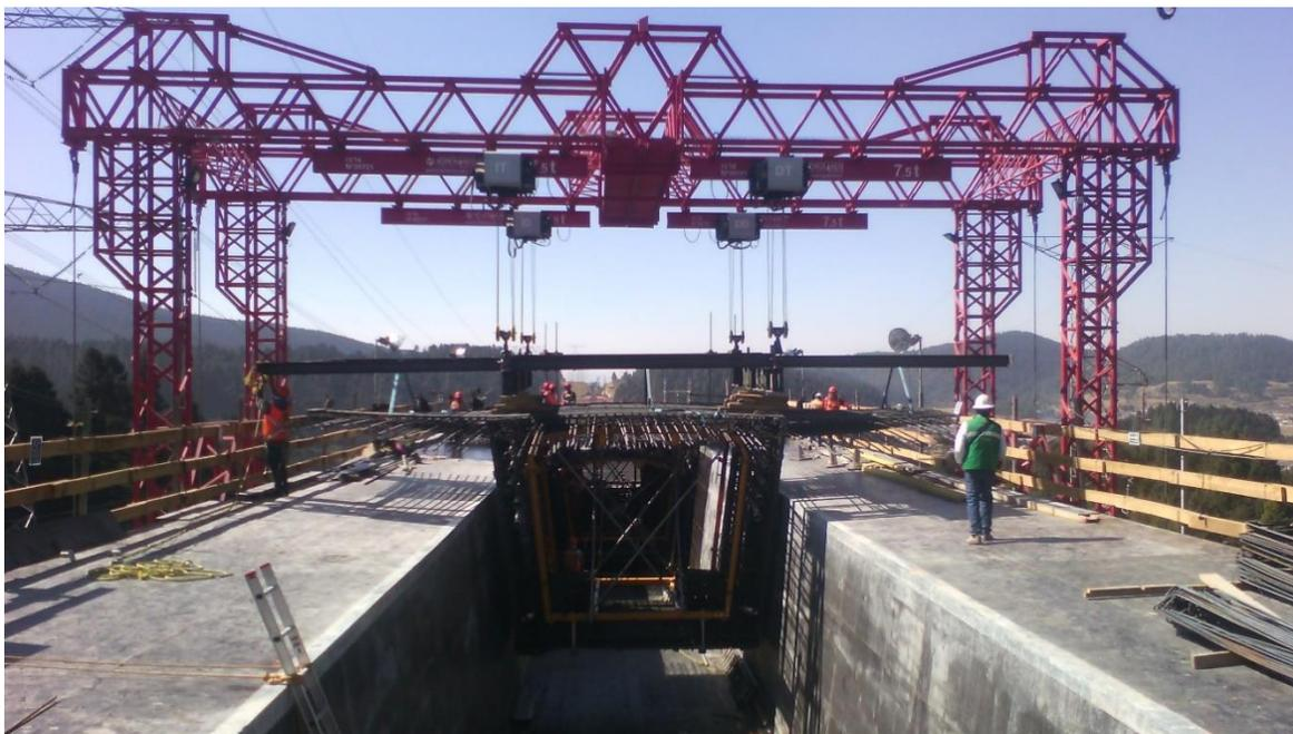
Imagen 4.75. Montaje de segmentos de armado de refuerzo con ductos para presfuerzo
