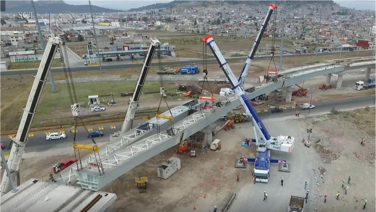
Imagen 5.1 Montaje de traves metálicas en curva
