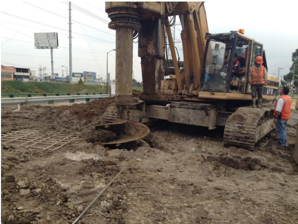
Imagen 3.2. Perforadora MAIT con broca dientes tipo bala al inicio de la perforación.
