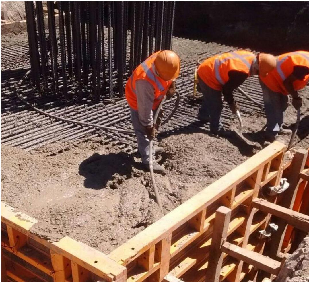
Imagen 3.15. Colado de zapata vibrado de concreto hidráulico
