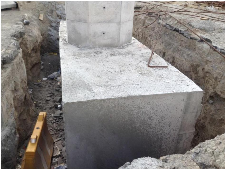
Imagen 3.17. Zapata de 2 pilas de cimentación
