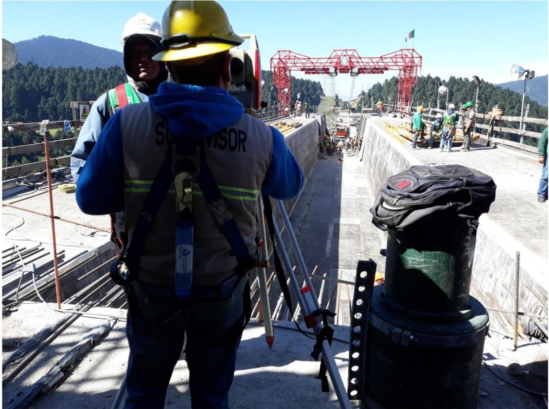
Imagen 5.43 revisión de alineación y niveles de cimbra previo a colocación de armados para tablero por parte de la supervisión.
