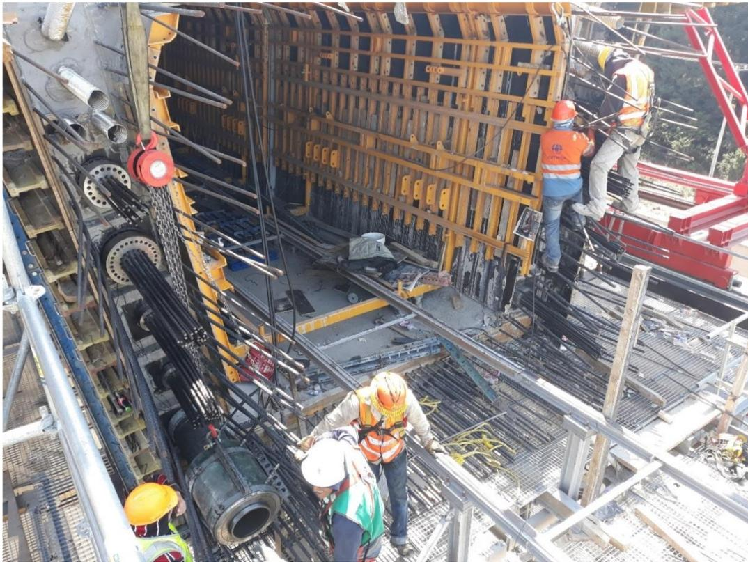
Imagen 4.81. Tensado de acero de presfuerzo
