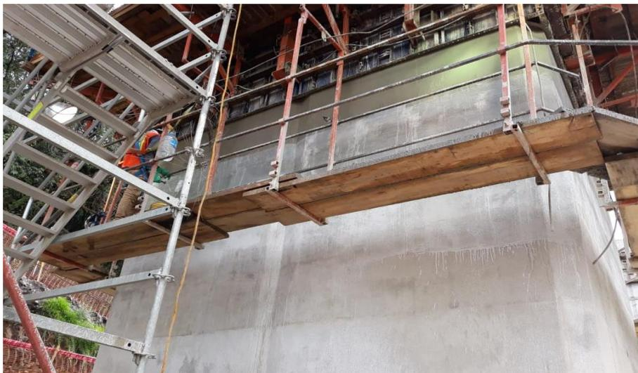
Imagen 4.16. Acabado de columna con cimbra deslizable
