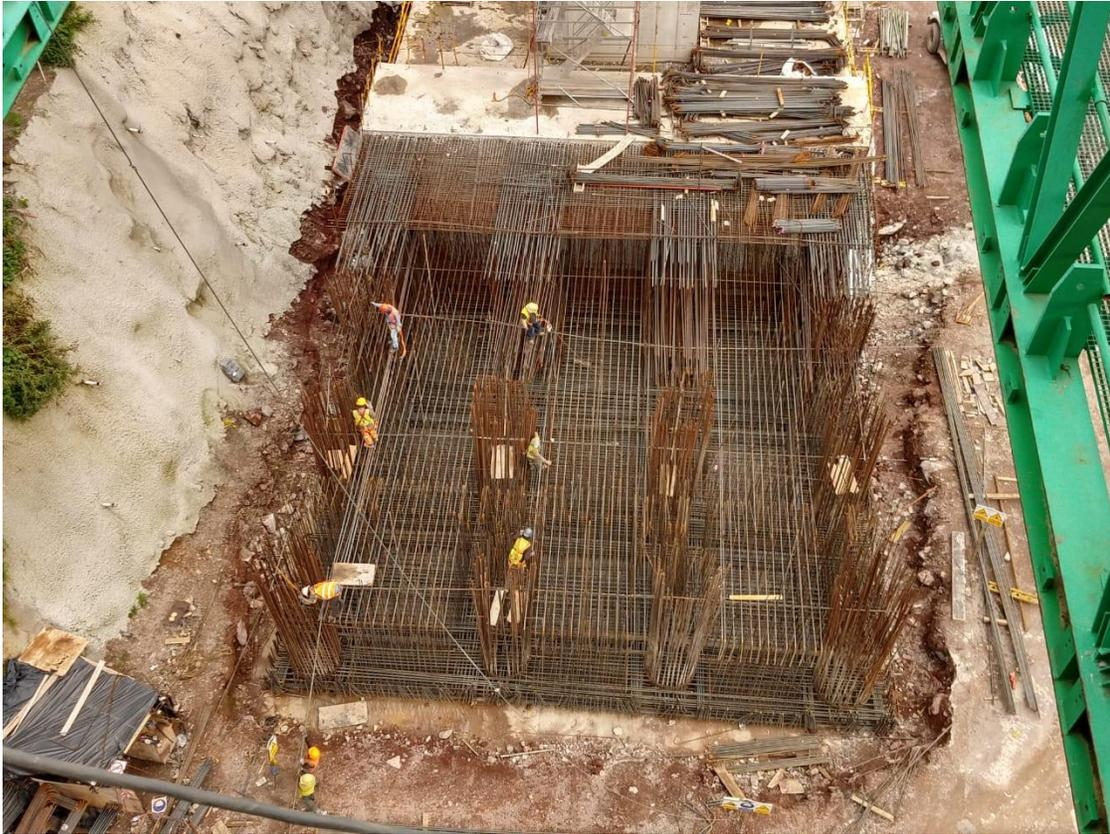
Imagen 3.24 armado de zapata para columnas con tablero de autocimbra.
