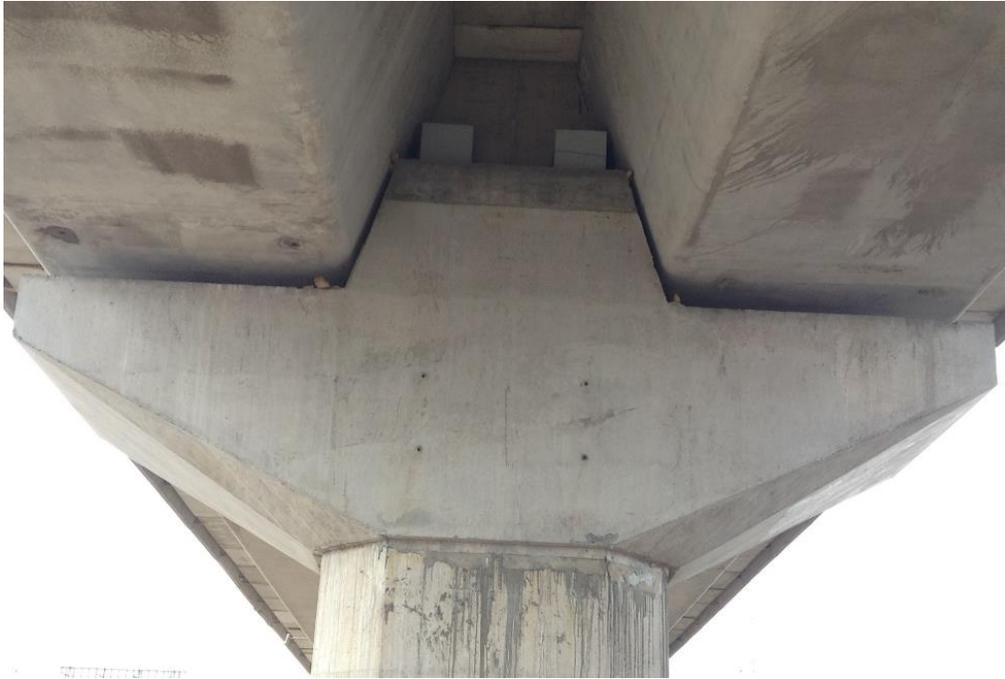
Imagen 4.20. Cabezal de claros continuos para cruce de Vialidades o cambios de vía con topes de restricción en la cresta.
