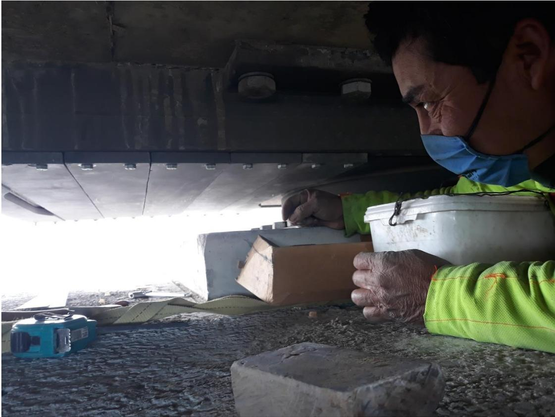
Imagen 5.29 Colocación de tapas de apoyos esféricos
