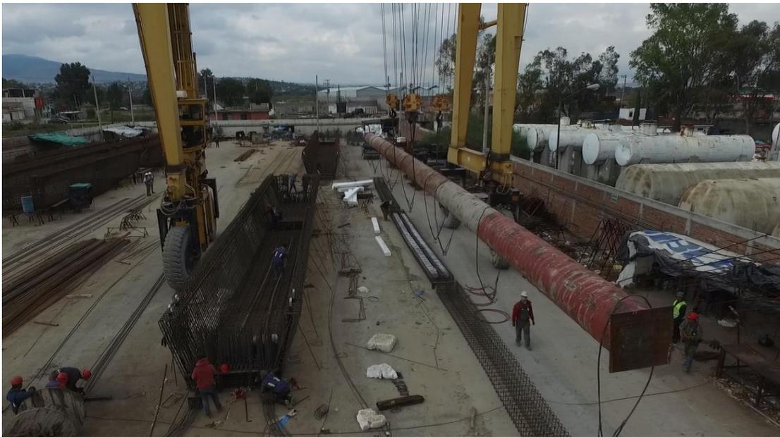
Imagen 4.41. Colocación de tendones para pretensado
