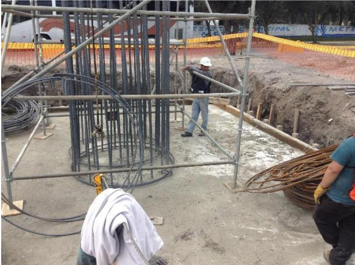
Imagen 4.2. Colocación de estribos circulares
