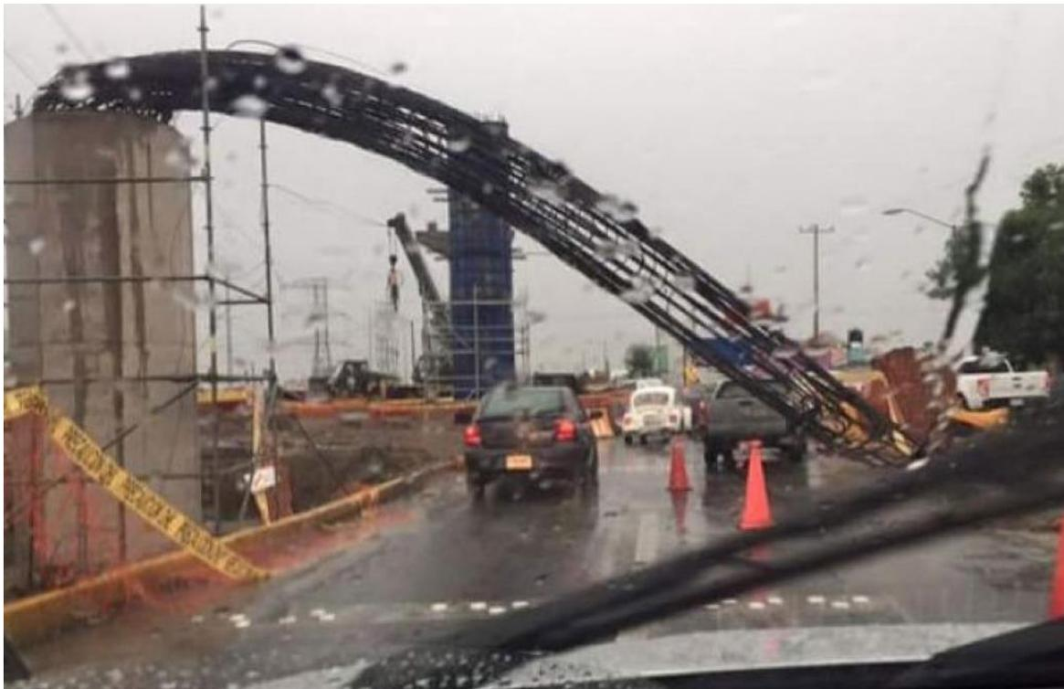
Imagen 6.5 Caída de armado sobre vialidad por accidente con contravientos.
