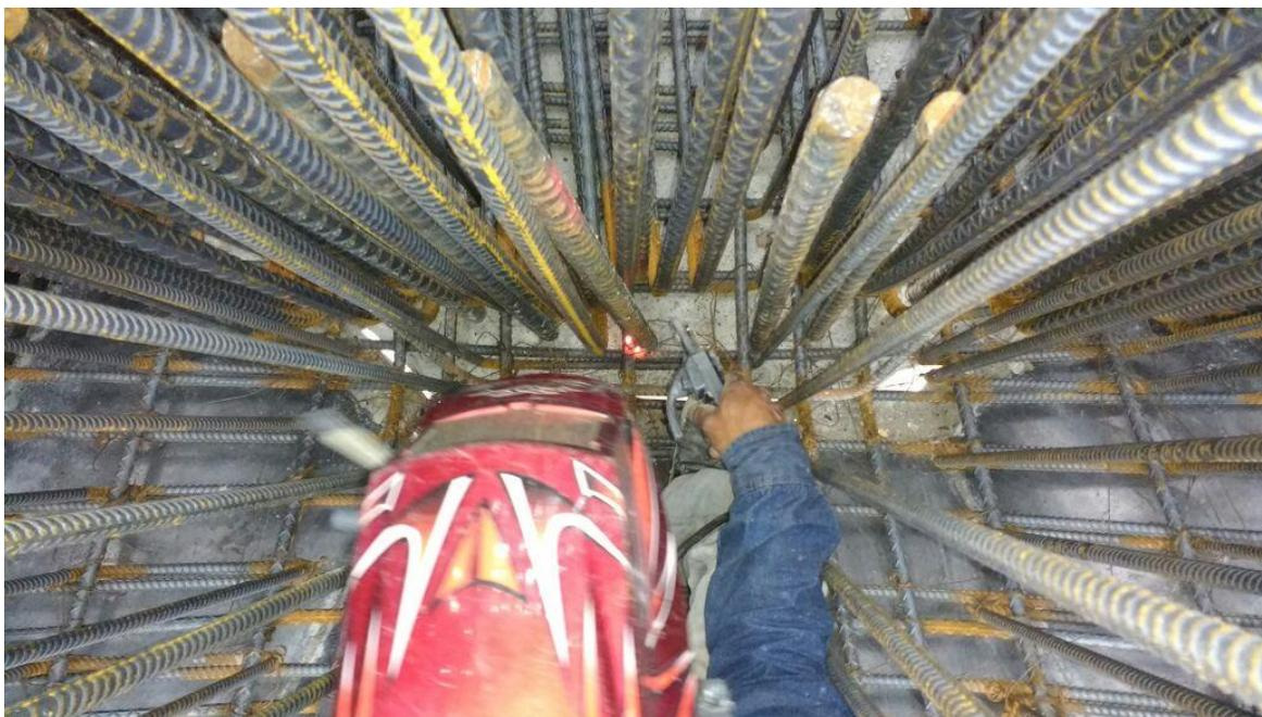
Imagen 4.28. Soldadura para dar continuidad a la tierra física
