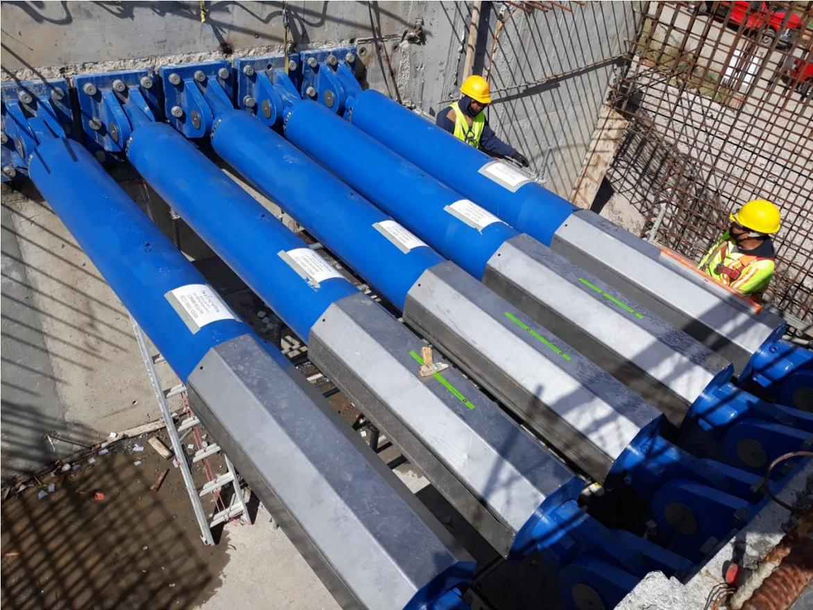
Imagen 5.30 Colocación de amortiguadores al extremo del tablero del viaducto.
