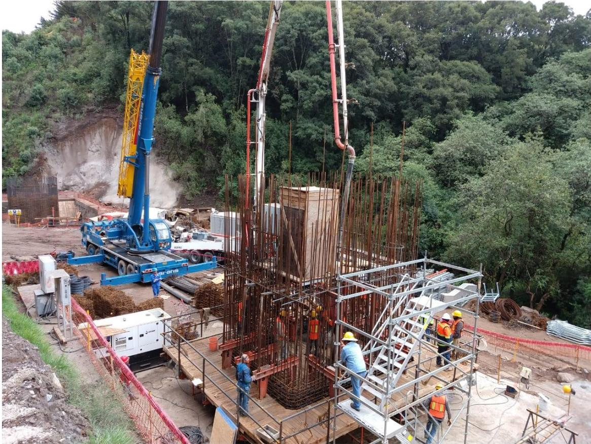
Imagen 4.13. Colado de columna con cimbra deslizando viaducto 2
