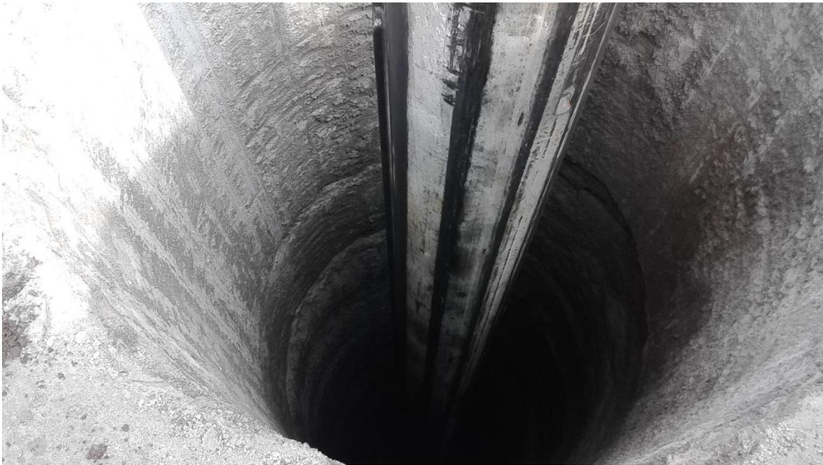
Imagen 6.41 perforación con estabilización de cavernas con concreto.
