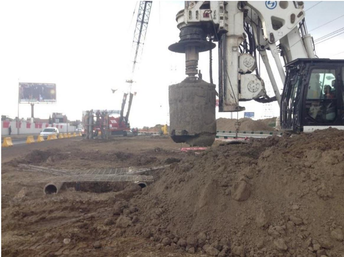
Imagen 3.3 Perforadora Soilmec con bote de rezaga.
