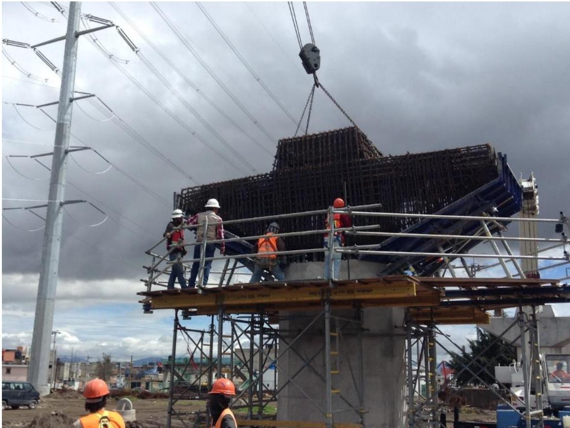
Imagen 4.27. Izaje de armadura para cabezal de vía doble
