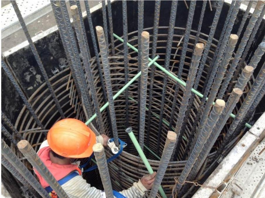
Imagen 4.5. Colocación de vainas para fijar módulos
