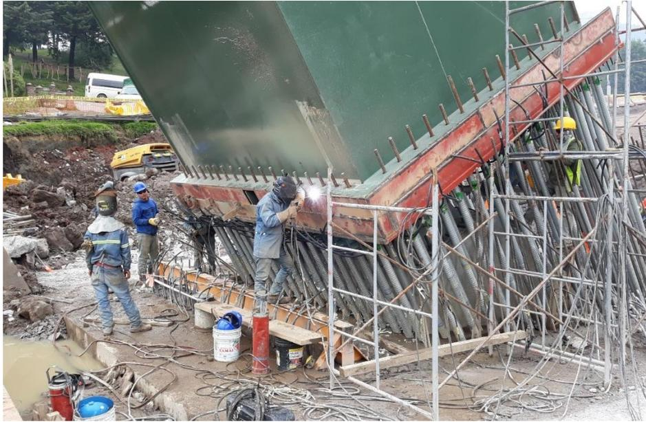
Imagen 5.17. Fijación de segunda columna con la cimentación
