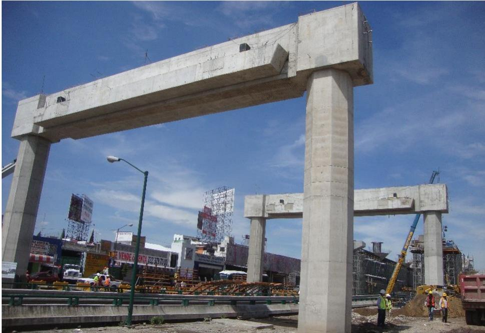
Imagen 4.24. Cabezal tipo pórtico.
