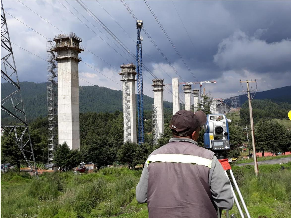
Imagen 5.35 verificación de niveles en columnas con bancos de nivel revisados
