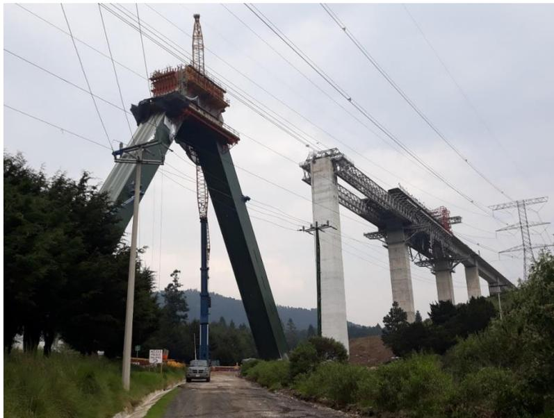
Imagen 5.20. Colado de trepados de cabezal
