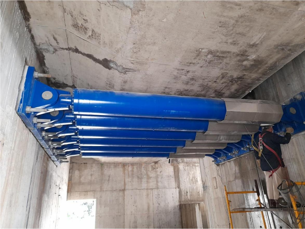
Imagen 5.31 Cámara de amortiguadores.
