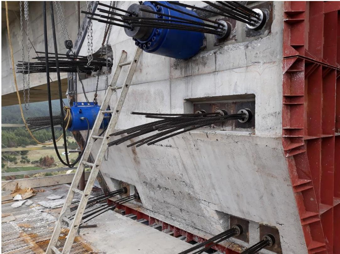
Imagen 5.44 revisión de tensado de presfuerzo tras verificar la resistencia del concreto colocado.
