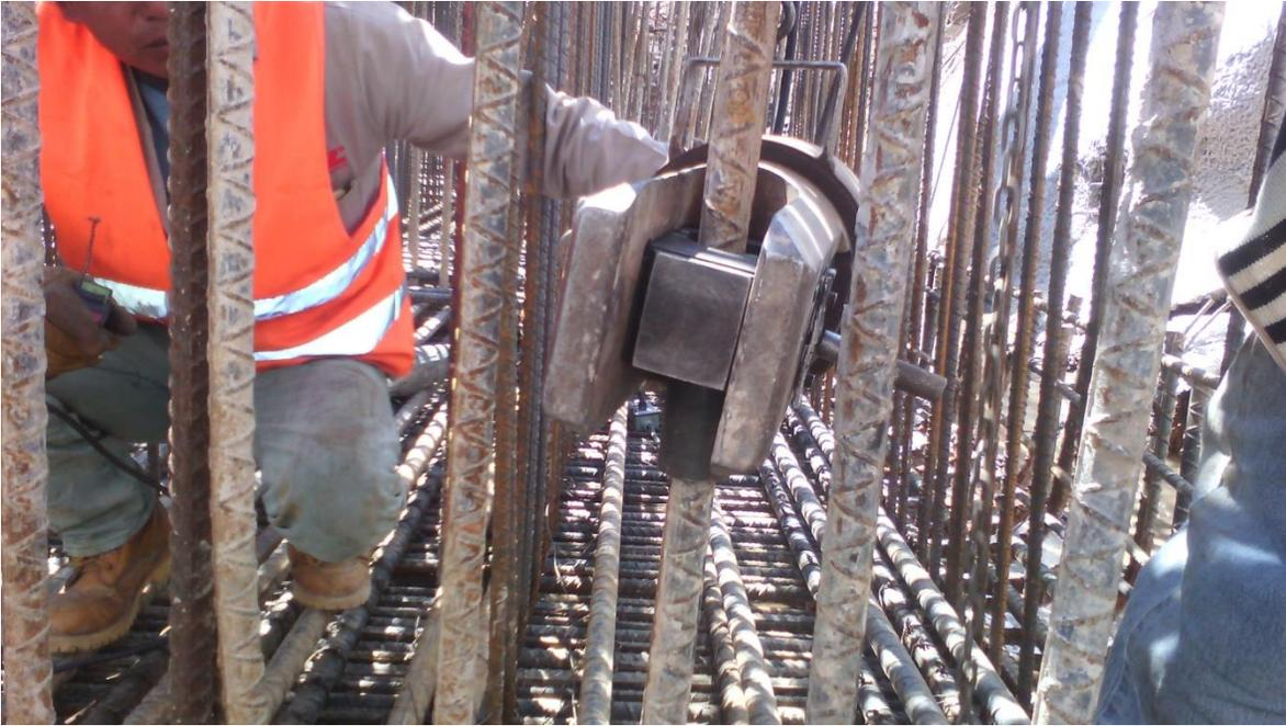
Imagen 6.42 colocación de conectores extrusionados
