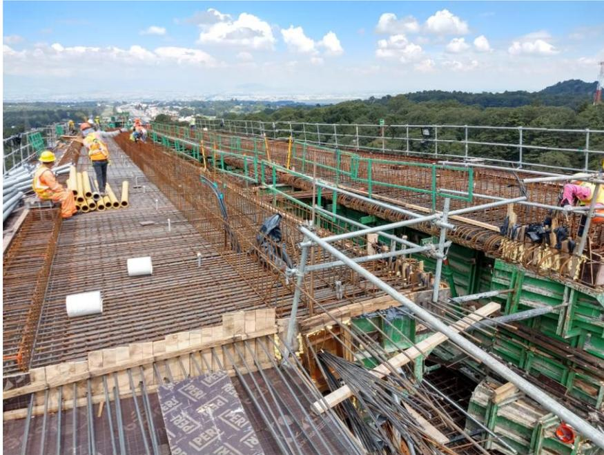
Imagen 4.89. Armado de acero de refuerzo en aleros.
