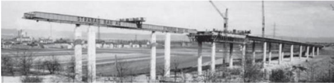
Imagen 4.65. kettiger Hangbrücke (andernach) 13 claros de 39.2m de sección cajón con cimbra autolanzable que desdoblaba la estructura de avance y la de encofrar cada claro 1959.
