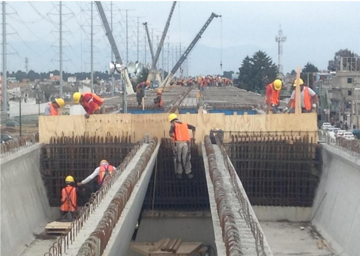
Imagen 4.52. Armado de refuerzo para diafragma vía doble
