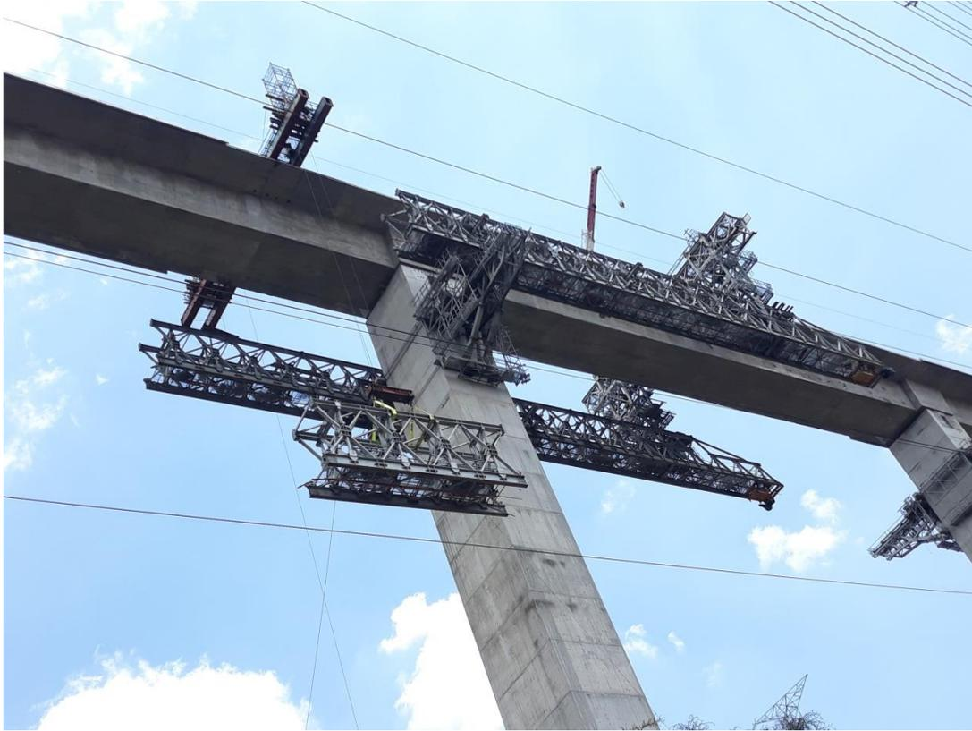
Imagen 5.22 Descenso de secciones de celosía de la armadura de la autocimbra M-64
