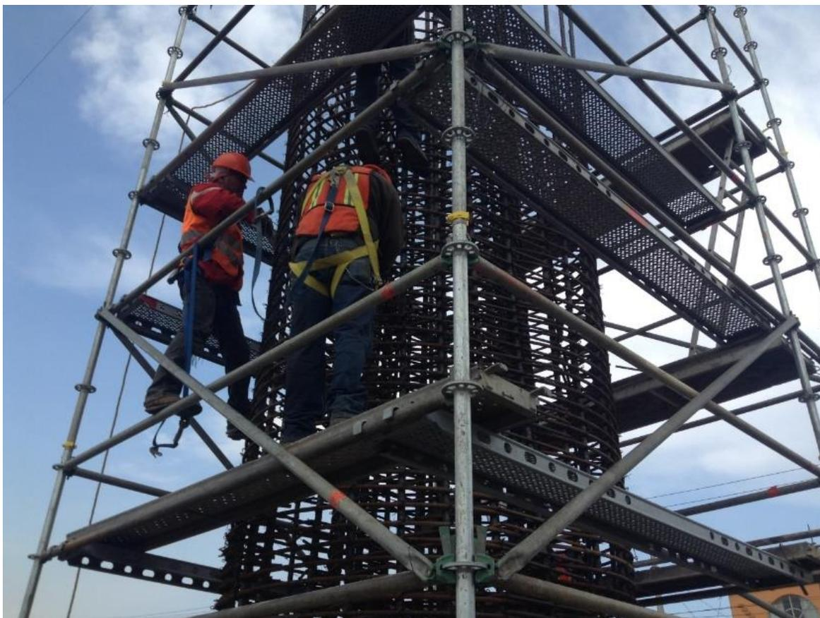
Imagen 4.3. Armado de acero de refuerzo con andamio
