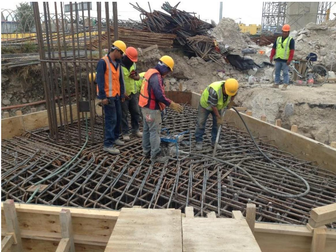
Imagen 3.22. Armado de zapata triangular
