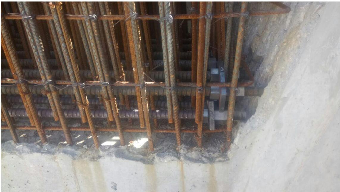
Imagen 4.53. Barras Gewi con placas tuercas y contratueras para unir las trabes transversalmente
