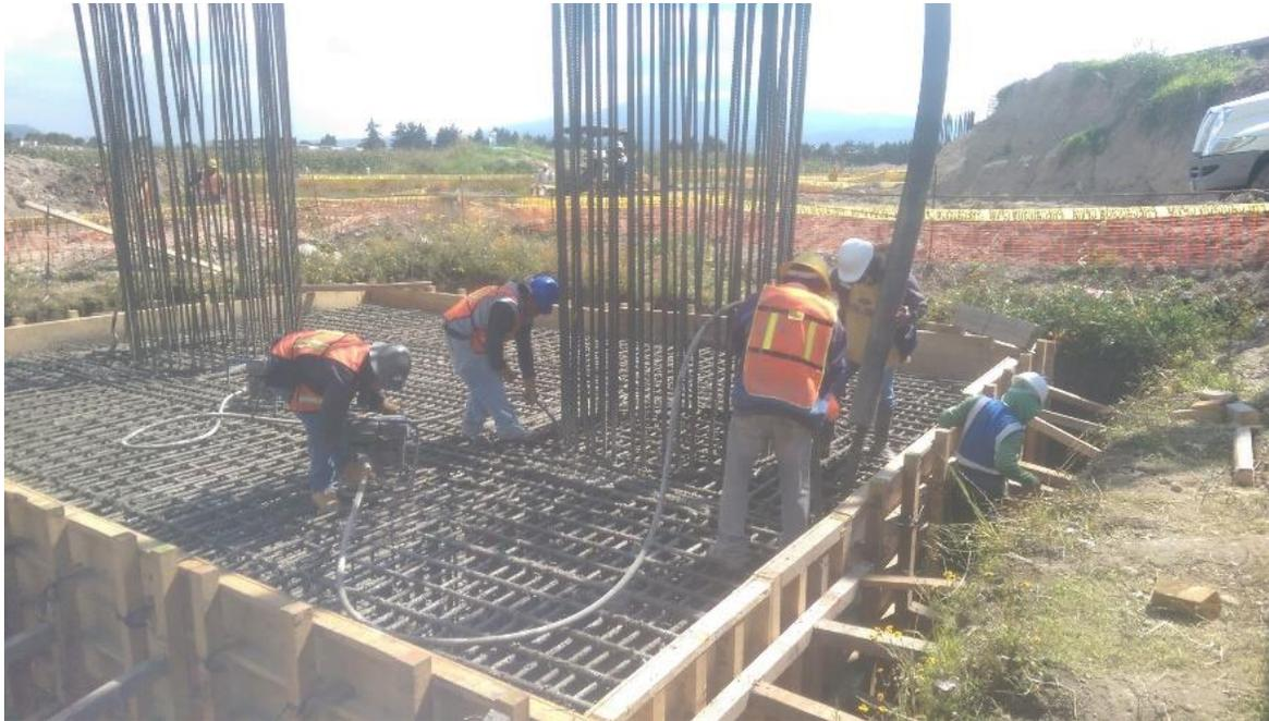
Imagen 3.20. Zapata rectangular de doble columna
