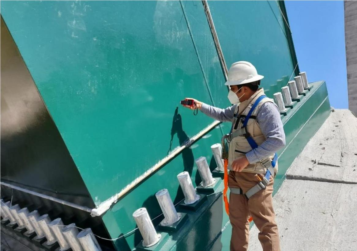
Imagen 5.41 revisión de espesores de pintura aplicados.
