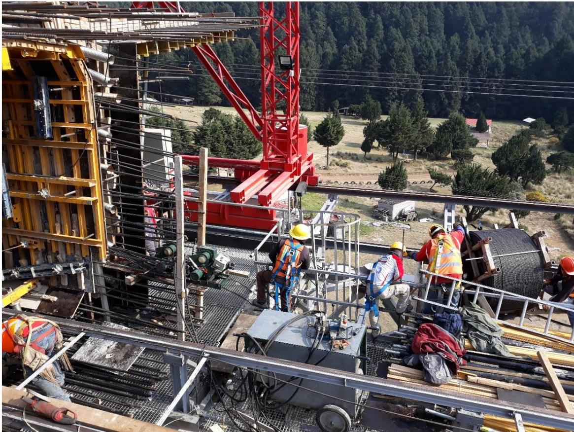
Imagen 4.78. Enfilado de acero de presfuerzo
