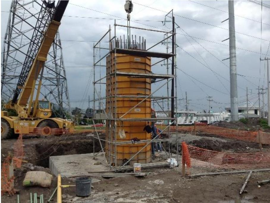
Imagen 4.4. Montaje de cimbra metálica
