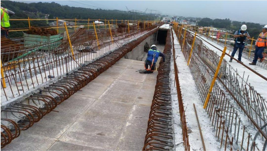
Imagen 4.91. Cimbrado de segunda fase losa central de tablero.
