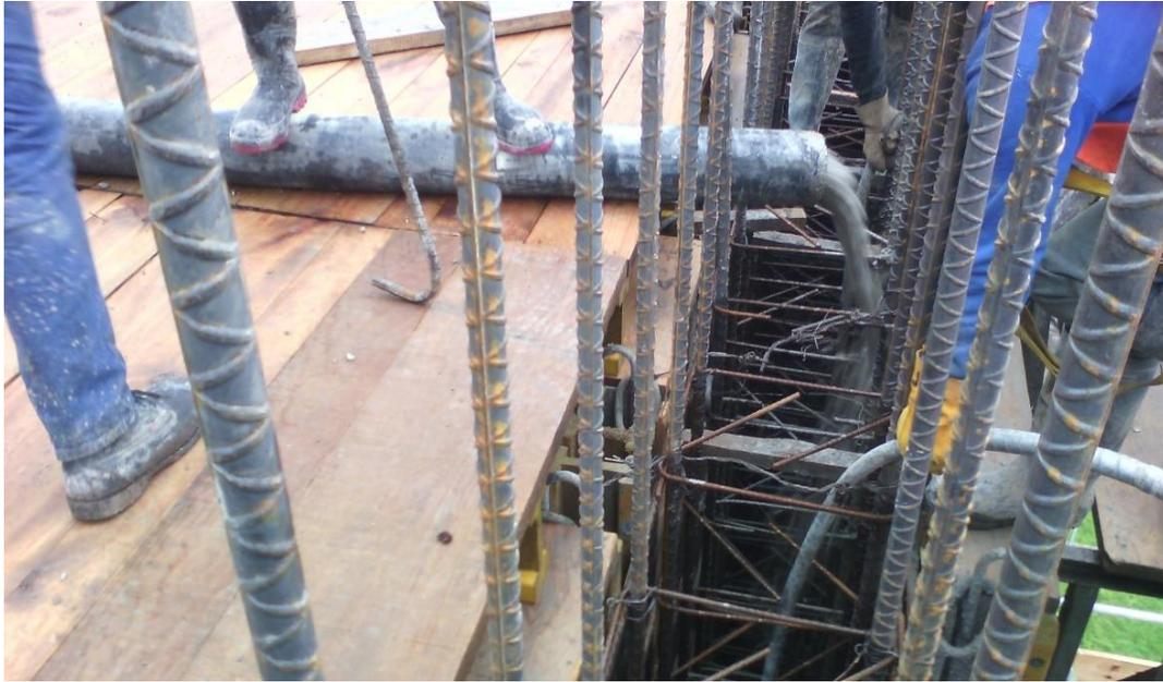
Imagen 4.10. Colado de columna con bomba estacionaria
