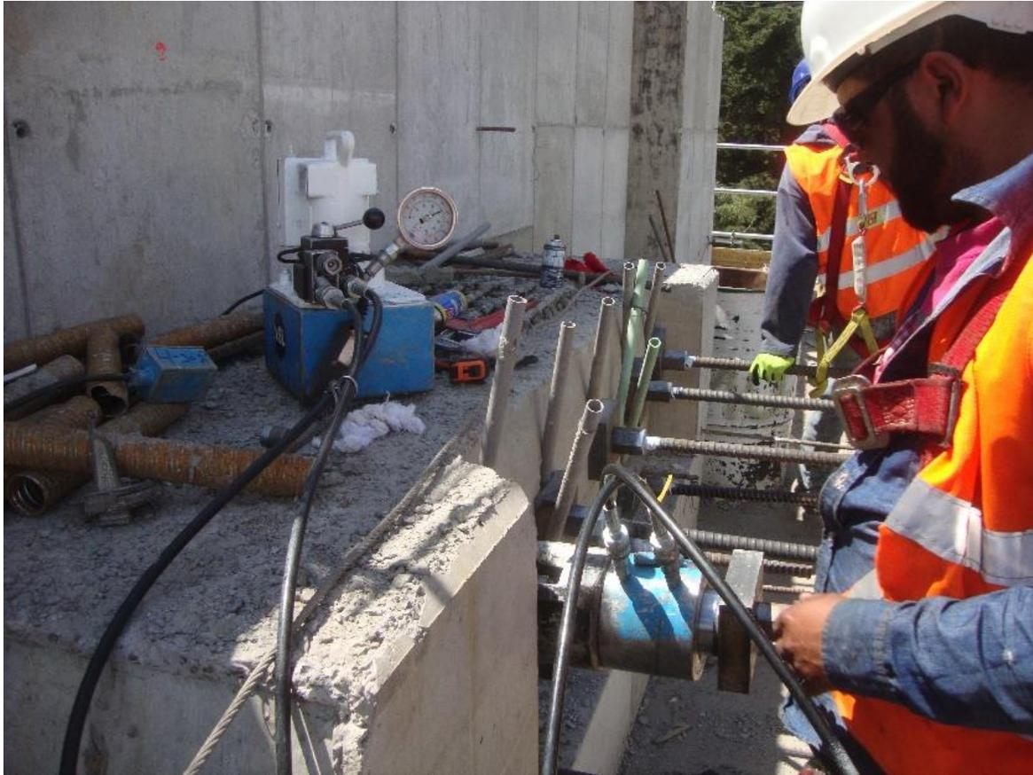
Imagen 4.34. Tensado de barras de alta resistencia
