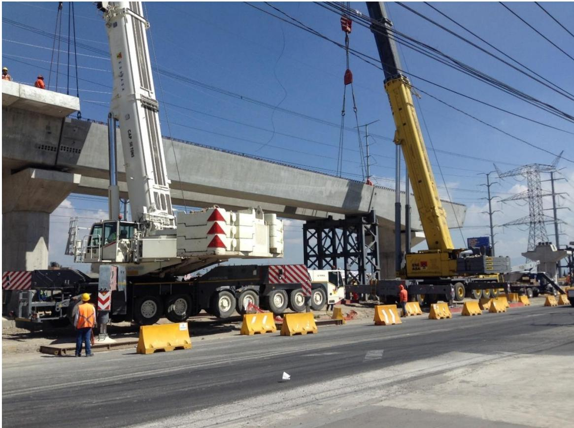
Imagen 4.49. Montaje de trabe tipo 2
