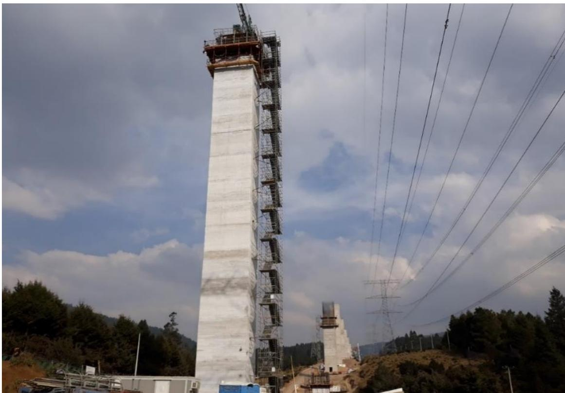
Imagen 4.18. Columna 12 del viaducto 4 altura 54 m
