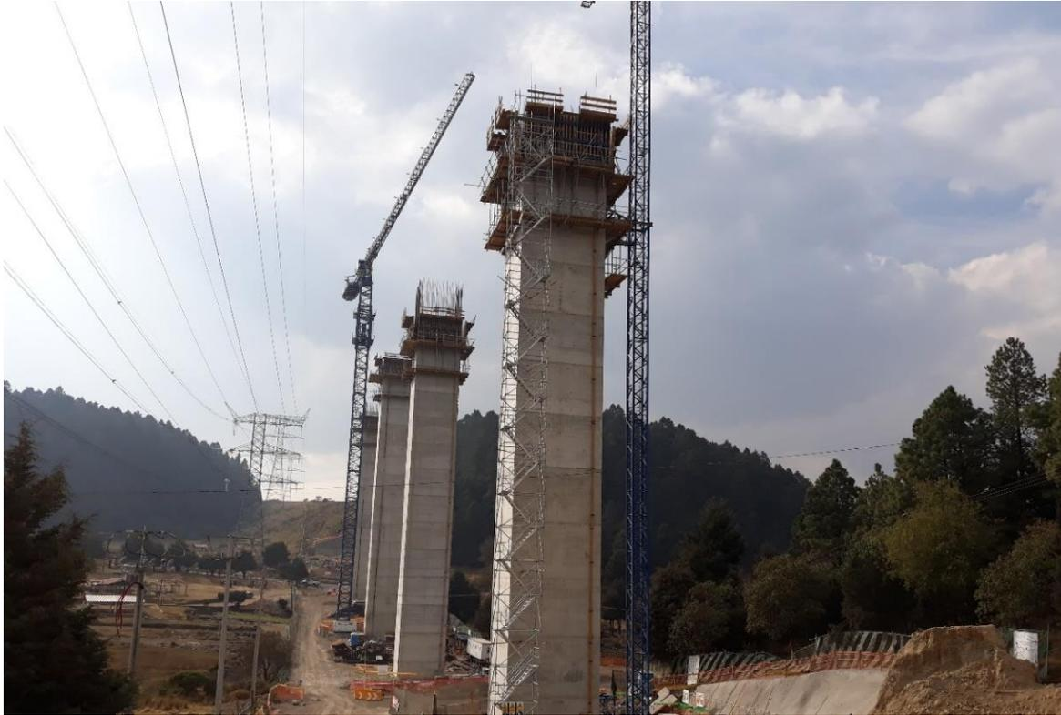
Imagen 4.7. Columnas con cimbra trepante y grúas torre viaducto 4 tramo 1
