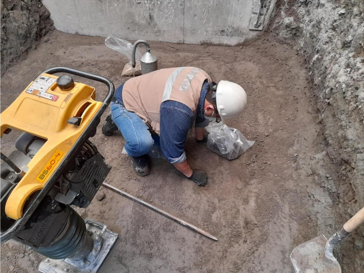
Imagen 5. 40 Revisión de compactación por parte de personal de control de calidad en rellenos con suelo cemento.
