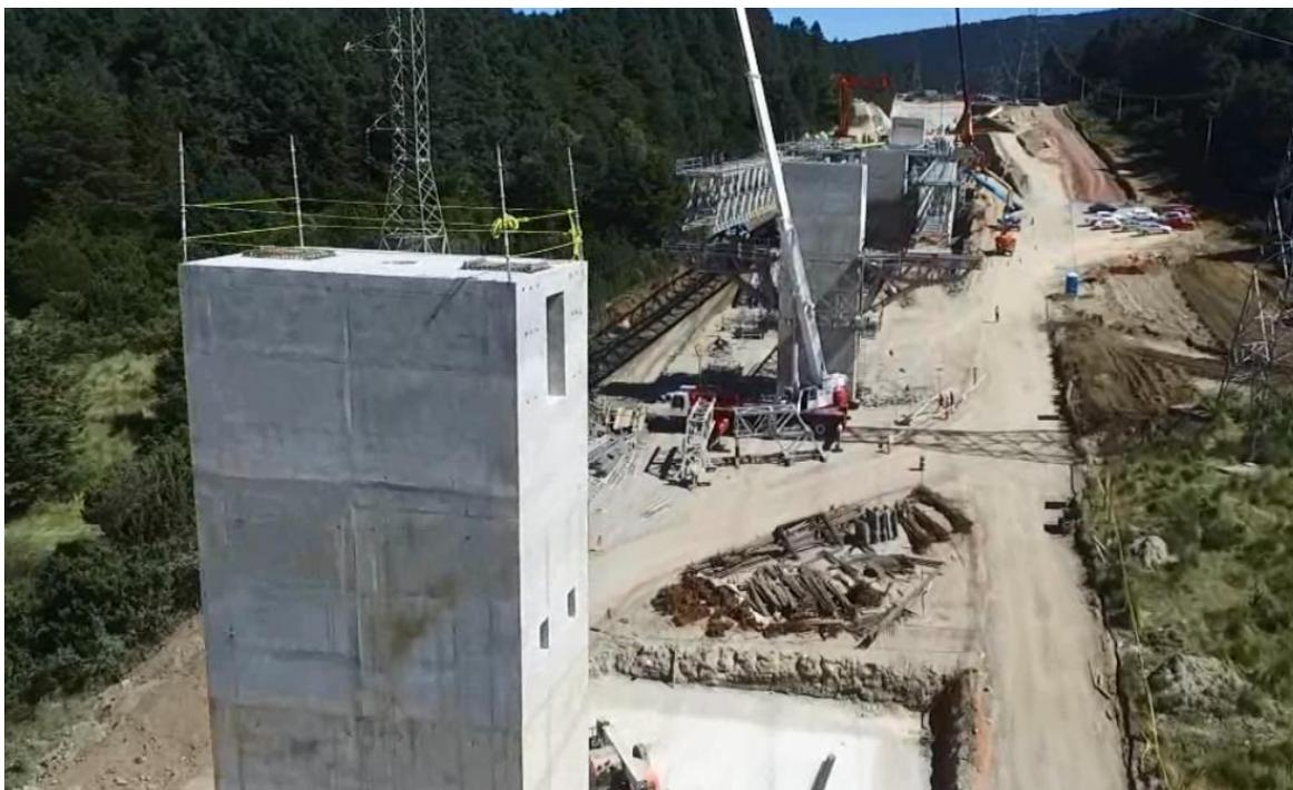
Imagen 4.38. Cabezal terminado viaducto 4
