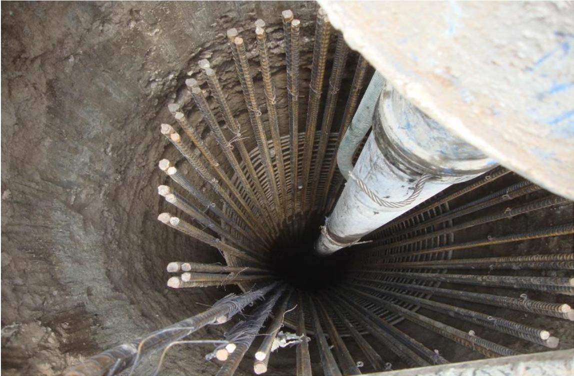
Imagen 3.8. Colocación de tubería Tremie.
