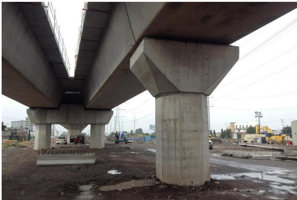
Imagen 4.21. Cabezal de vía única en la entrada y salida de estaciones.
