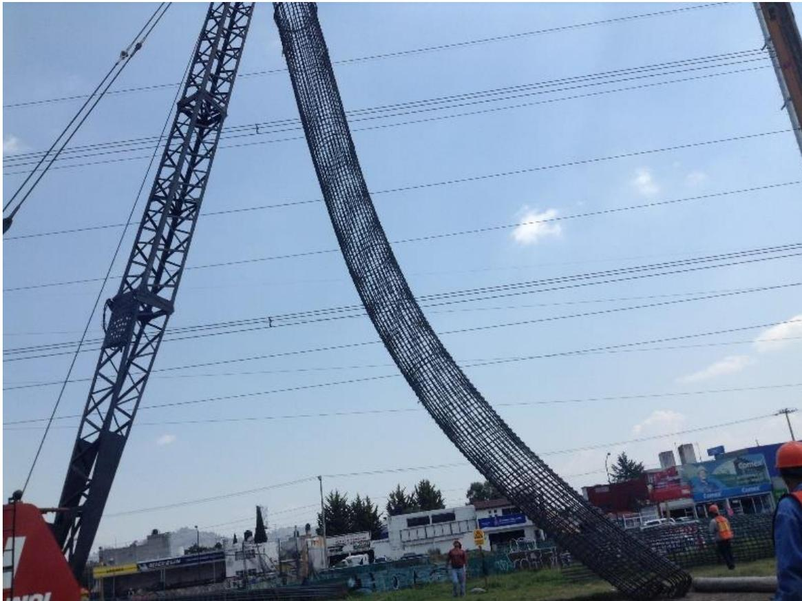
Imagen 3.5. Izaje de la primera sección del armado
