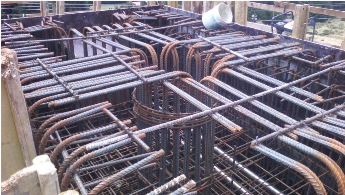
Imagen 4.35. Armado de refuerzo con ductos para el paso de barras de alta resistencia que sostienen los topes antisísmicos laterales
