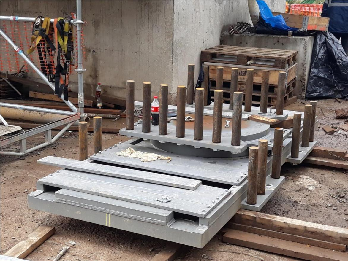
Imagen 5.26 Apoyo esférico antes de colocar
