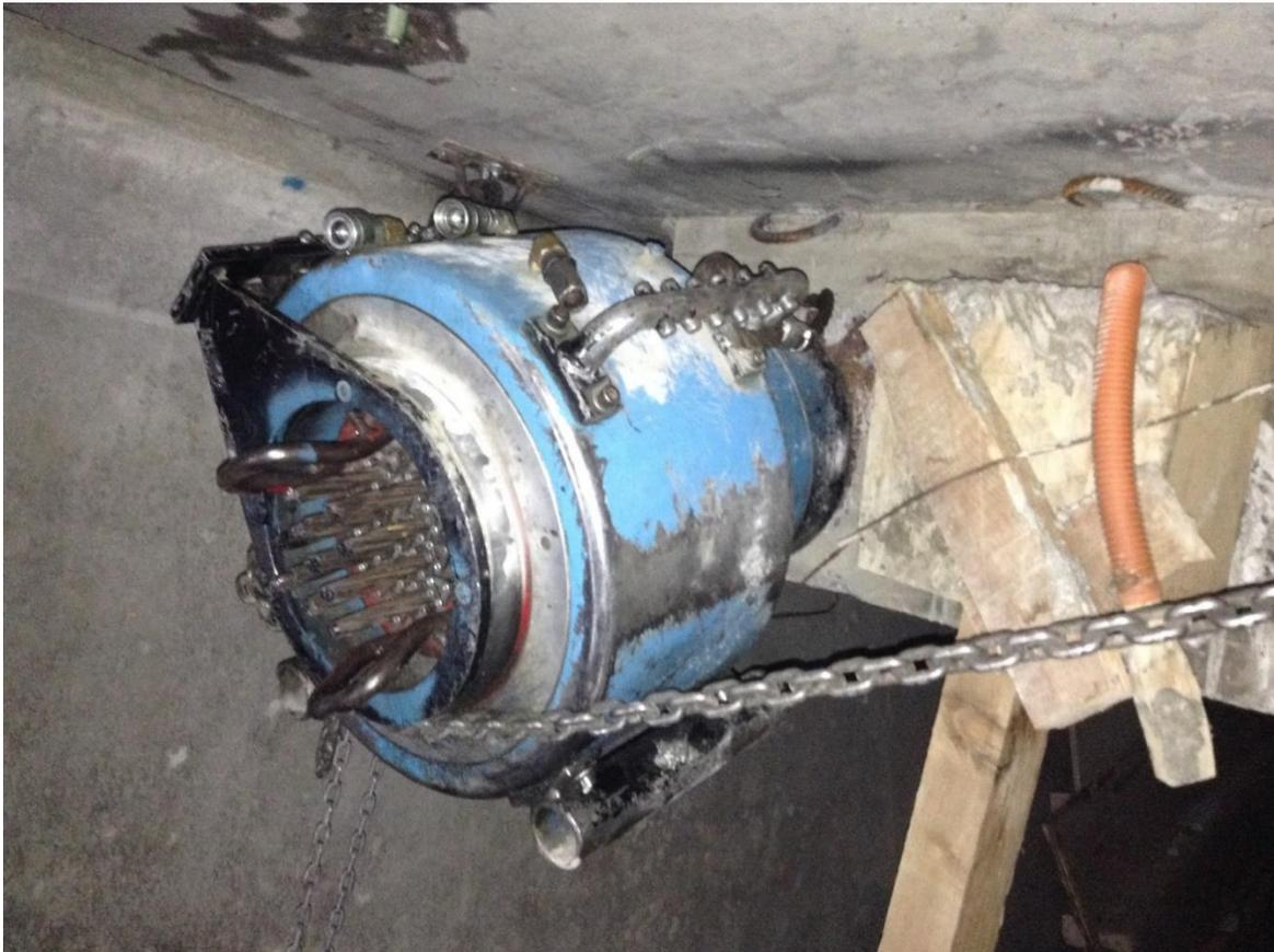
Imagen 4.60. Gato hidráulico multitorón
