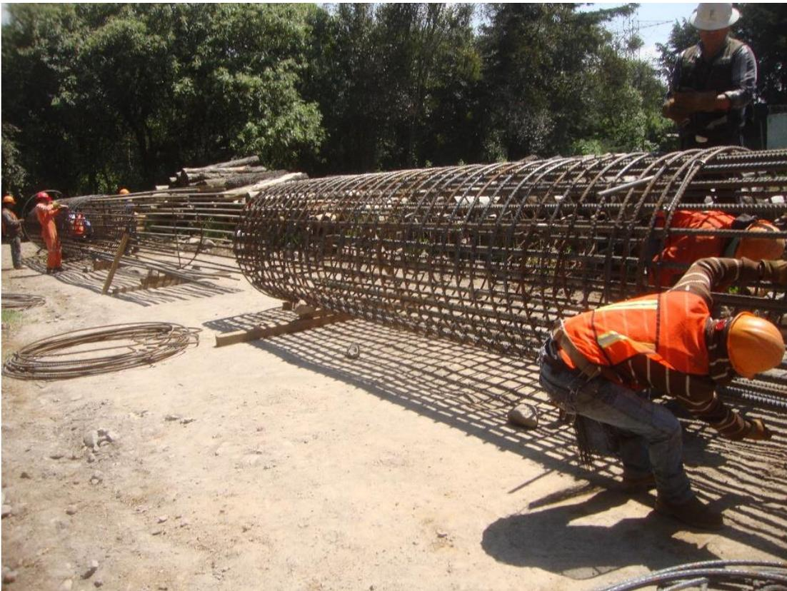
Imagen 3.4 Armado de pila de cimentación.
