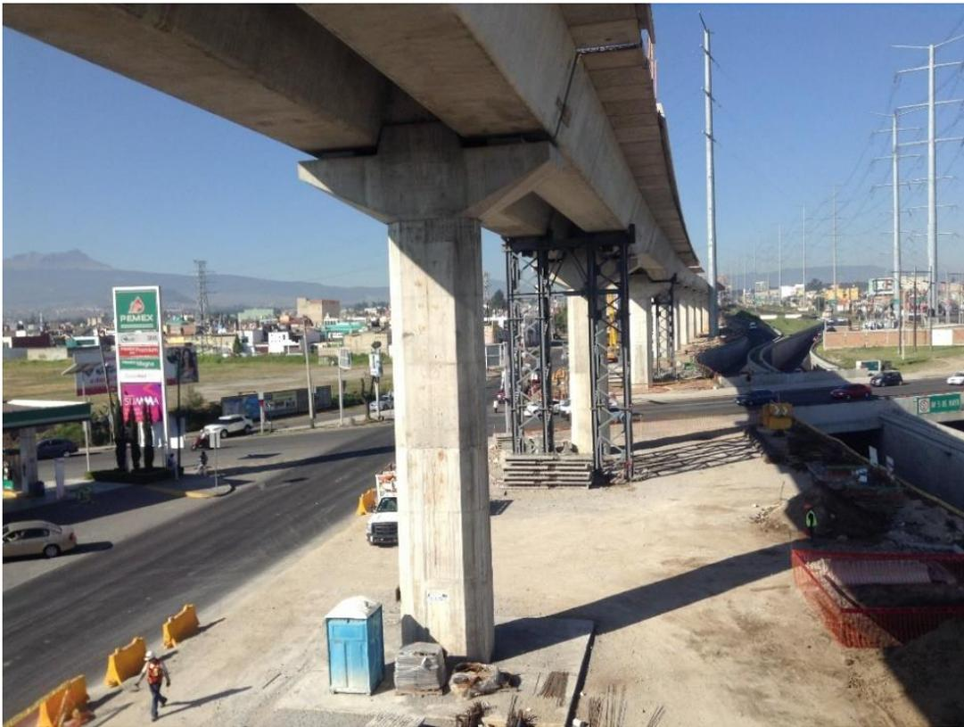
Imagen 4.19. Cabezal de vía doble utilizado en la mayoría de los apoyos con traveses prefabricadas con tope de restricción longitudinal en los aleros
