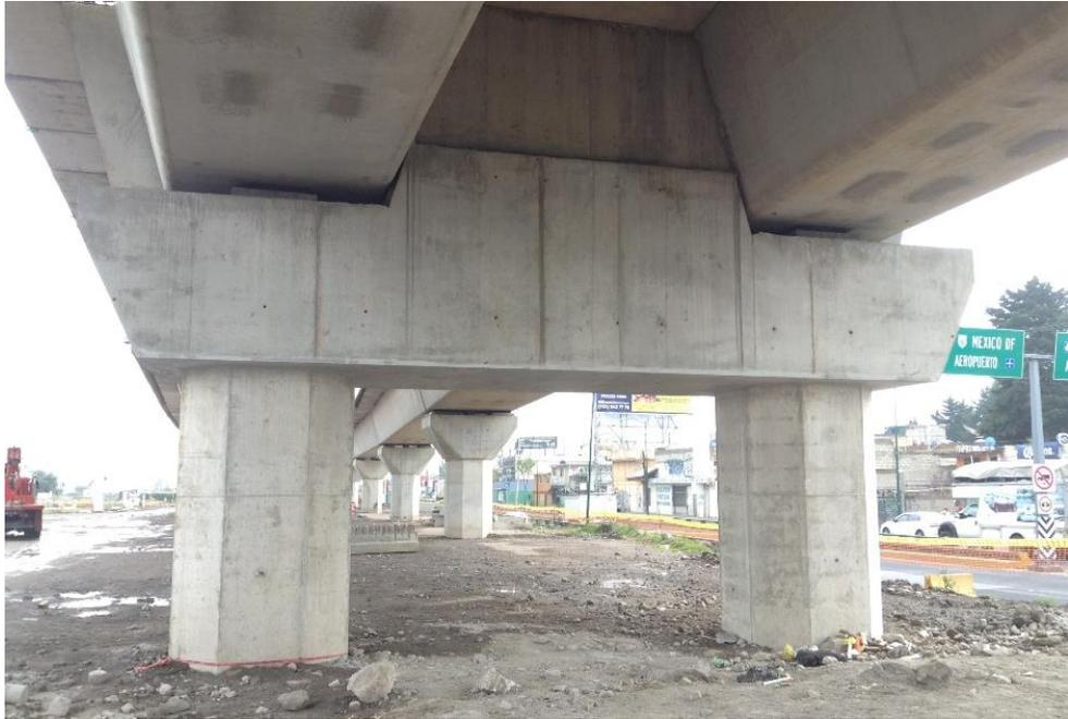
Imagen 4.22. Cabezal de transición de vía única a vía doble.
