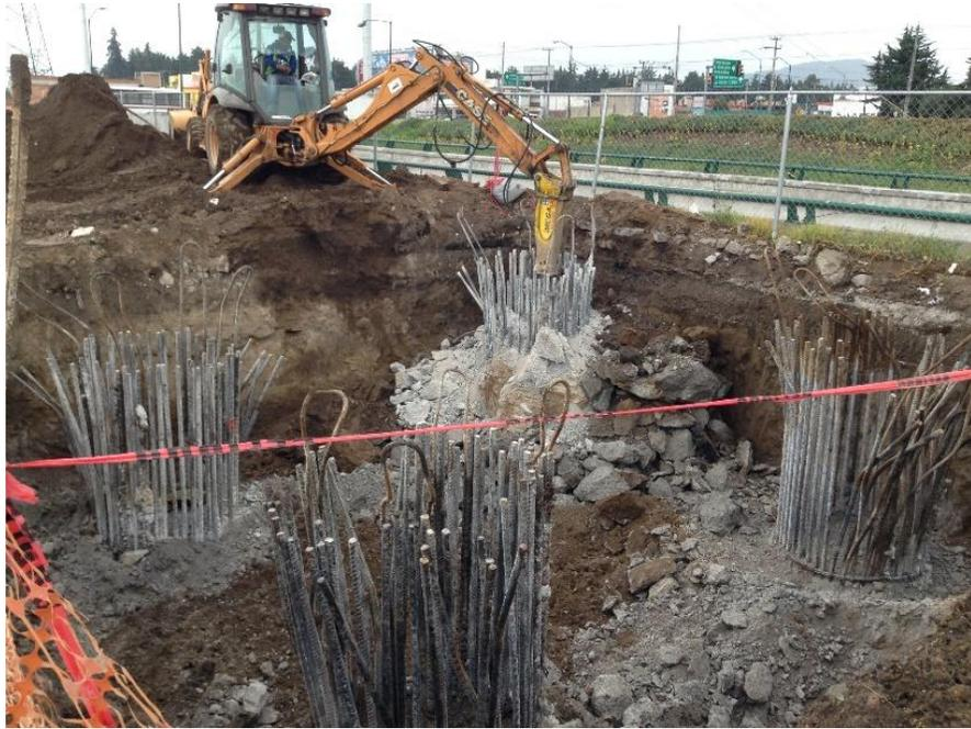
Imagen 3.11. Descabece de pilas con rotomartillo hidráulico
