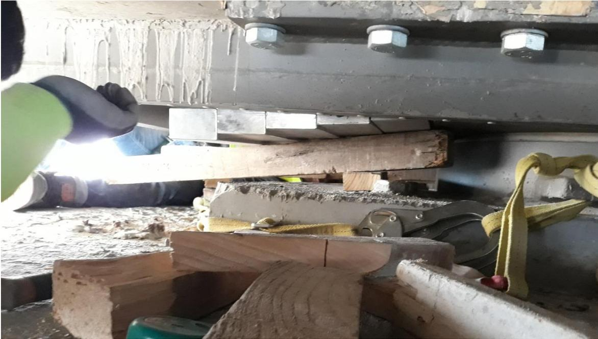
Imagen 5.28 Colocación de barras de bloqueo de apoyo esférico
