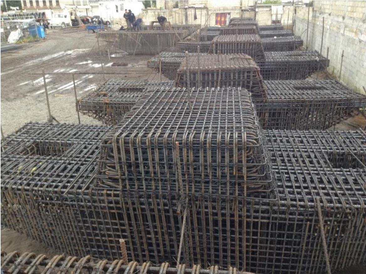
Imagen 4.26. Armados prefabricados para cabezal
