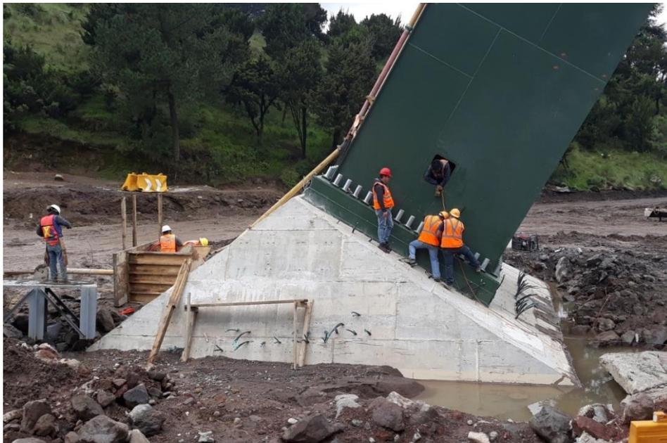
Imagen 5.18. Tensado de barras con cimentación colada
