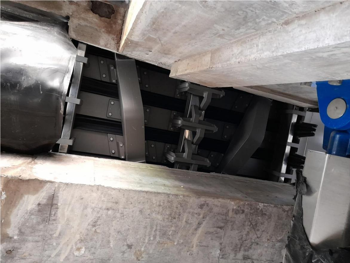
Imagen 5.33 vista de junta de largo recorrido ya instalada desde la cámara de amortiguadores.
