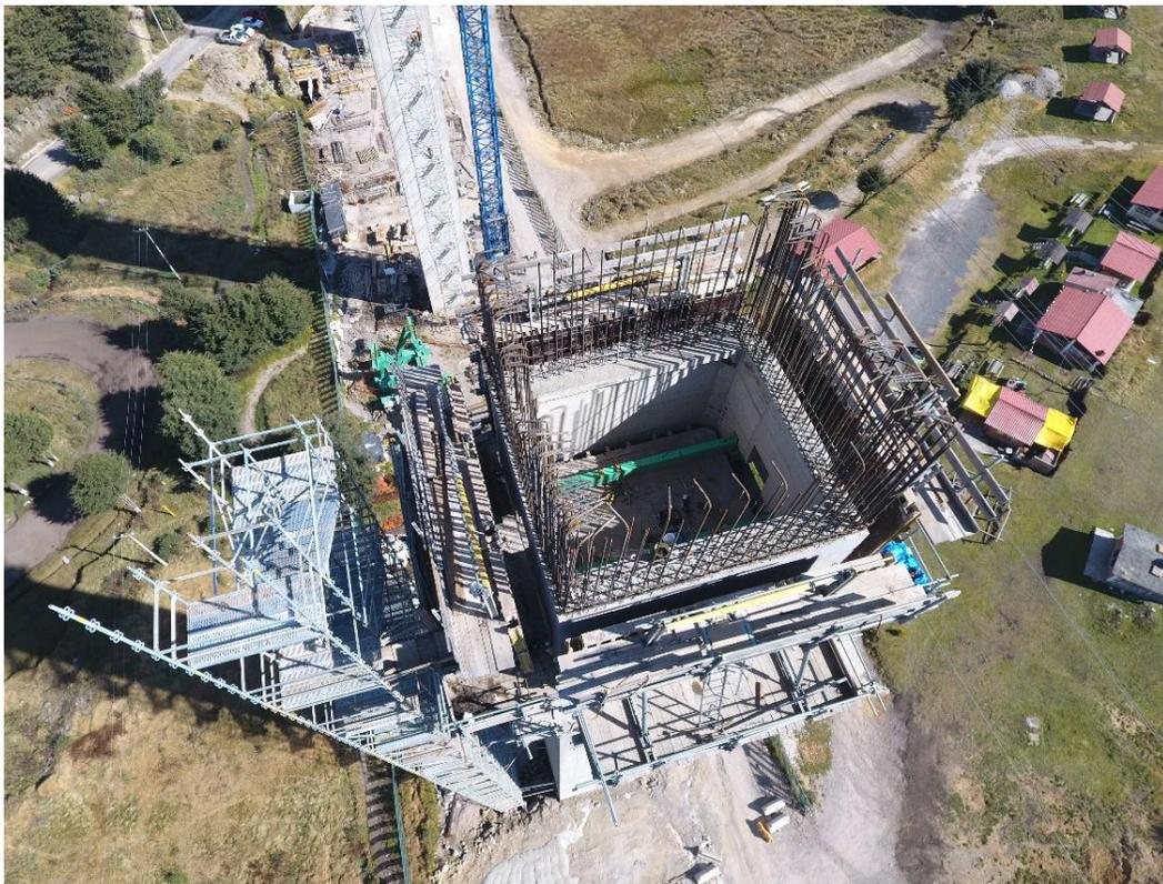
Imagen 4.11. Columnas con cimbra trepante viaducto 4 tramo 1
