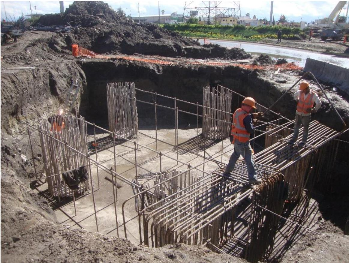
Imagen 3.23. Zapata de cimentación de forma pentagonal
