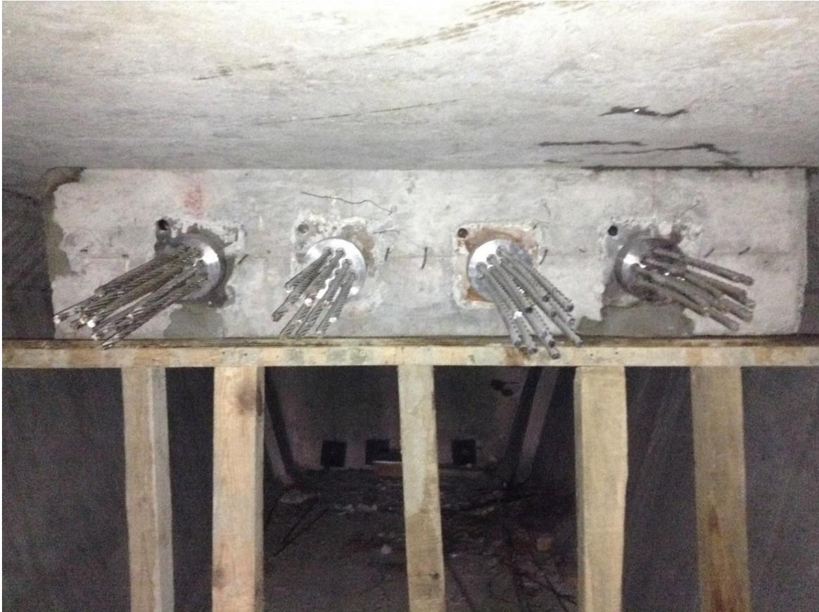
Imagen 4.61. Tendones de losa tensados
