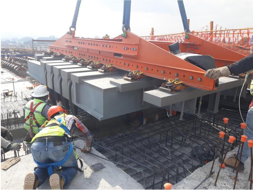
Imagen 5.32 Colocación de Junta de largo recorrido
