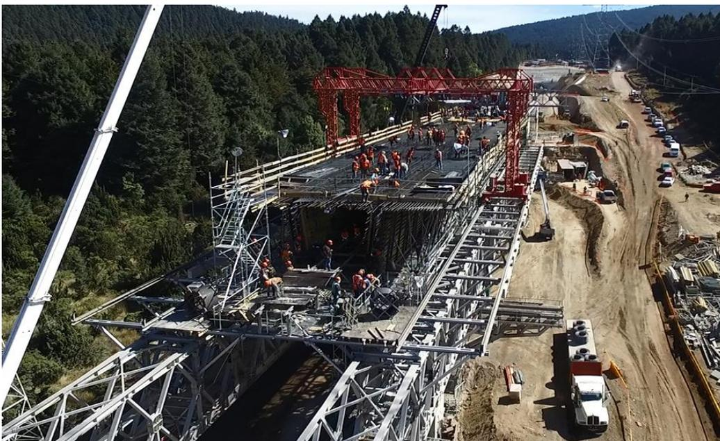
Imagen 4.86. Armado de tablero en vano siguiente.
