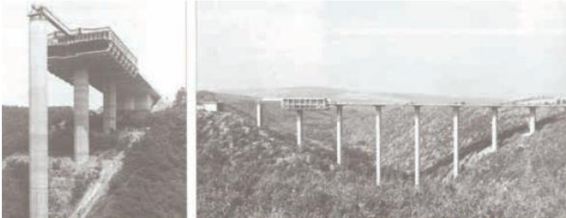
Imagen 4.67. Viaducto de Eitzal (Alemania) de Ulrich Finsterwalder 37.5 m de claro tablero tipo losa postensada de sección variable 1966
