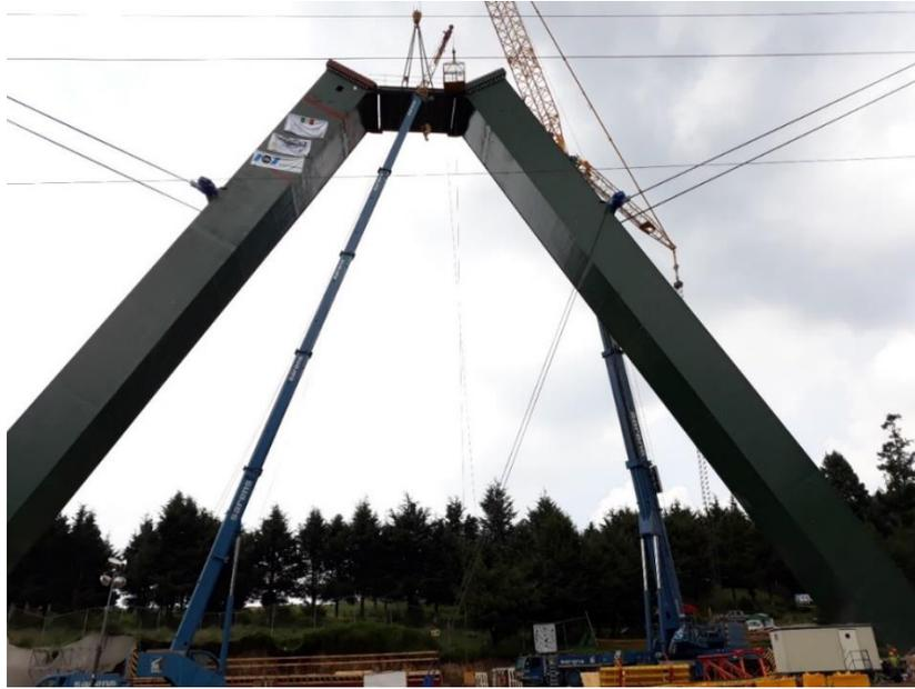
Imagen 5.19. Colocación de puntal de compresión para retiro de cables.
