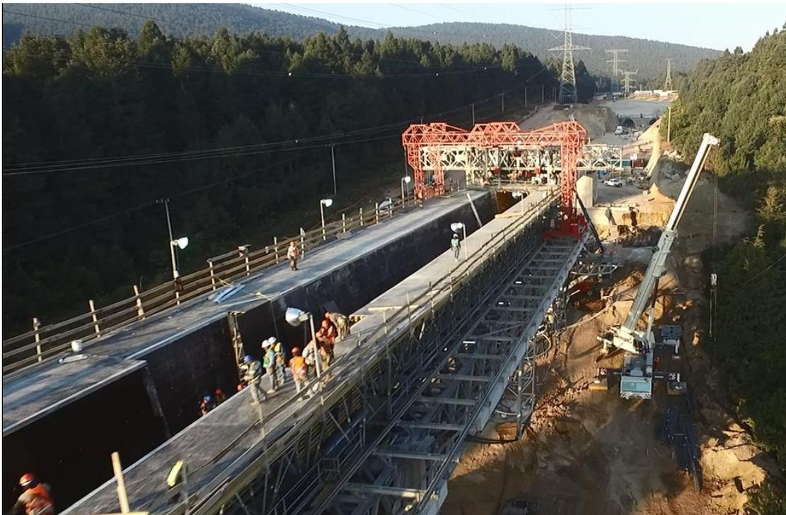
Imagen 4.85. Limpieza de encofrado exterior.
