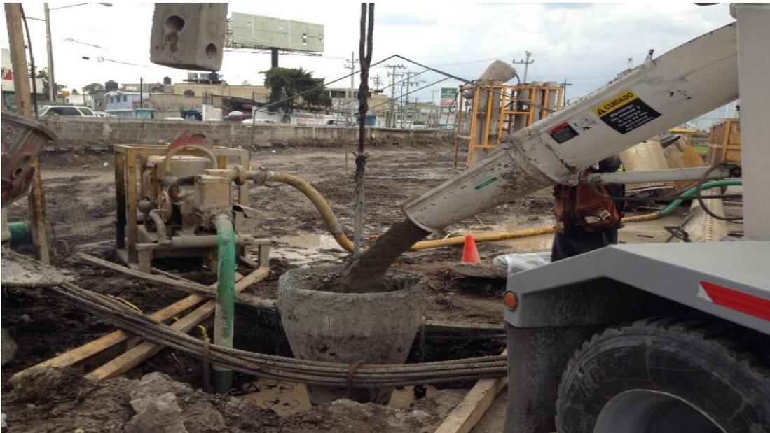
Imagen 3.9. Vaciado de concreto en pila de cimentación
