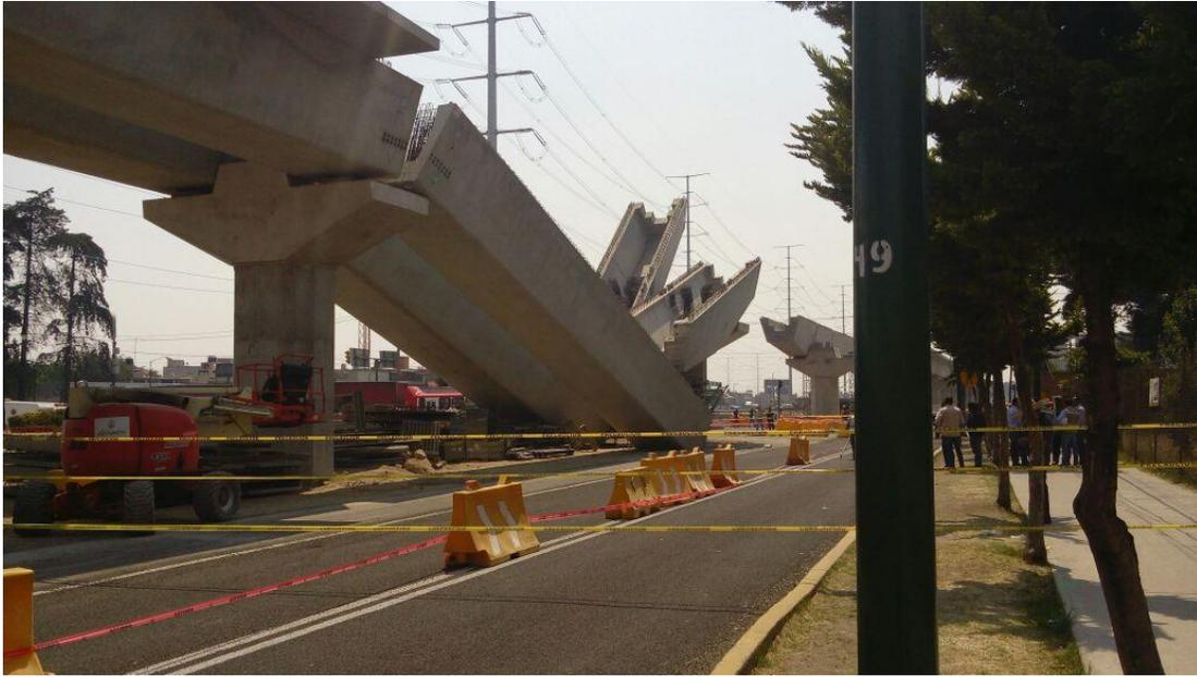
Imagen 6.7 Colapso de apeo provisional en apoyo 118 del viaducto 1B
