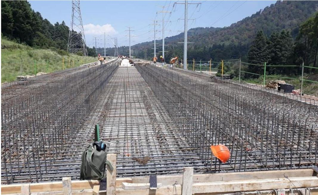
Imagen 4.63. Armado de acero de refuerzo de losa de claro isostático
