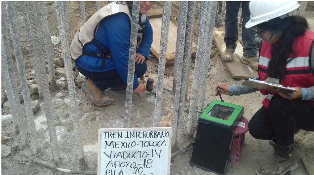
Imagen 3.12.1 pruebas PIT en pilas de cimentación.
