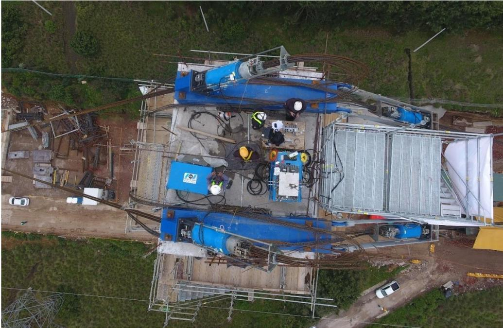
imagen 5.11. Sistema de izaje de columnas en delta
