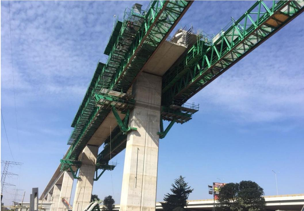
Imagen 4.87. Cimbra autolanzable bajo tablero marca Mecanotubo.
