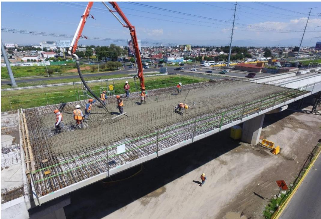
Imagen 4.64. Colado de losa de claro isostático 32 m
