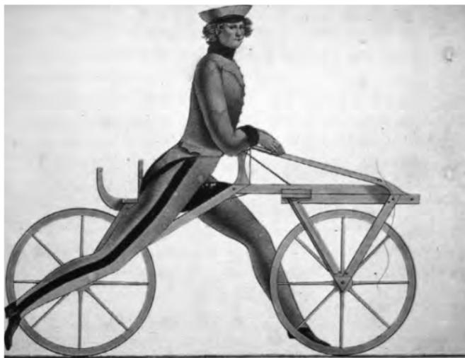
Figura 2.2: Folleto de 1817 donde Drais destaca las ventajas de su máquina de correr, mostrando a un correo militar en un velocípedo. Imagen tomada de [11].
